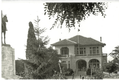
Şekil 5.21. CHP İl Yön Kurul Binası, 1930’lar (Bursa Kent Müzesi Arşivi)
