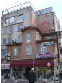
Şekil 5.56. 5312 no'lu ada 1 no'lu parseldeki ruhsatsız bina (Sibel Polat Arşivi)
