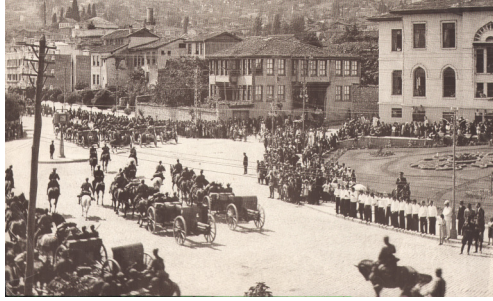
Şekil 5.30. Gazi Paşa Caddesi güney cephesi, (doğuya bakış) (Bursa Kent Müzesi Arşivi)
