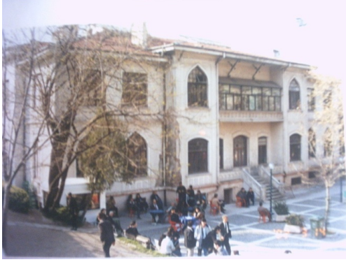
Şekil 5.79. Adliye Binası, 1990'lar (Bursa Koruma Kurulu Arşivi)
