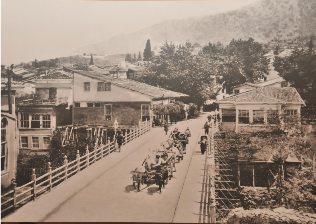
Fotoğraf 3.37. Setbaşı Köprüsü - Bursa
