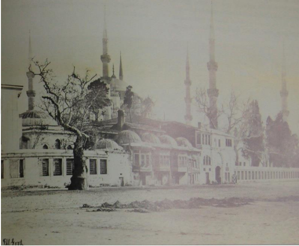
Fotoğraf 2.3. Sultanahmet Camii. Frank Mason Good, albümin baskı, 1871.
