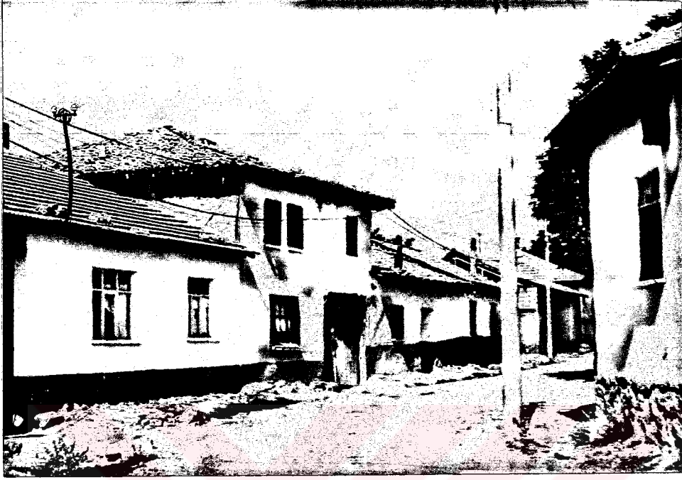
Şekil 4.7. Kerpiçten yapılmış konut örneği
