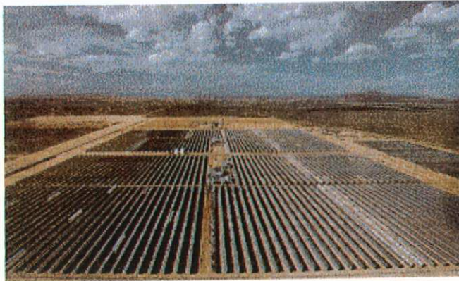
Fotoğraf 3.1: 350 MW gücünde parabolik oluk güneş santrali (Kaliforniya)
