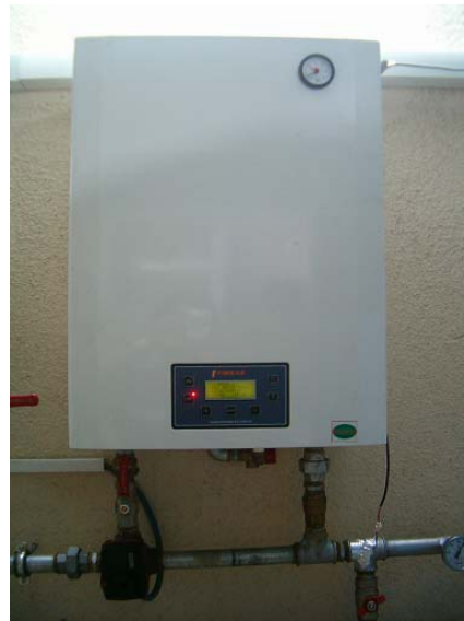
Şekil 3.33. Elektrikli ısıtıcı
