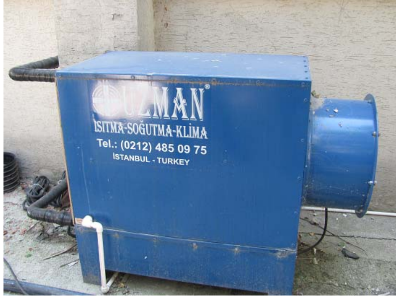
Şekil 3.26. Deney tesisatında kullanılan soğutma kulesi
