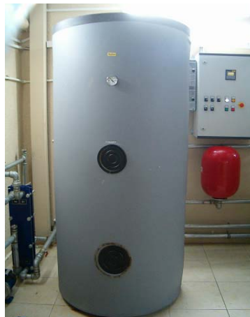
řekil 3.32. Sıcak kullanım suyu boyleri
