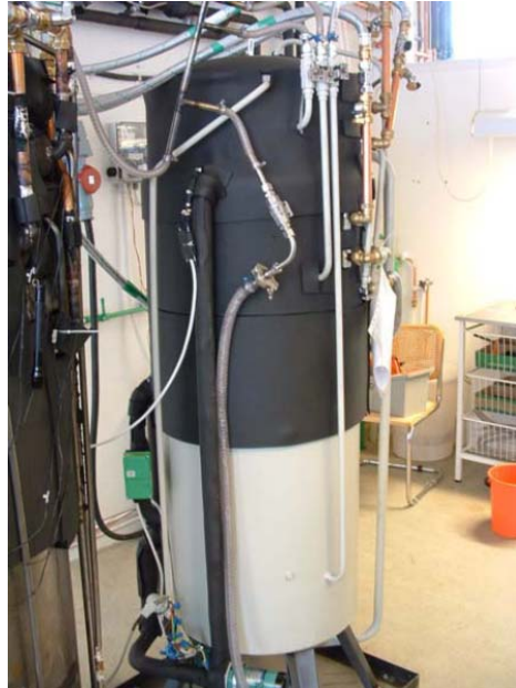
Şekil 3.8. Absorbsiyonlu cihazın hazne ve bağlantılarının görünümü
