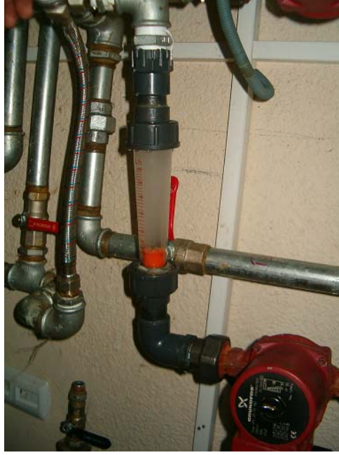
Şekil 3.31. Pompa debi ölçüm işlemi
