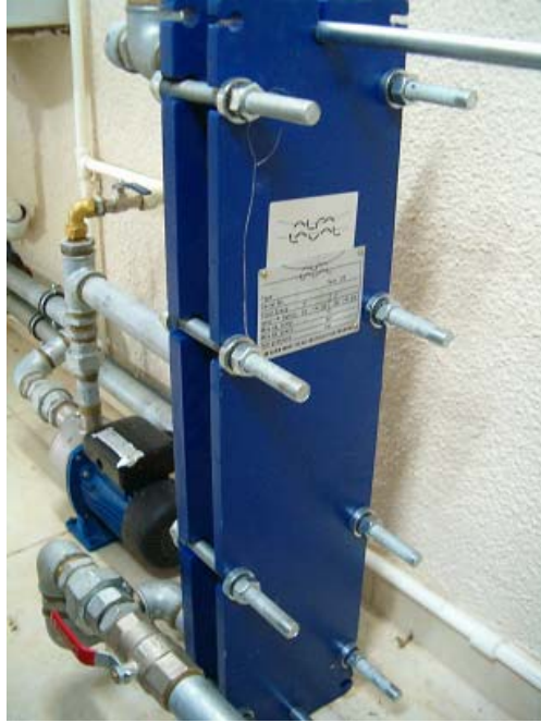
Şekil 3.27. Isı atım hattında kullanılan plakalı ısı deęiřtiricisi
