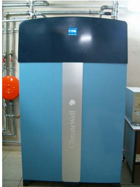
Şekil 3.5. Absorpsiyonlu ısı pompasının genel görünümü
