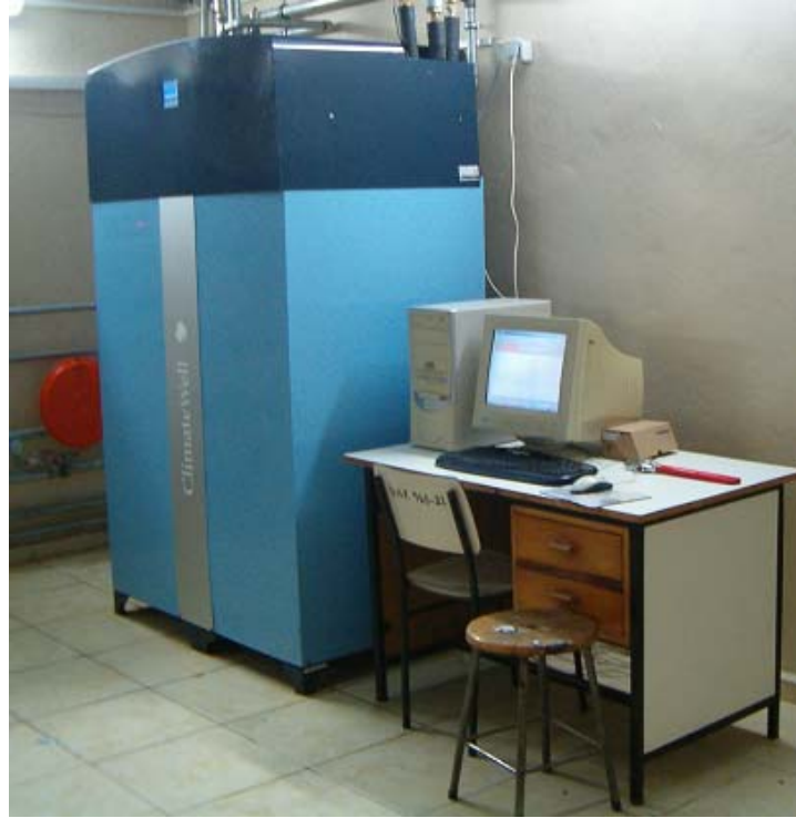
Şekil 3.37. Absorbsiyonlu cihazın bilgisayar destekli veri ölçümü
