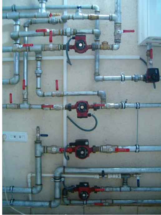
Şekil 3.30. Dolaşım hatları pompaları
