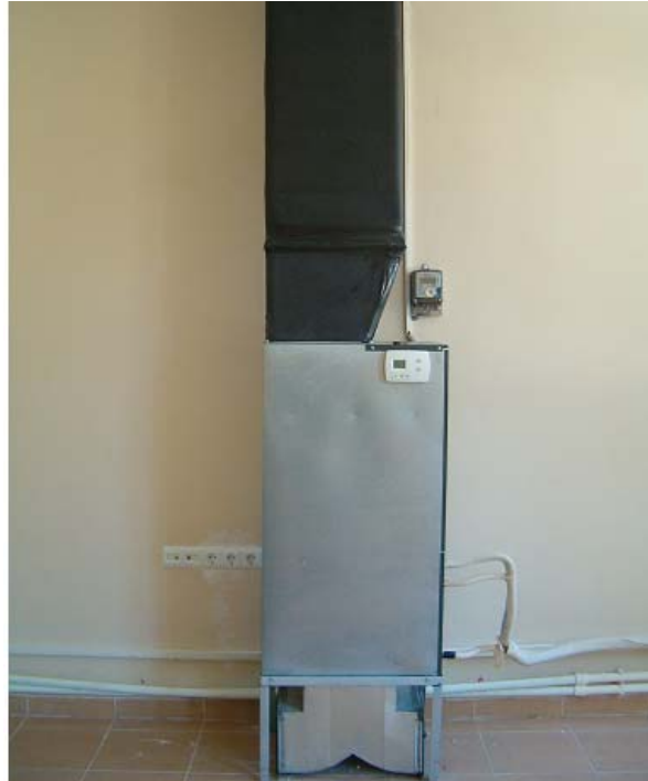
řekil 3.34. Hava kaynaklı ısı pompası
