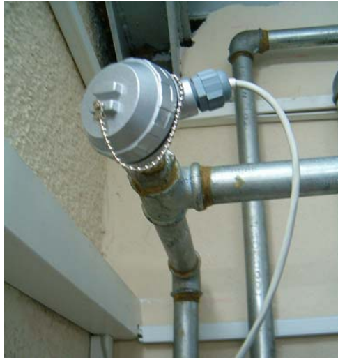
Şekil 3.35. PT 100 sıcaklık sensörü
