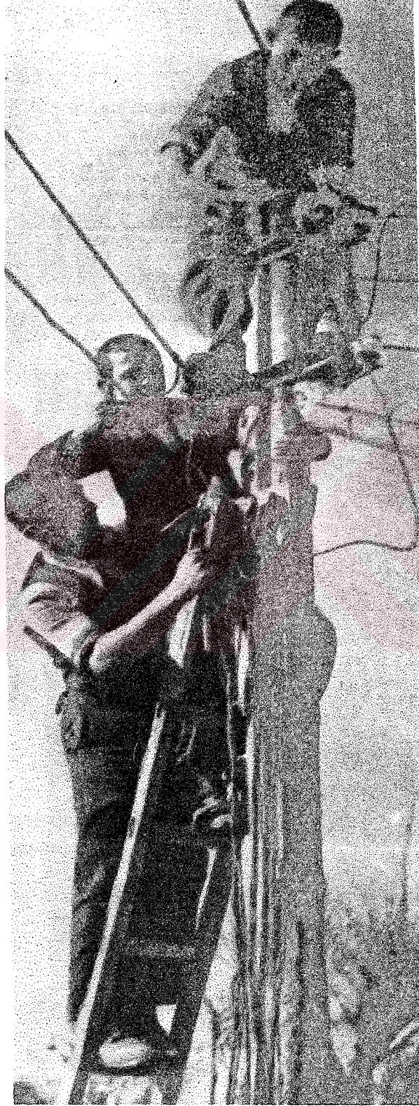
Elektrik tesisatını kurmaya çalıřan öğrenciler.
