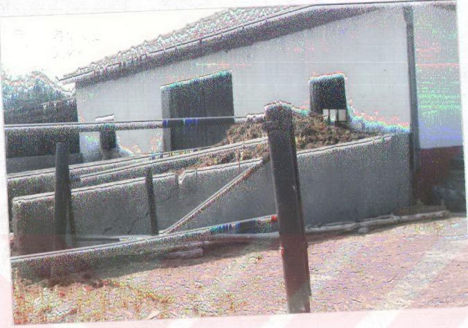
Şekil 4.16 Ahır dışında gübrenin birikme şekli ve gübre çıkış açıklıkları ( Fuat SARI işi.)
