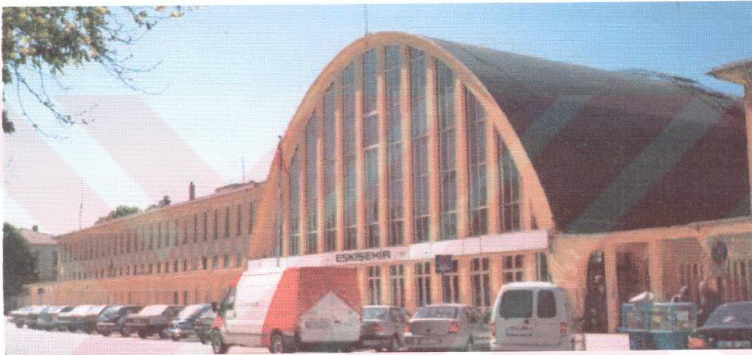
Şekil 3.91. Eskişehir Gar Binası (04.05.2002)
