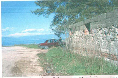
Şekil 3.116. Yörükali İstasyon Binası'nın Marmara Denizi'ne göre konumu
