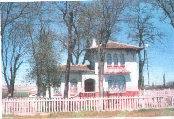
Şekil 3.103. Çukurhisar İstasyonu lojman binası (04.05.2002)
