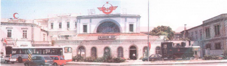
Şekil 3.88. Alsancak Gar Binası giriş cephesi (27.08.2002)
