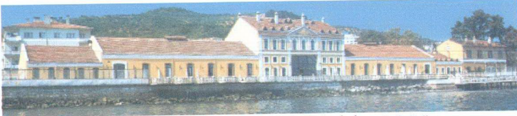
Şekil 3.118. Mudanya Gar Binası'nın (Montania Otel) denizden görünüşü (Montania Otel arşivinden)
