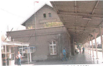
Şekil 3.102. Balıkesir İstasyonu tren sundurması (27.08.2002)
