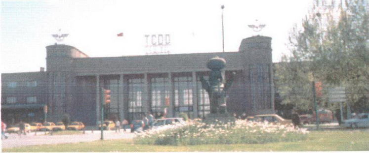
Şekil 3.96. Ankara Gar Binası (05.05.2002)
