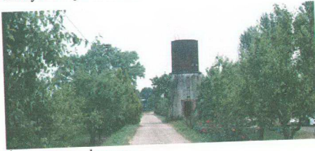
Şekil 3.115. Koru İstasyonu su deposu
