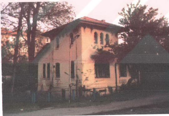
Şekil 3.104. Polatlı İstasyonu lojman binası (04.05.2002)
