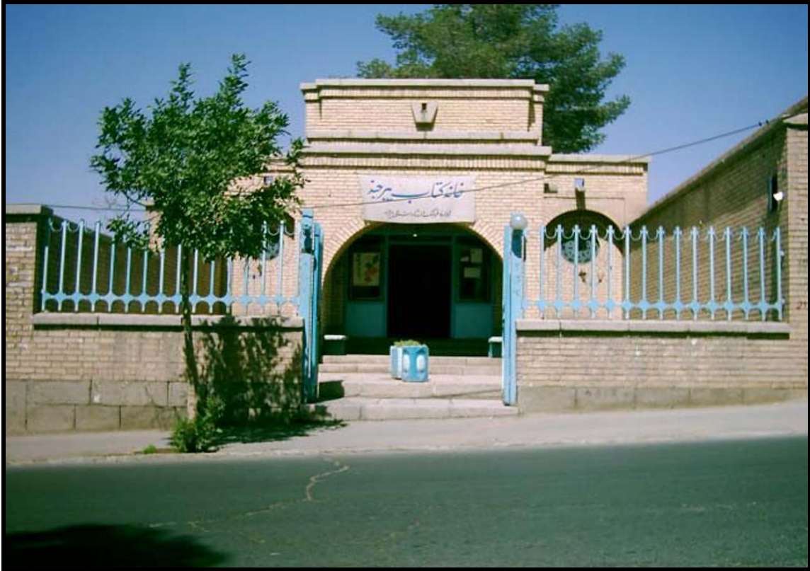
Nizârî'nin Aynı Zamanda Kütüphane ve Kültürevi Olarak Kullanılan Türbesinin Bulunduğu Binanın Girişi
