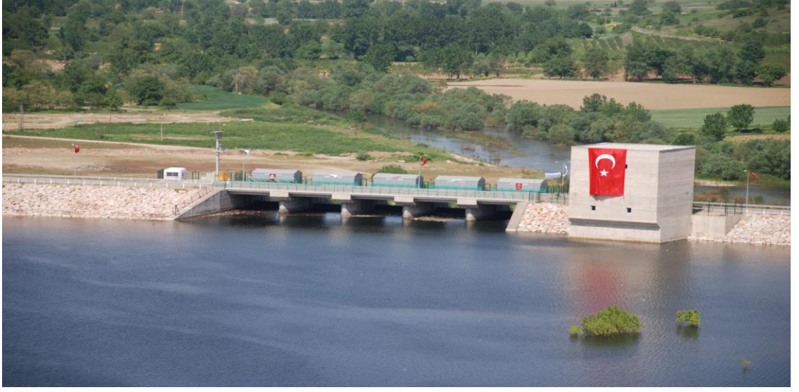
Şekil 3.4. Boğazköy Barajı'nın genel görünümü
