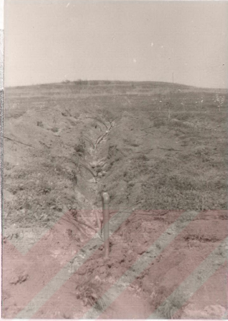
Şekil 4.13. İki yönde çalışan bir ikincil ana boru hattı (Nurova Çiftliği).
