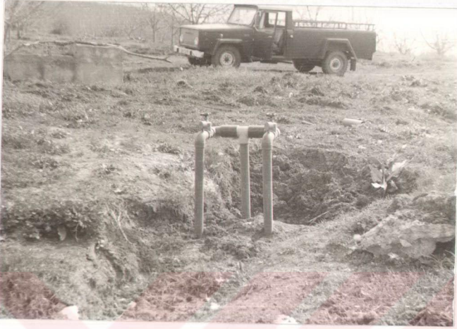
Şekil 4.10. Bir ikinoil ana boru girişi ve basınç düzenleyicileri (Nurova Çiftliği).
