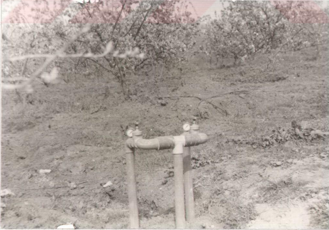
Şekil 4.7. Ücincil ana boru basıncını düzenlemek için konmuş manometre-vana (Nurova çiftliği).
