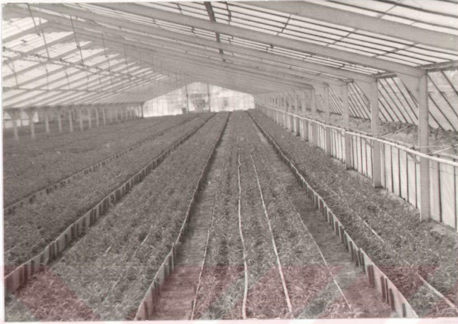
Şekil 4.15. Her tavada iki yan borunun yerleştirildiği durum (Yalova Çiçekçilik Kooperatifi).
