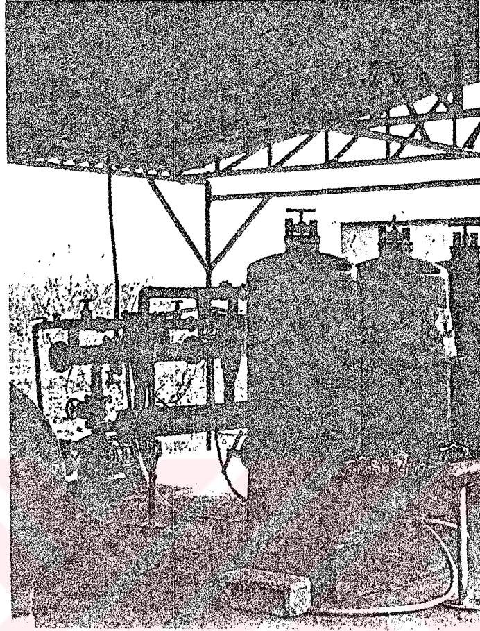
Şekil 4.4. Denetim Birimi ve Kum-Çakıl Süzgeç (Taşköprü Çiftliği).
