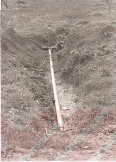
Şekil 4.9. Birincil ana boru hattının toprak altına gömülü olarak serilişi (Nurova Çiftliği).
