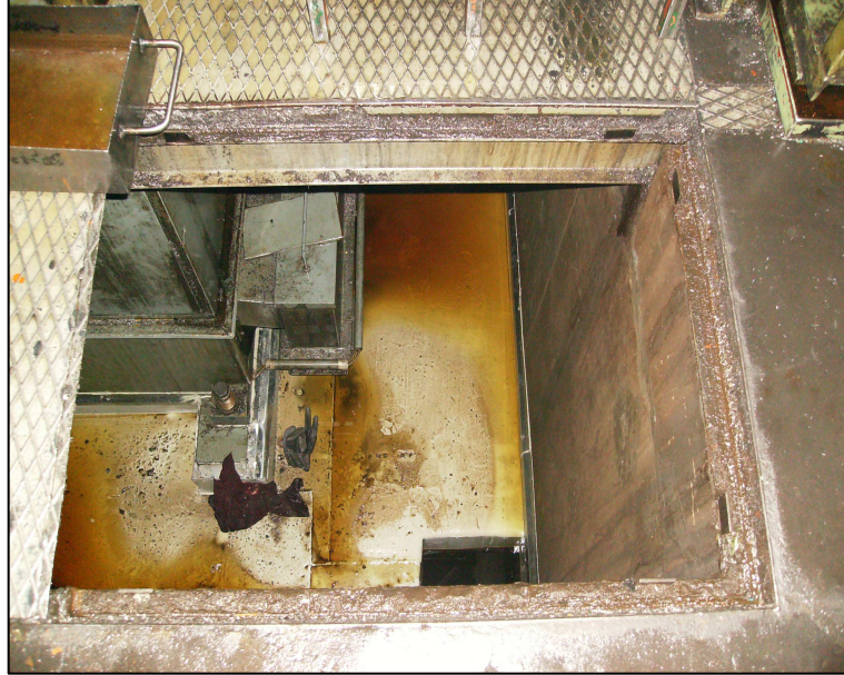
Şekil 4.3. Sodyum hidroksit çukuru sızdırmazlık çalışması öncesi durumu
