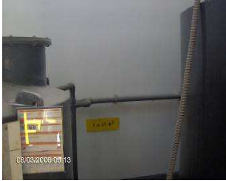
Şekil 4.11. 1 tonluk su tankının cidar iyileştirme çalışması
