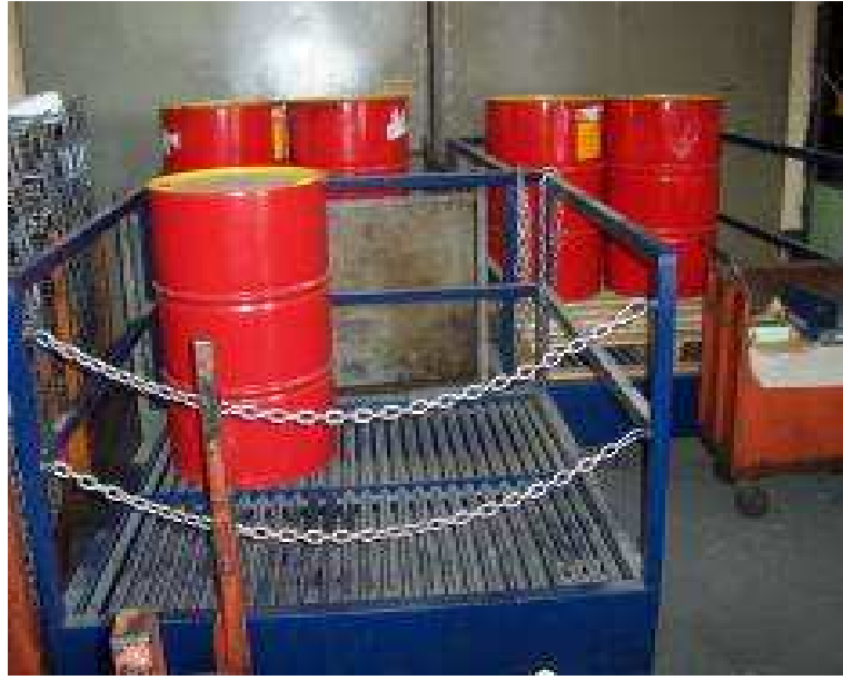
Şekil 4.7. Yağ depolama bölgesinde tutma havuzu yapımı
