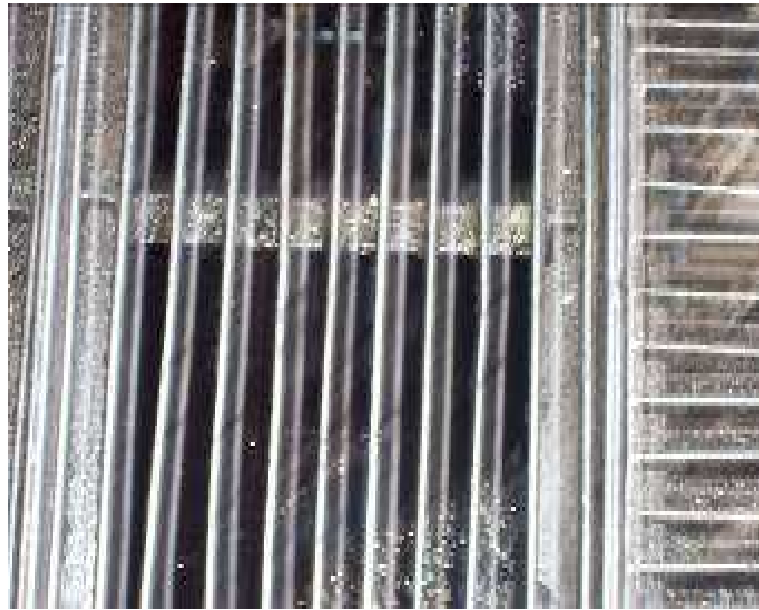
Şekil 4.4. Boyahane kanalizasyon ve çukurlar bölgesinde ızgara yapımı
