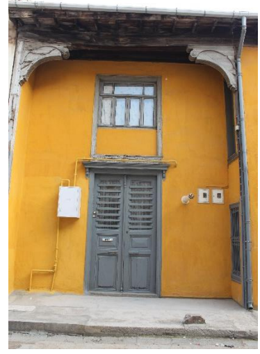
Şekil 289: K-33 Giriş Kapısı
