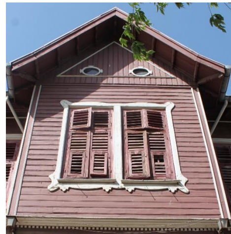
Şekil 297: K-34 Dış Cepheden Kapalı Cumba
