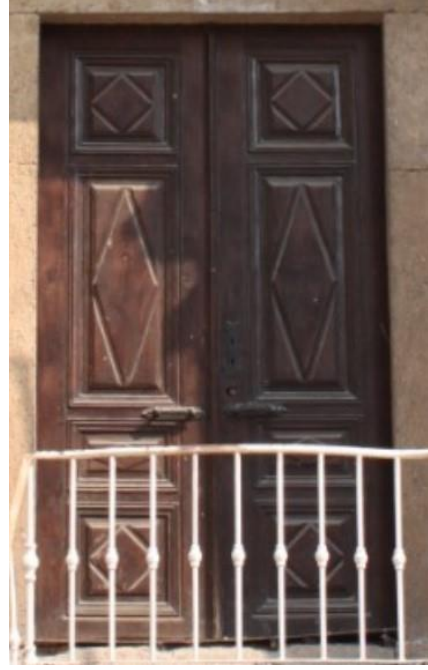
Şekil 24: Kaleiçi Evlerinden Geometrik Desenli Kapı Örneği
