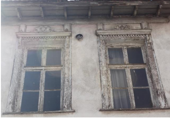
Şekil 345: K-43 Giriş Cephesi Pencere Örneği
