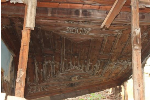
Şekil 242: K-24 Giriş Kat Ahşap Tavandan Görünüm
