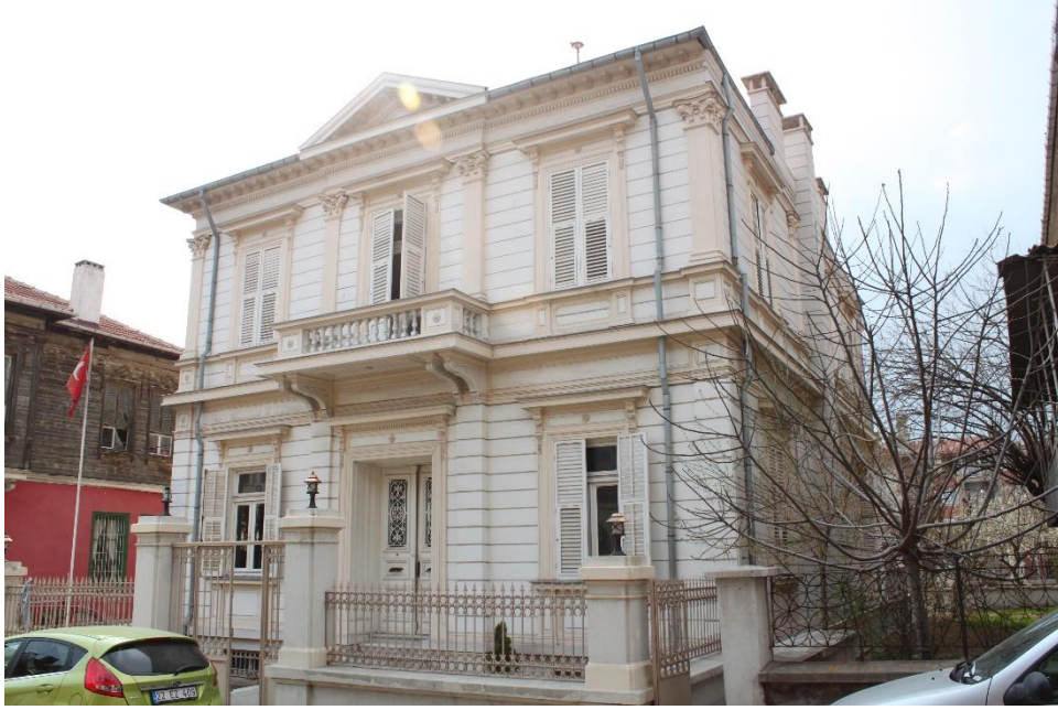
Şekil 9: Kaleiçi Evlerinden Cephe Örneği
