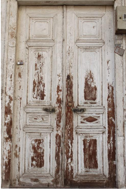
Şekil 25: Kaleiçi Evlerinden Geometrik Desenli Kapı Örneği
