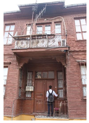
Şekil 277: K-30-31 Giriş Kapısı
