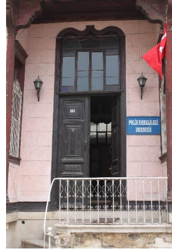
Şekil 231: K-21 Giriş Kapısı
