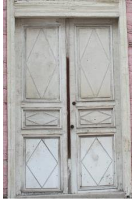
Şekil 26: Kaleiçi Evlerinden Geometrik Desenli Kapı Örneği
