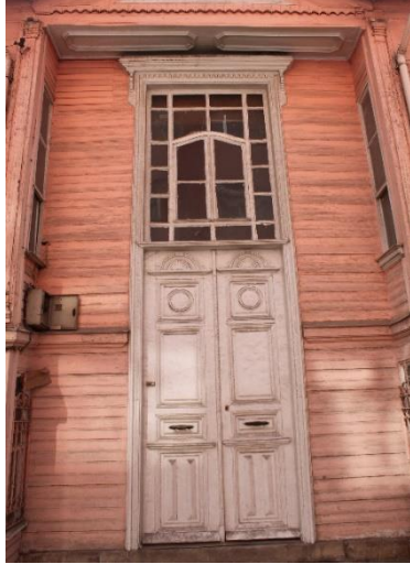
Şekil 328: K-40 Giriş Kapısı
