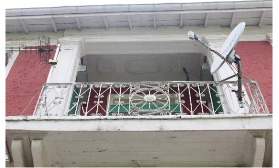
Şekil 263: K-27 Dış Cephe Balkondan Görünüm
