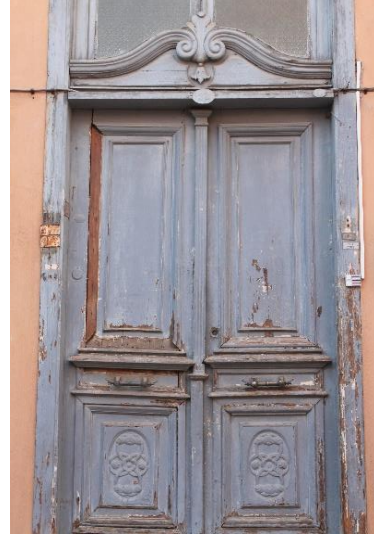
Şekil 361: K-46 Giriş Kapısı
