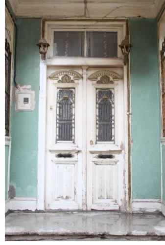
Şekil 350: K-44 Giriş Kapısı
