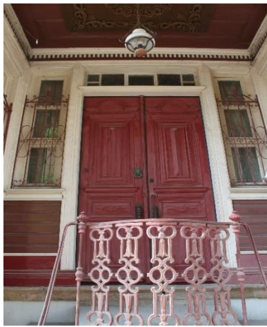
Şekil 296: K-34 Giriş Kapısı
