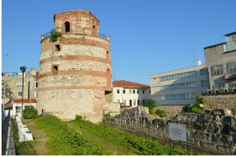
Şekil 1: Edirne Sur Duvarları Ve Makedonya Kulesi
