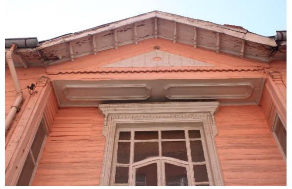
Şekil 327: K-40 Giriş Cephesi Üçgen Alınlık
