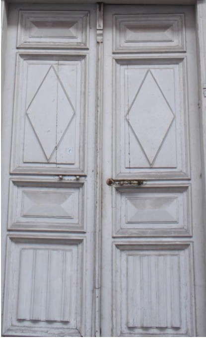
Şekil 23: Kaleiçi Evlerinden Geometrik Desenli Kapı Örneği
