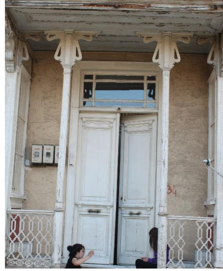
Şekil 367: K-47 Giriş Kapısı
