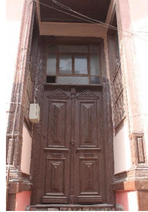
Şekil 271: K-29 Giriş Kapısı
