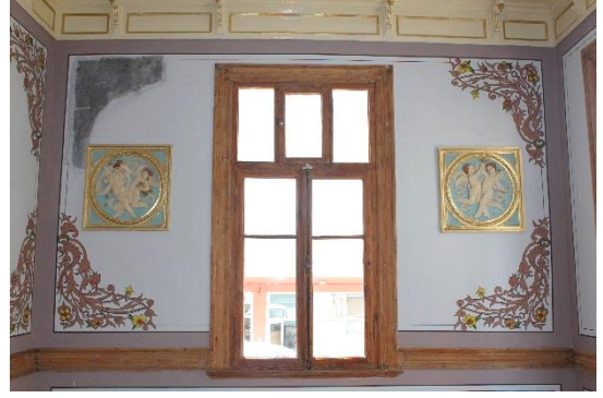
Şekil 142: K-2 Kalem İşi Tezyinatlar
