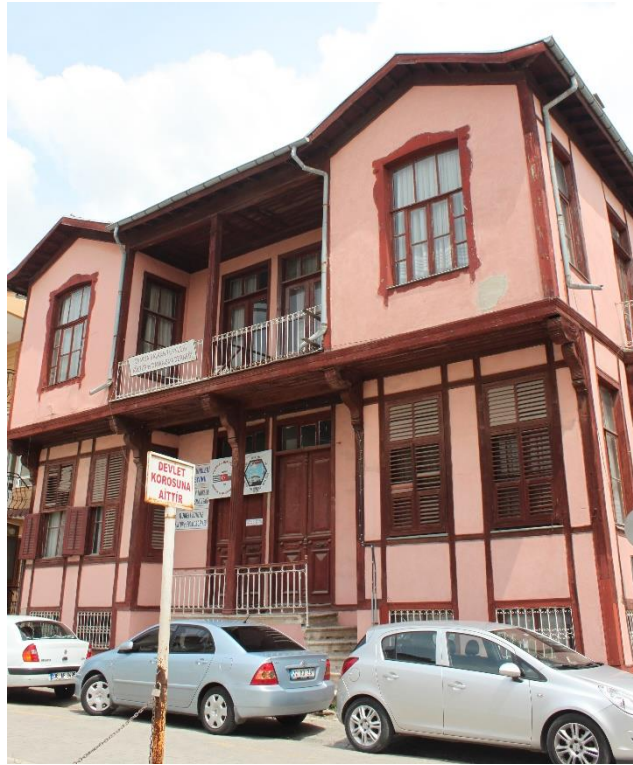
Şekil 10: Kaleiçi Evlerinden Cephe Örneği
