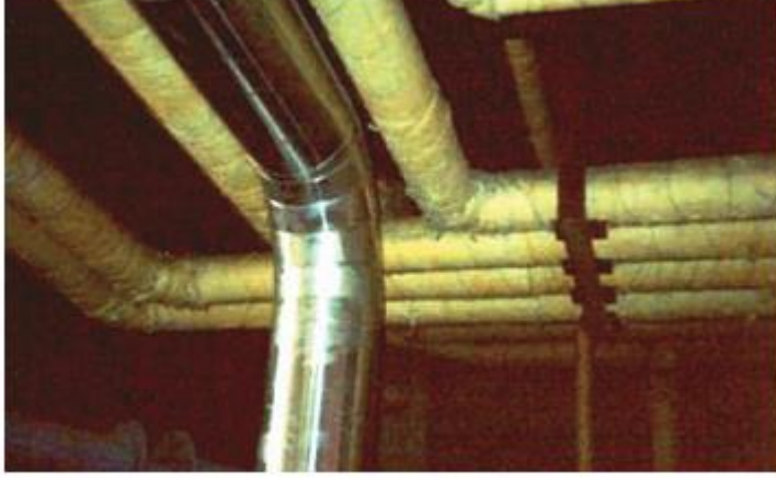
Şekil 2.4 : Camyünü ile boru yalıtımı (Hikmet ve ark. 2011)
