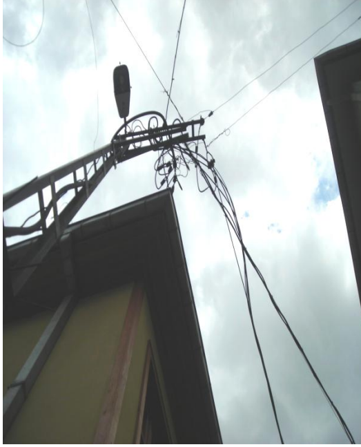
Şekil 4.3. Hastanenin ahşap çatısı etrafındaki yangın riski
