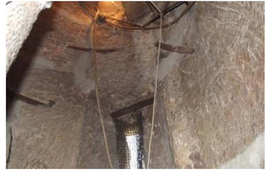
Şekil 1.14. Yatayda kullanılan kenet demirleri (Emir Sultan Cami)
