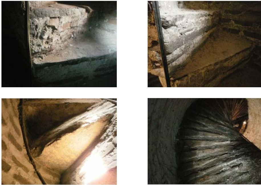
Şekil 1.10. Merdiven basamaklarına ait görünümler
