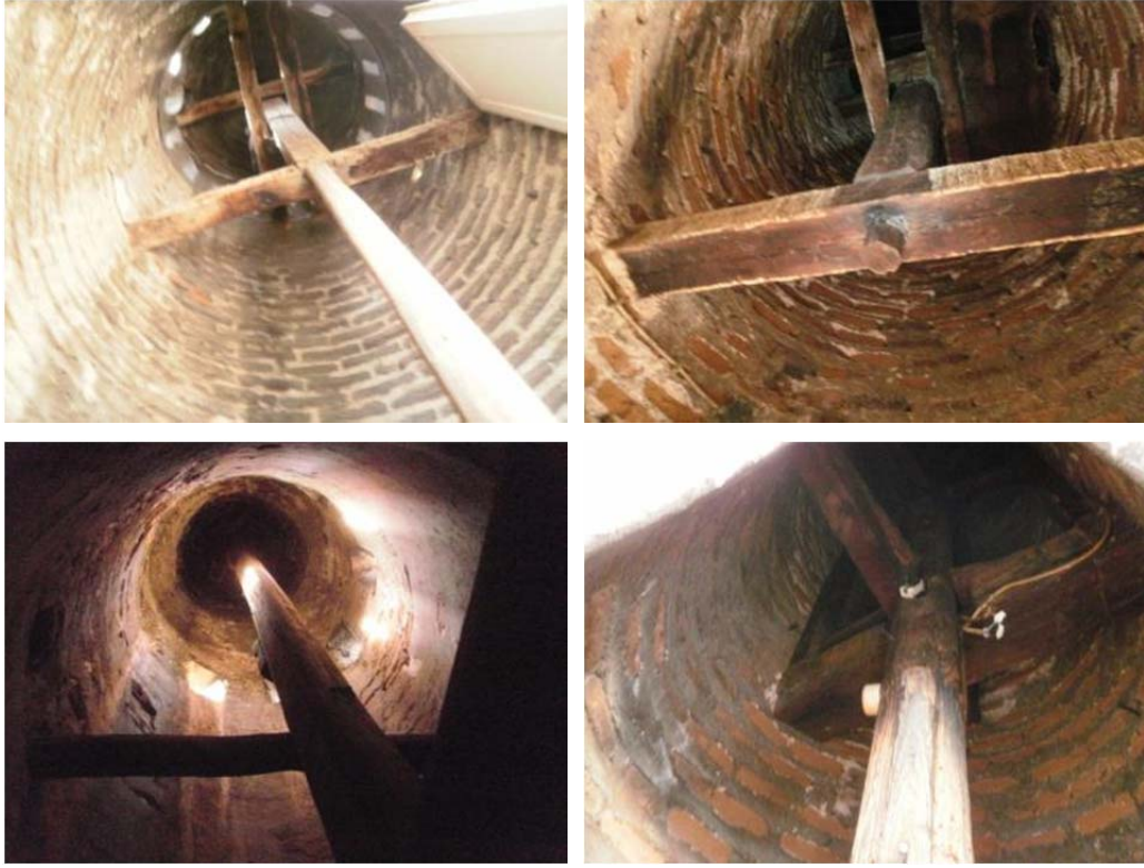
Şekil 1.8. Petek içi ahşap elemanlar
