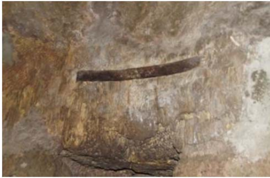
Şekil 1.14. Yatayda kullanılan kenet demirleri (Emir Sultan Cami)
