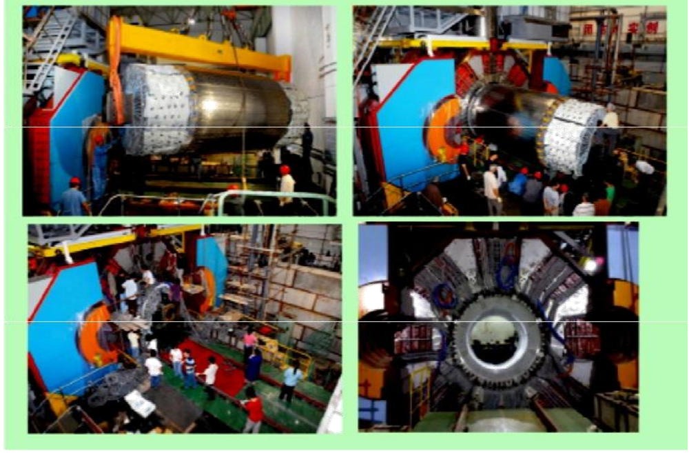
Şekil 2.3. Uç kapak kısmındaki EMC'nin kurulumu
