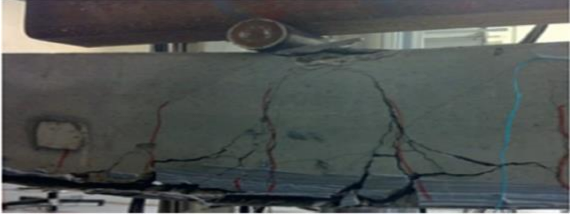
Şekil 5.4. BG Kirişinin Yük Altında Deformasyonu (Hawileh ark., 2014)
