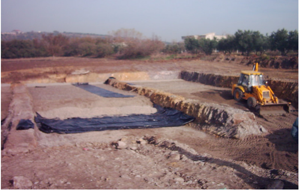
Fotoğraf 1. DAYS sisteminin inşaatı aşamasında, yeraltı suyuna sızıntıyı önlemek için serilen geçirimsiz malzemenin görünümü
