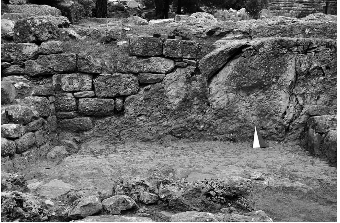
Resim 31 – Gıda Pazarı “O2” Numaralı Odanın Kuzey Duvarı
