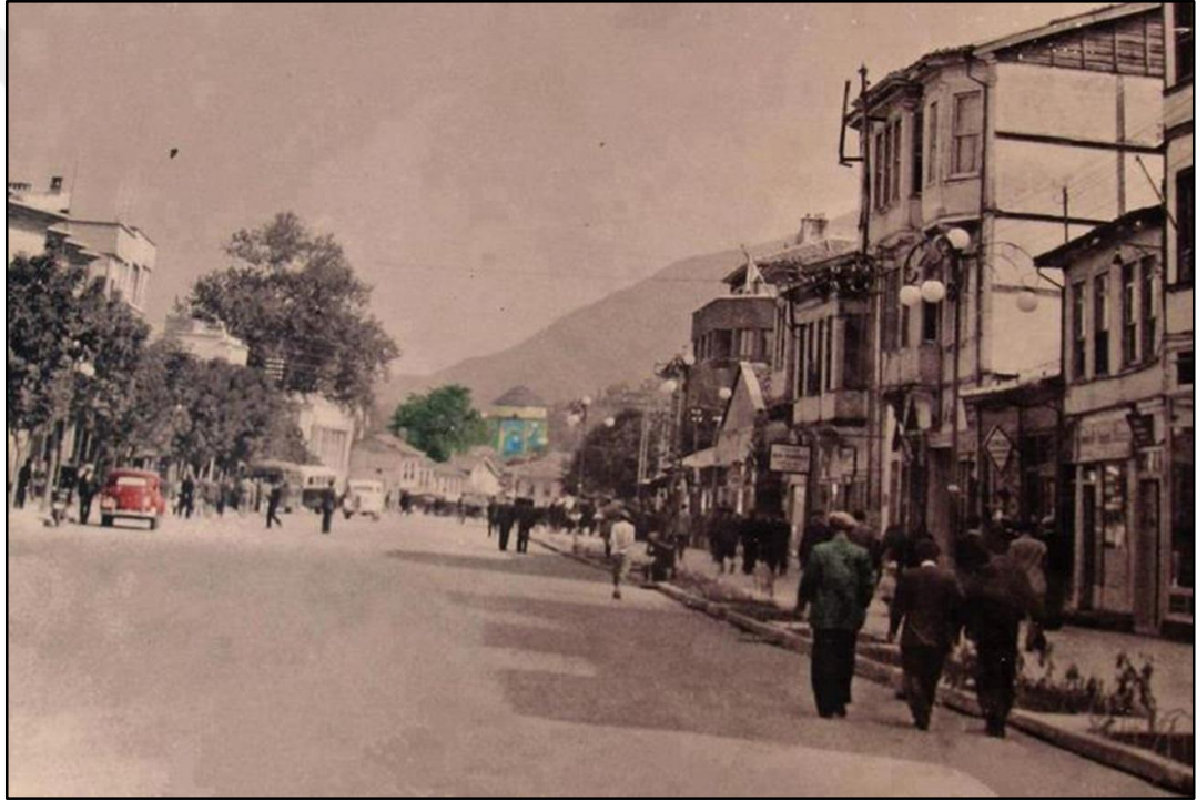
Şekil 4.1. Bursa Atatürk Caddesi ve Yeşil Türbe, 1940 (Bursa Büyükşehir Belediyesi Arşivi, 2017)
