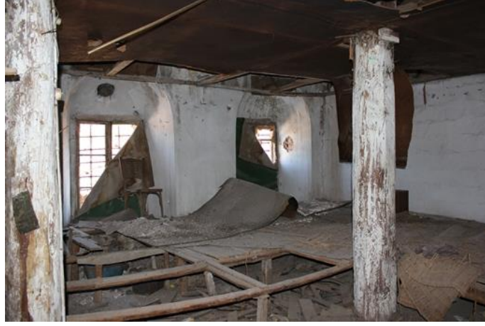
Şekil 4.19. 105 işçi yatakhaneşi güney ve batı duvarı görünüşü
