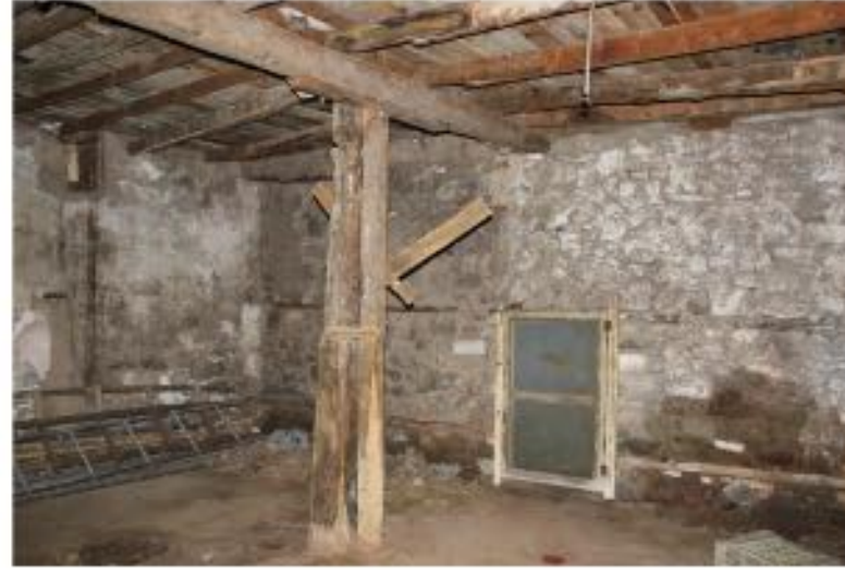
2) Z03 DEPO'NUN BATI DUVARI VE K4 POZ NUMARALI Z02 DEPO'YA GEÇİŞ KAPISI
