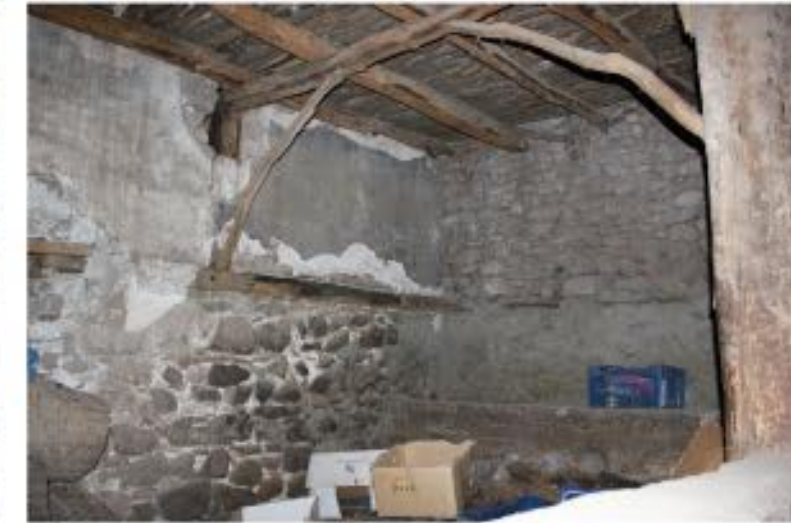
6) Z02 DEPO'NUN GÜNEY VE DOĞU DUVARI
