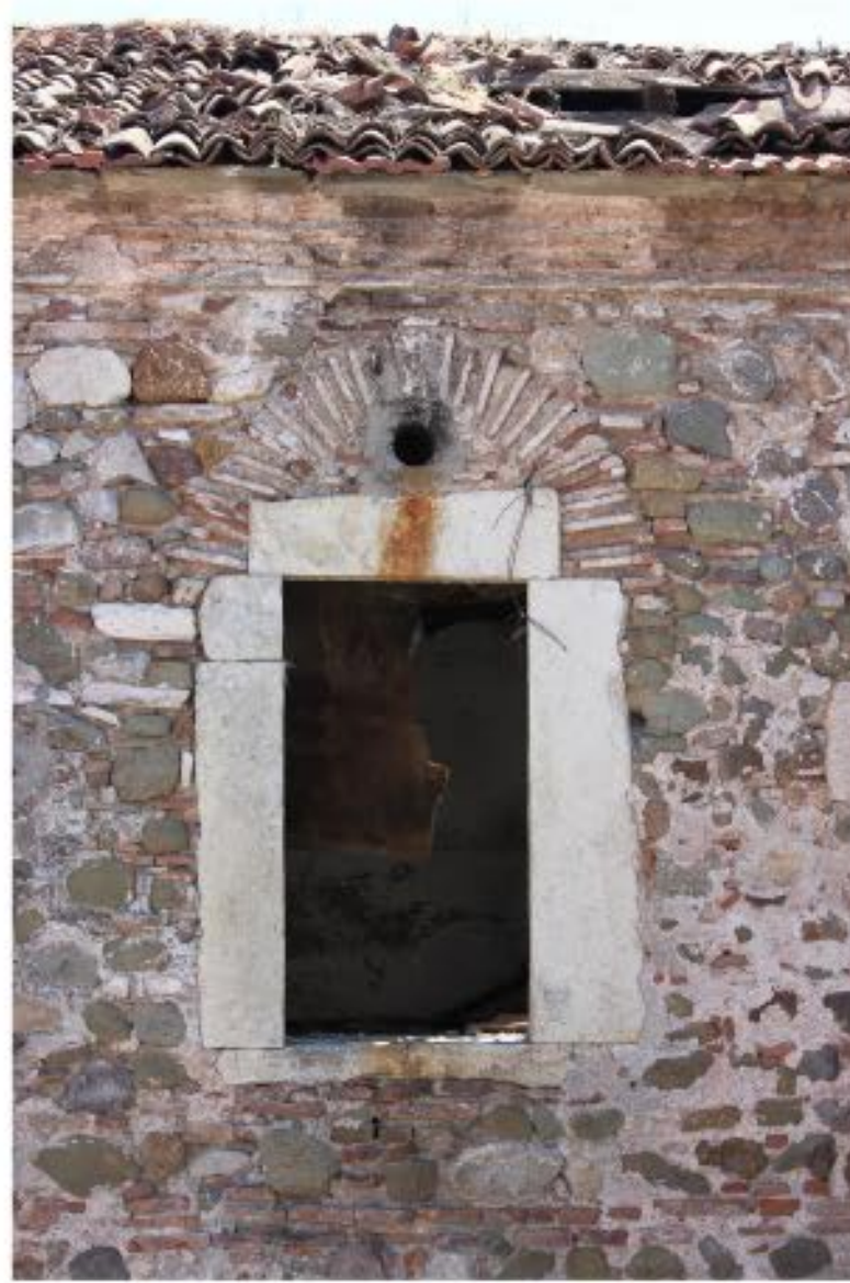
P27 POZ NUMARALI TAŞ SÖVELİ, TUĞLA KEMERLİ PENCERE
