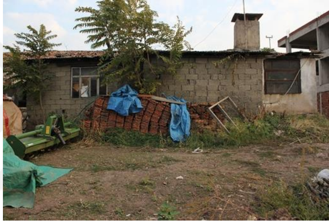
Şekil 4.35. Müştemilatın kuzey cephesi
