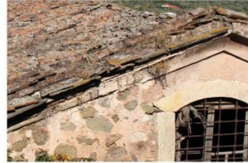
TUĞLA SAÇAK ÜZERİNE HORASAN SIVALI SAÇAK PROFİLİ
