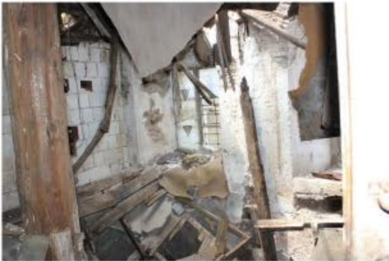
5) 106 ODA'DA KİLİSENİN ÖZGÜN AHŞAP SÜTUNU VE ODA NIN KİSMEN YIKILMIŞ DÖŞEMESİ
