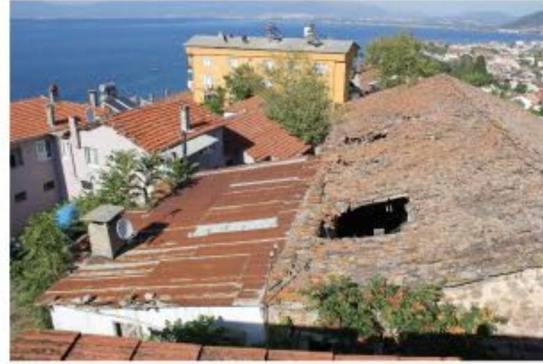
KİLİSENİN KUZEYBATISINA EKLENEN İŞÇİ YATAKHANESİNİN SAC ÖRTÜ ÇATISI
