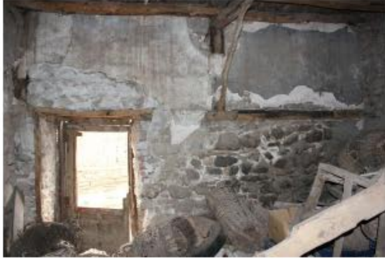
1) Z01 DEPO NUN DUVARI VE K2 POZ NUMARALI GİRİŞ KAPISI
