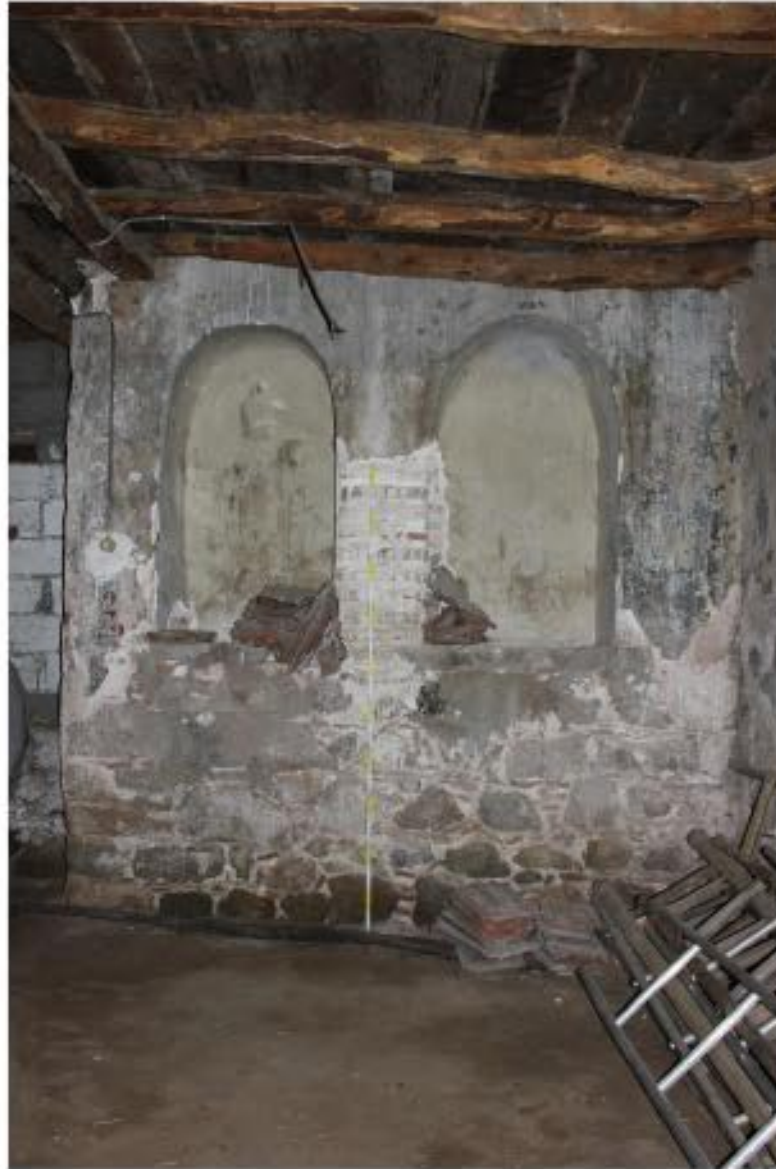
5) DOĞU DUVARINDA YIKILAN APSİS BÖLÜMÜNÜN GÜNEYİNDE BULUNAN NİŞLER
