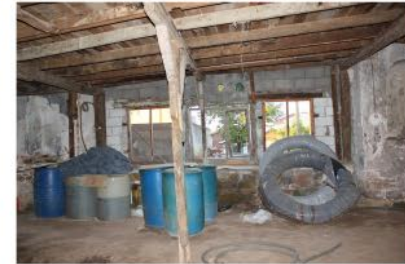
6) KUZEYDOĞU DUVARINDA YIKILAN APSİS YERİNE ÖRÜLEN BRİKET DUVAR VE GENİŞ AÇIKLIKLI PENCERELER
