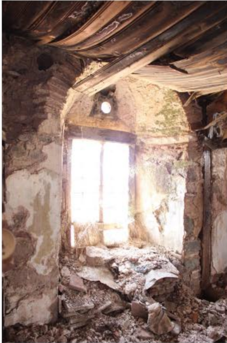
4) 102 ODA'NIN KUZEY DUVARINDA YER TUĞLA KEMERLİ PENCERE
