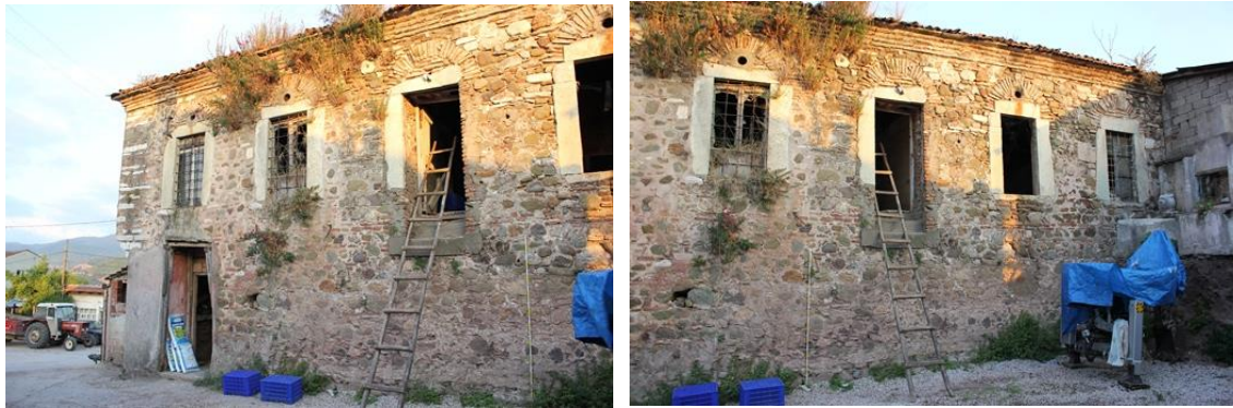
Şekil 4.34. Kilisenin kuzey cephesi
