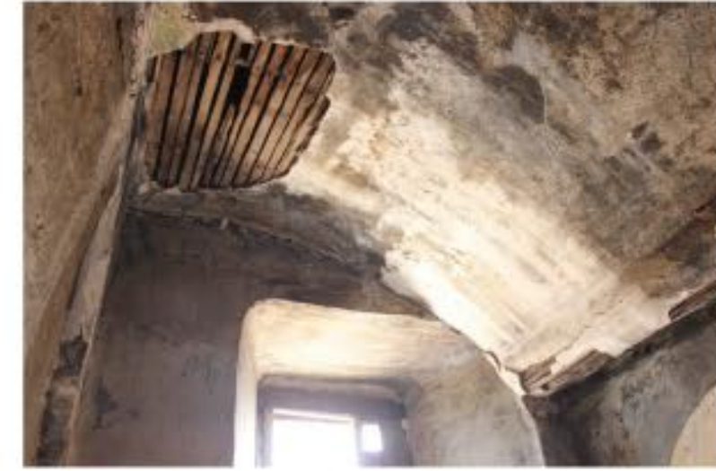
3) ÜST KOTTA YER ALAN PENCERE VE BAĞDADI ÇITA ÜZERİNE KERPIÇ SIVALI EĞRİSEL TAVAN
