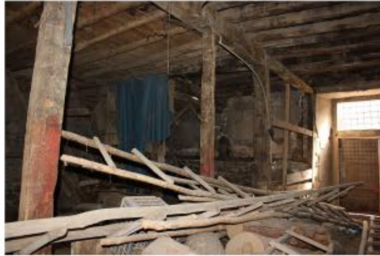
4) Z01 DEPO'NUN GÜNEY DUVARI VE ÖZGÜN AHŞAP SÜTUN VE KİRİŞLER
