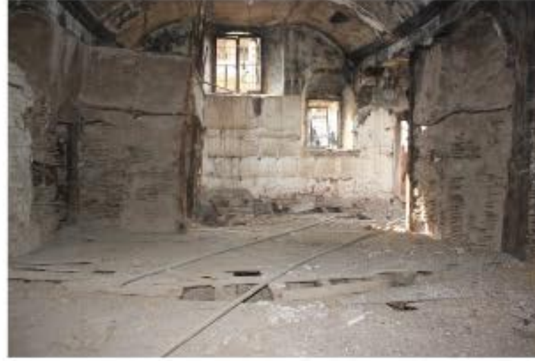
2) 107 SOFA – BATI DUVARI VE 110 ODA'NIN DOĞUDUVARININ BİR BÖLÜMÜ
