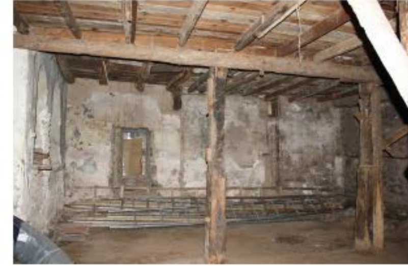
3) Z03 DEPO'NUN GÜNEY DUVARINA SONRADAN AÇILAN PENCERE VE KİLİSENİN ÖZGÜN AHŞAP SÜTUNLARI
