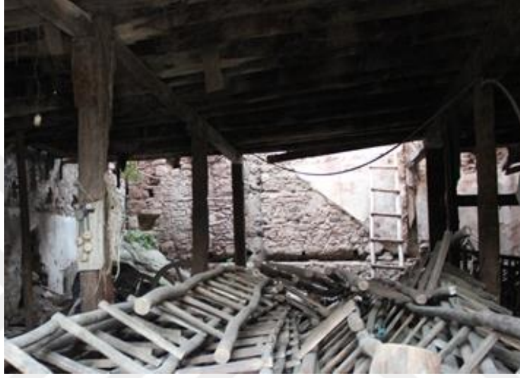
Şekil 5.14. Kuzey duvarında bulunan merdiven izi
