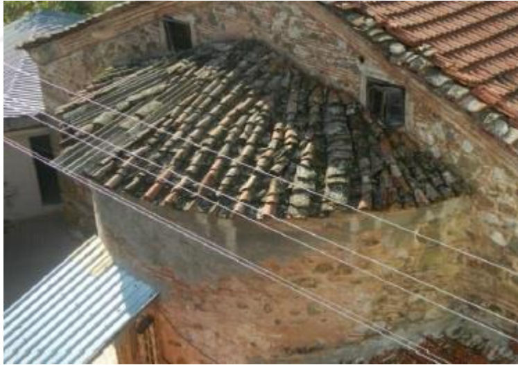
Şekil 5.20. Demirtaş Koimesis Tes Theotokos Kilisesi apsis mahyasız düzendeki çatısı
