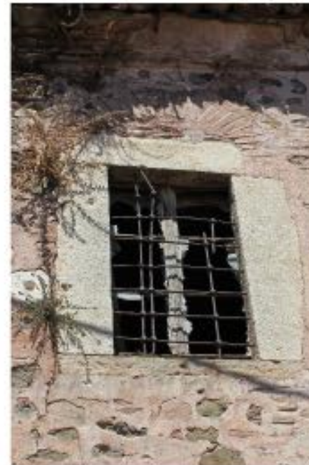
TAŞ SÖVELİ, TUĞLA KEMERLİ PENCERE
