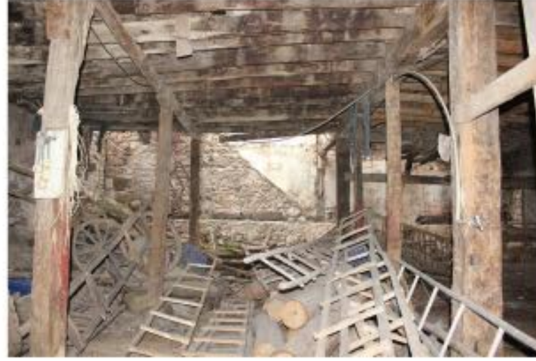
2) Z01 DEPO – AHŞAP SÜTUNLAR VE KUZAY DUVARI
