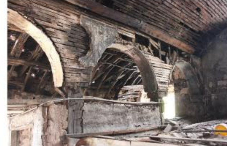
3) AHŞAP SÜTÜN VE BAĞDADI KEMER ÜZERİNE KİREÇ SIVA
