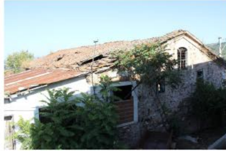
BATI CEPHESİ VE İŞÇİ YATAKHANESİ
