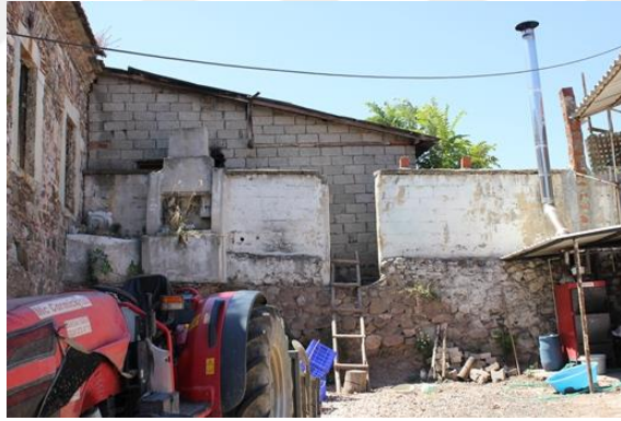
Şekil 5.6. Sonradan yapılmış olan işçi yatakhanesi ve istinat duvarı
