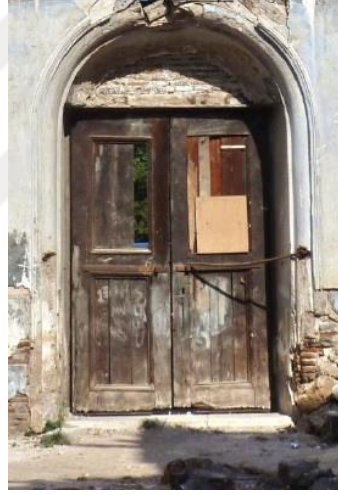
Şekil 5.11. Kayabaşı Holy Apostles Kilisesi’nde bulunan ahşap çift kanatlı kapı (Gülgün Yılmaz Mimarlık Restorasyon arşivine aittir. 2012)
