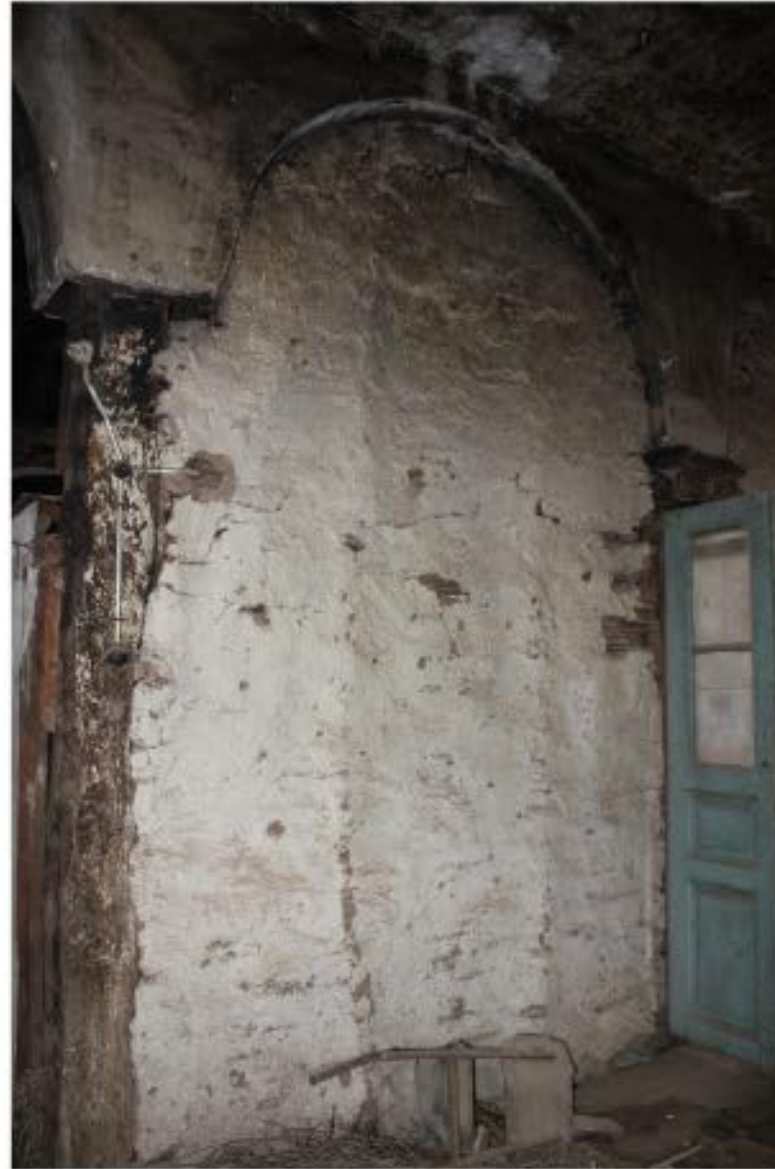
5) 103 ODA NIN, ÖZGÜN AHŞAP SÜTUNLAR ARASI DAL ÖRGÜ DUVAR TEKNİĞİNDE İNŞA EDİLEN GÜNEY DUVARI
