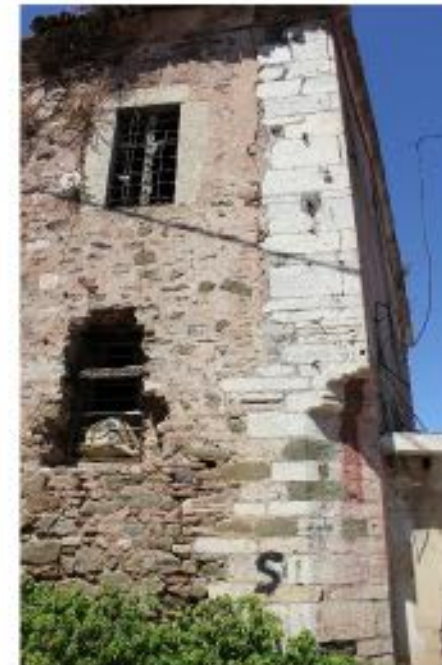
GÜNEYDOĞU KÖŞE DUVAR ÖRGÜSÜ
