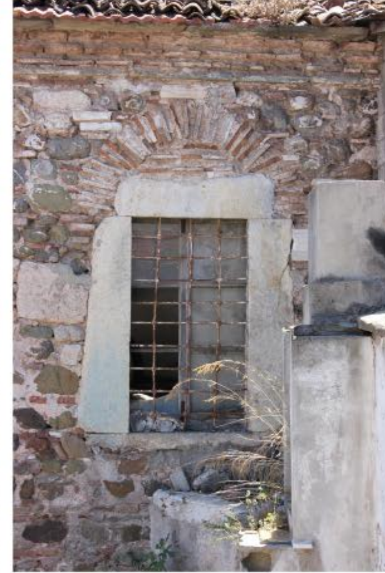
P26 POZ NUMARALI, TAŞ SÖVELİ, TUĞLA KEMERLİ, LOKMA PARMAKLIKLİ PENCERE
