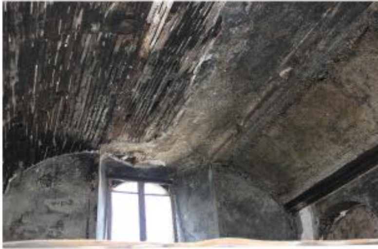
1) AHŞAP BAĞDADI ÜZERİNE KİREÇ SIVALI ORTA NEF TONOZU
