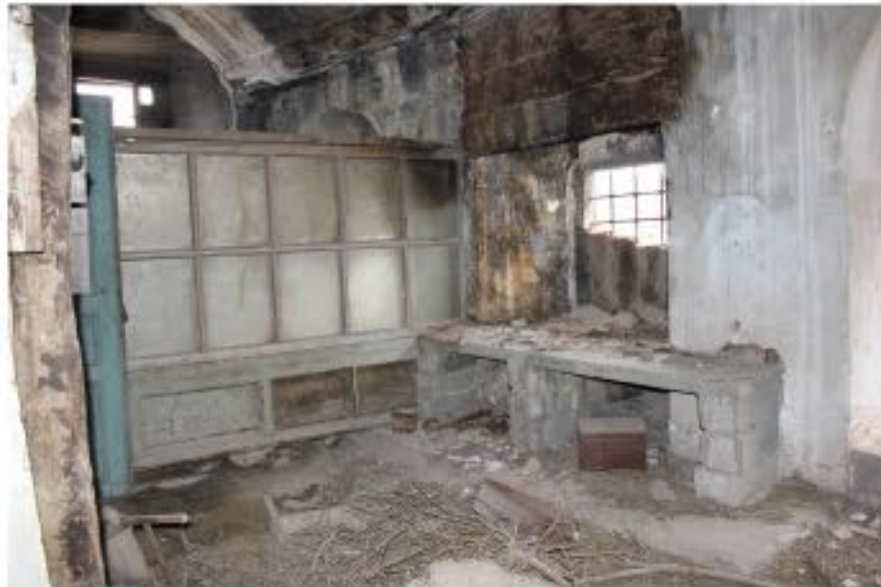
4) 101 KORİDOR - GÜNEY DUVARINA SONRADA EKKLENEN BETON TEZGAH VE 104 ODA'NIN AHŞAP BÖLME DUVARI
