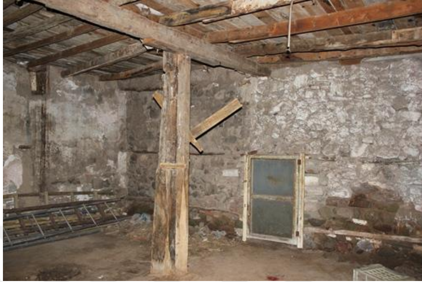
Şekil 5.22. Başmelekler Kilisesi'nin dış yüzeyi soyulmuş ahşap dikmesi
