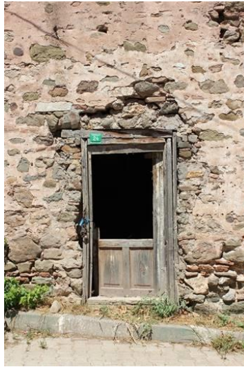
Şekil 5.8. Kilisenin güney duvarına sonradan açılmış olan kapı
