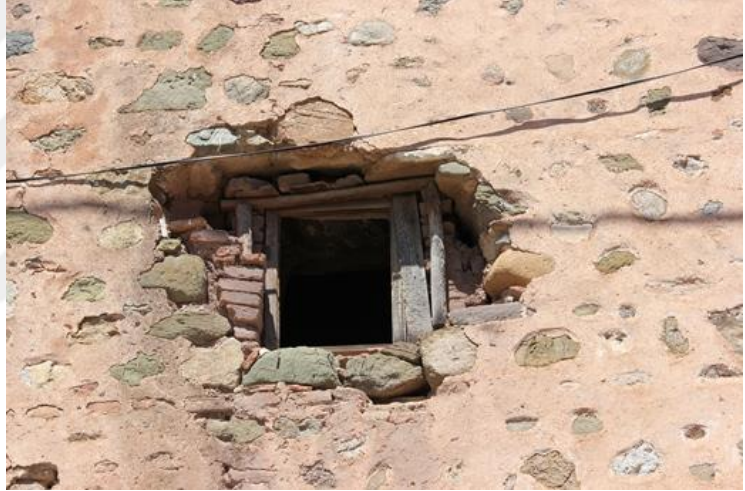
Şekil 5.1. Güney duvarı üzerinde sonradan mevcut nişin pencereye dönüştürülmesiyle (solda) ve gelişigüzel (sağda) açılmış pencereler
