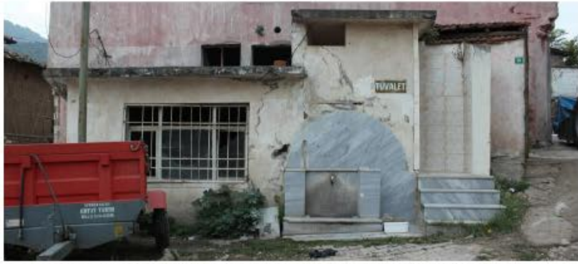
1) DOĞU CEPHESİNDE YIKILAN APSİS YERİNE YAPILAN EKLER
