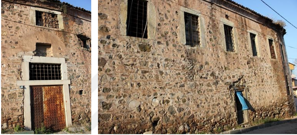
Şekil 5.3. Güney cephe görünüşü
