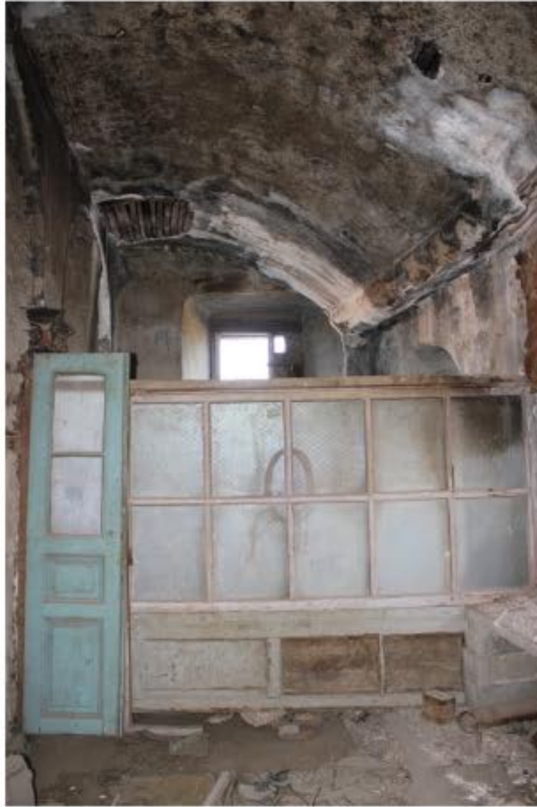
1) 101 KORİDOR İLE 104 ODA'YI AYIRAN AHŞAP BÖLME DUVAR VE KİLİSENİN YAN NEFİNİN EĞRİSEL TAVANI
