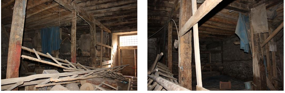
Şekil 5.12. Galeri katını taşıyan ana kiriş ve kirişlerin görünümü
