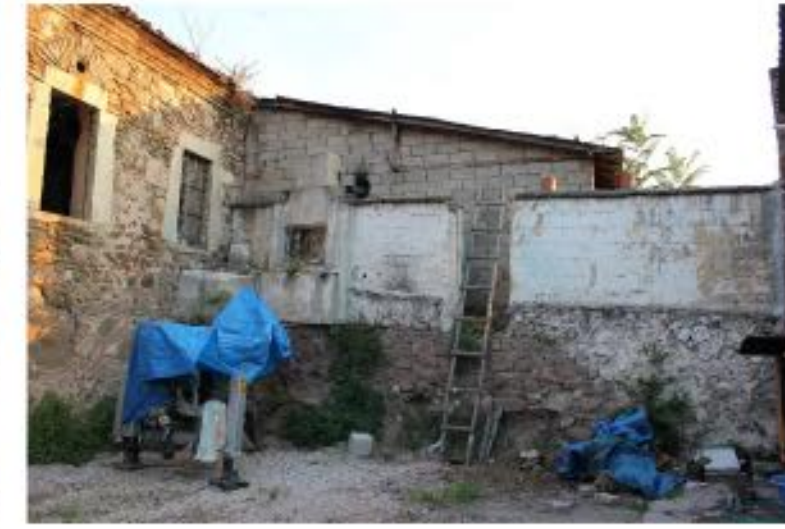
KUZEY CEPHESİNE EKLENEN İŞÇİ YATAKHANESİNİN DOĞU CEPHESİ VE İSTİNAT DUVARI
