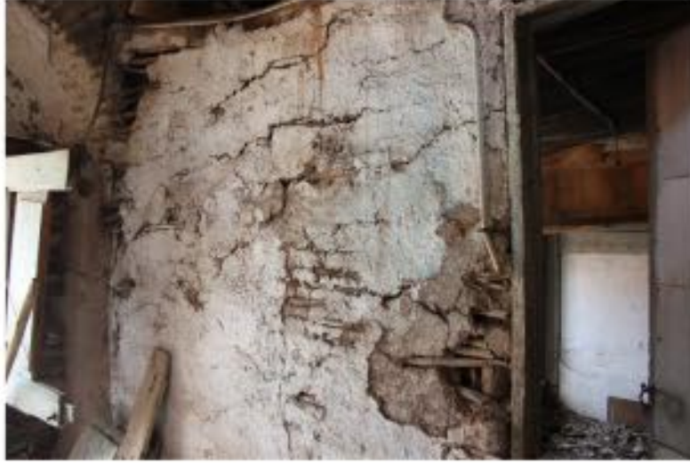
1) 102 ODA'NIN AHŞAP DAL ÖRGÜ ÜZERİNE KERPİÇ SIVALI DUVARI
