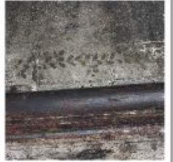
3) AHŞAP SÜTÜN VE BAĞDADI KEMER ÜZERİNE KİREÇ SIVA
