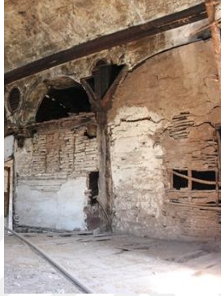
Şekil 4.23. 109 odanın kuzey duvarı görünüşü
