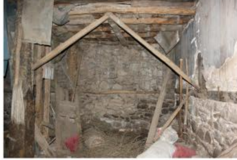
5) Z01 DEPO İLE Z02 ARASINDAKİ DOĞU DUVARI
