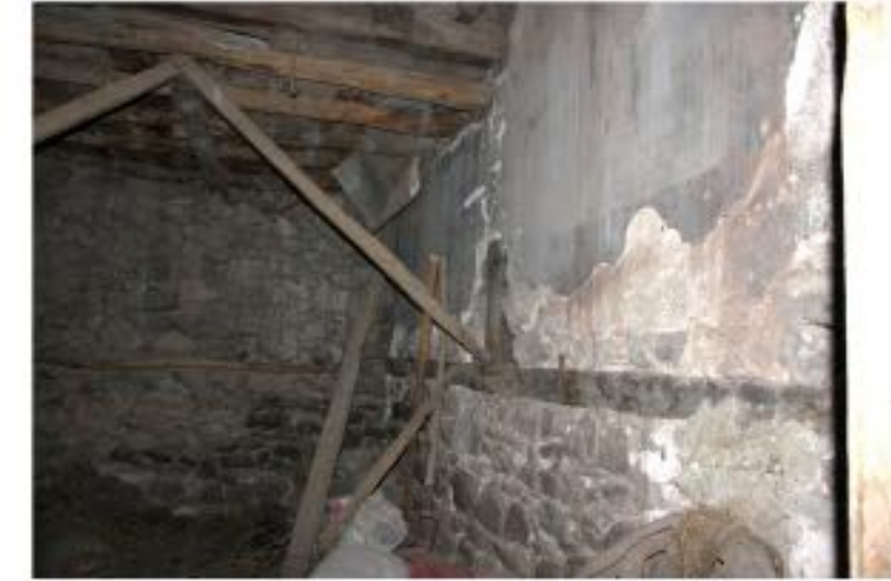
6) GÜNEY DUVAR ÖRGÜSÜ
