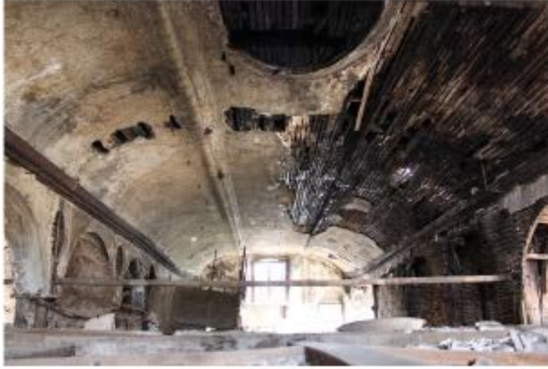
5) AHŞAP BAĞDADI ÜZERİNE KİREÇ SIVALI ORTA NEF TONOZU – ELİPS ŞEKLİNDE MADALYON İZİ
