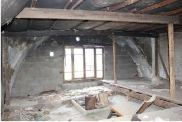
1) 103 ODA'NIN DOĞU DUVARI – YIKILAN APSİS YERİNE ÖRÜLEN BRİKET DUVAR VE GENİŞ PENCERE
