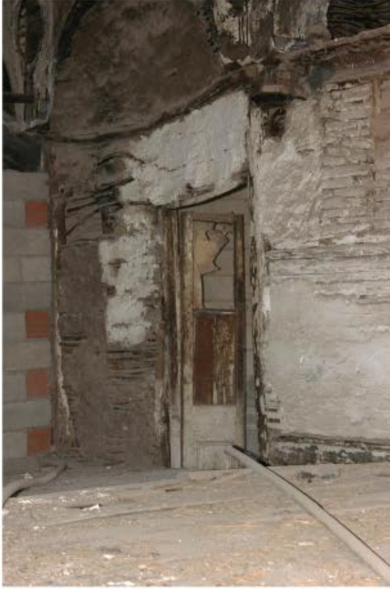
1) K18 POZ NUMARALI, 107 SOFA'DAN ODA 108'E GİRİŞ KAPISI VE ODANIN DAL ÖRGÜ DUVARI
