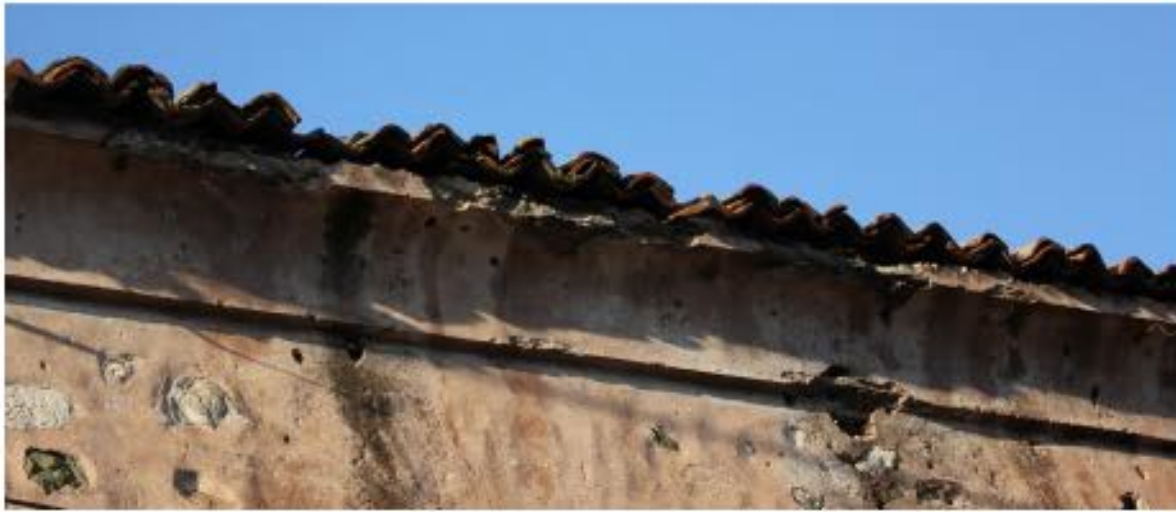
TUĞLA SAÇAK ÜZERİNE HORASAN SIVALI SAÇAK PROFİLİ
