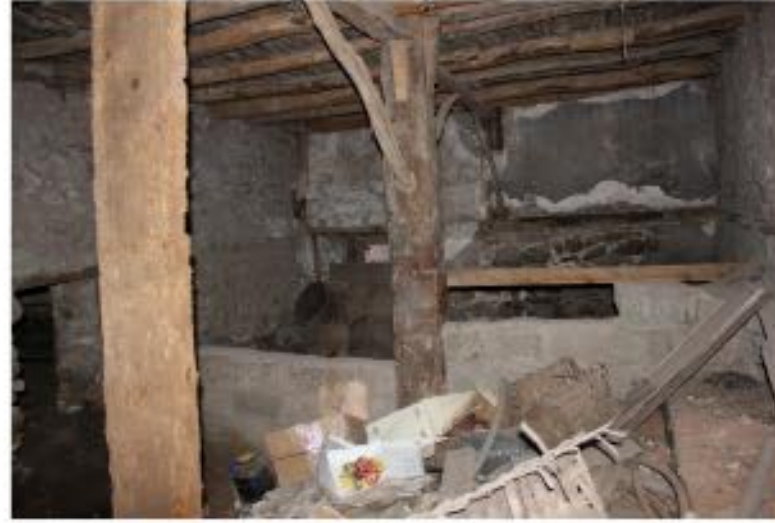
5) Z02 DEPO'DA BULUNAN BRİKET PARAPET DUVAR
