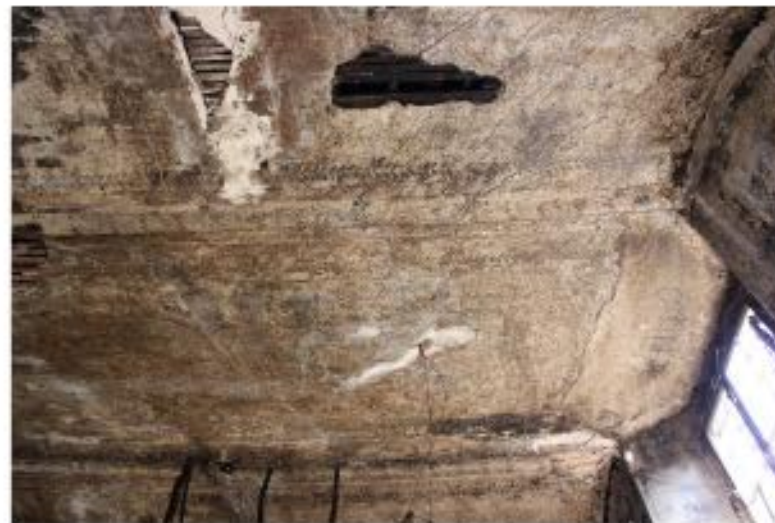
7) 107 SOFA TAVANININ KİREÇ ESASLI SIVA İLE SIVANMIŞ TONUZ ÖRTÜSÜ
