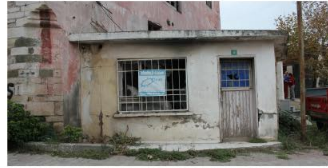
2) MUHTARLIĞIN GÜNEY CEPHESİNDEKİ K21POZ NUMARALI GİRİŞİ
