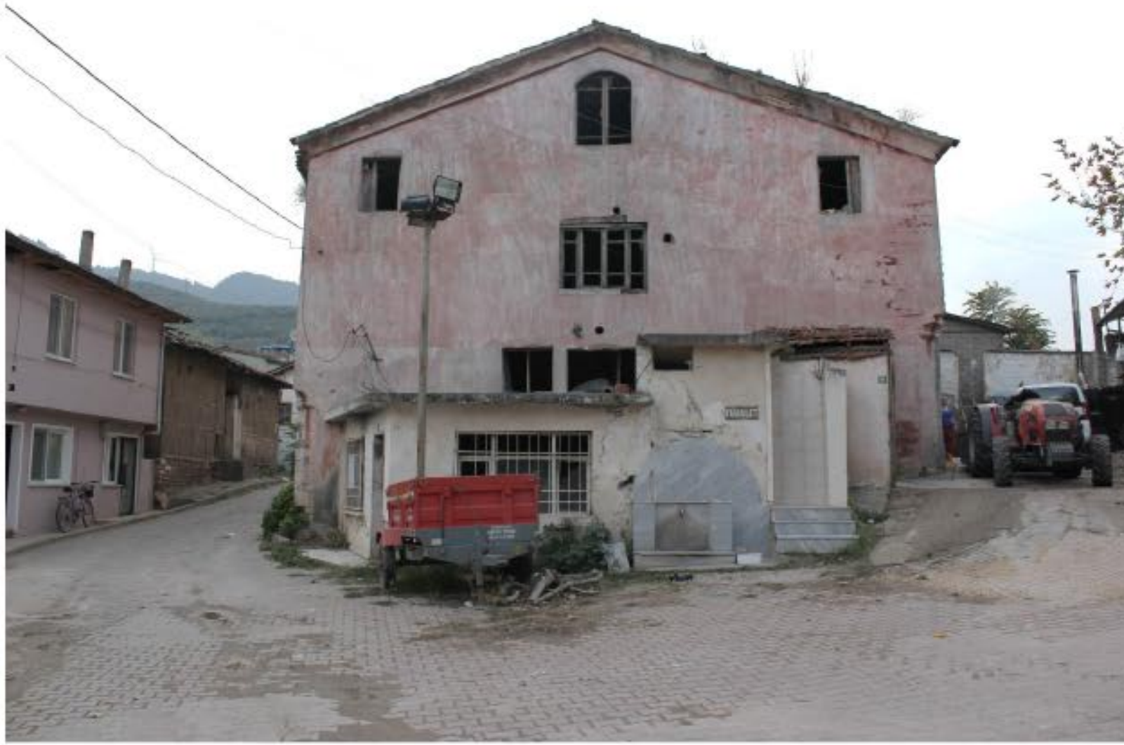
DOĞU CEPHESİ – ÖZGÜN HALİNDE APSİSİN BULUNDUĞU CEPHE
