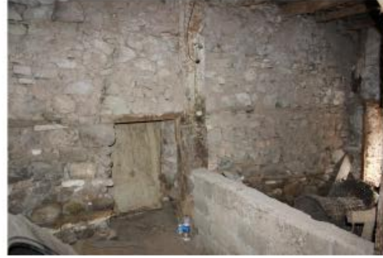
2) Z02 DEPO 'NUN DOĞUSUNDAKİ MOLOZ TAŞ DUVAR VE K4 POZLU AHŞAP KAPI
