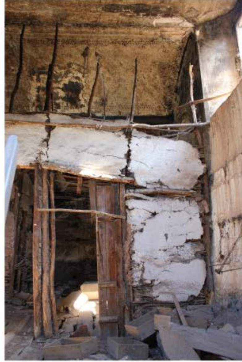
2) K20 POZ NUMARALI, 107 SOFA'DAN ODA 110'A GİRİŞ KAPISI VE ODANIN DAL ÖRGÜ DUVARI
