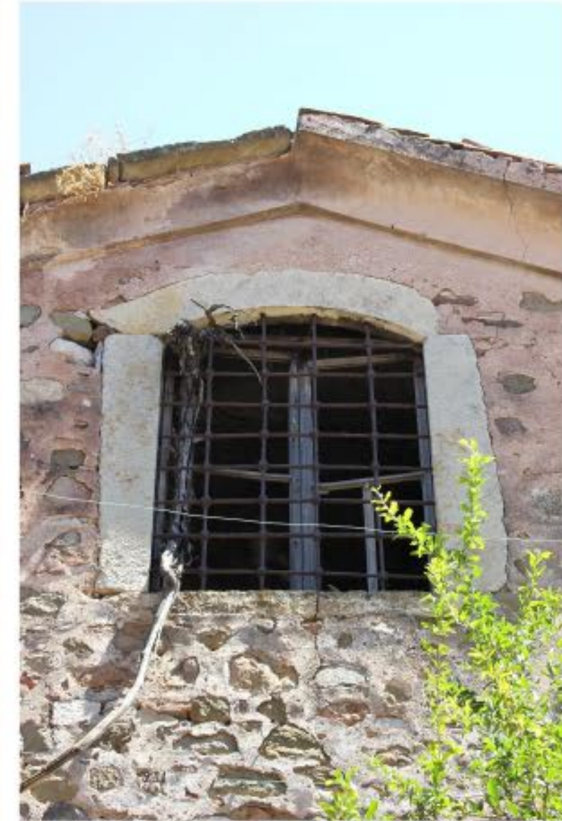
P29 POZ NUMARALI, TAŞ SÖVELİ, TUĞLA KEMERLİ, LOKMA PARMAKLIKLİ AHŞAP PENCERE
