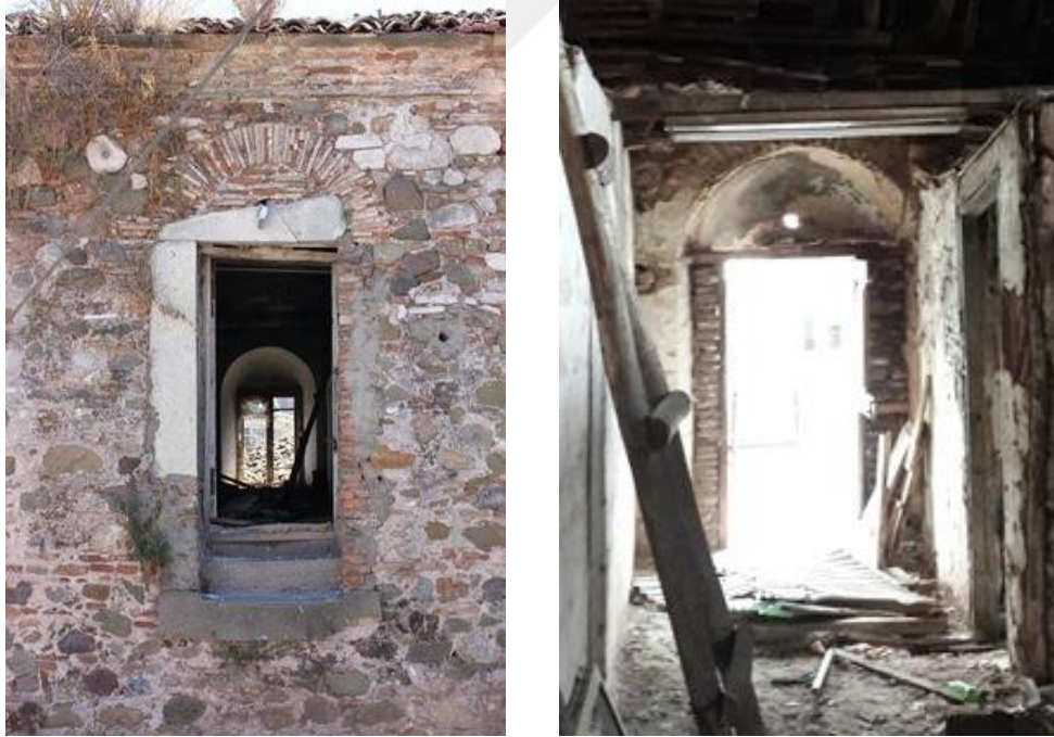
Şekil 5.2. Kapıya dönüştürülen pencerenin dışarıdan ve içeriden görünüşü
