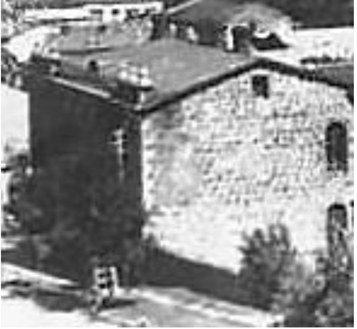
Şekil 4. 26. Eski Rus Konsolosluğu Binası'na ait eski bir fotoğraf ( https://www.tarihtarih.com/?Syf=4&Fa=2&Id=224124 , 2017)
