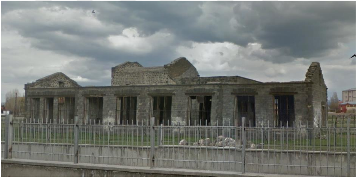
Şekil 3. 43. İstasyon Revizörlük Binası (Türkan 2016)
