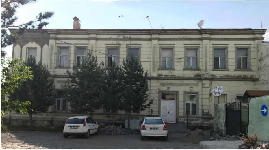
Şekil 4. 54. Defterdarlık Misafirhanesi ön görünüm (Türkan 2017)
