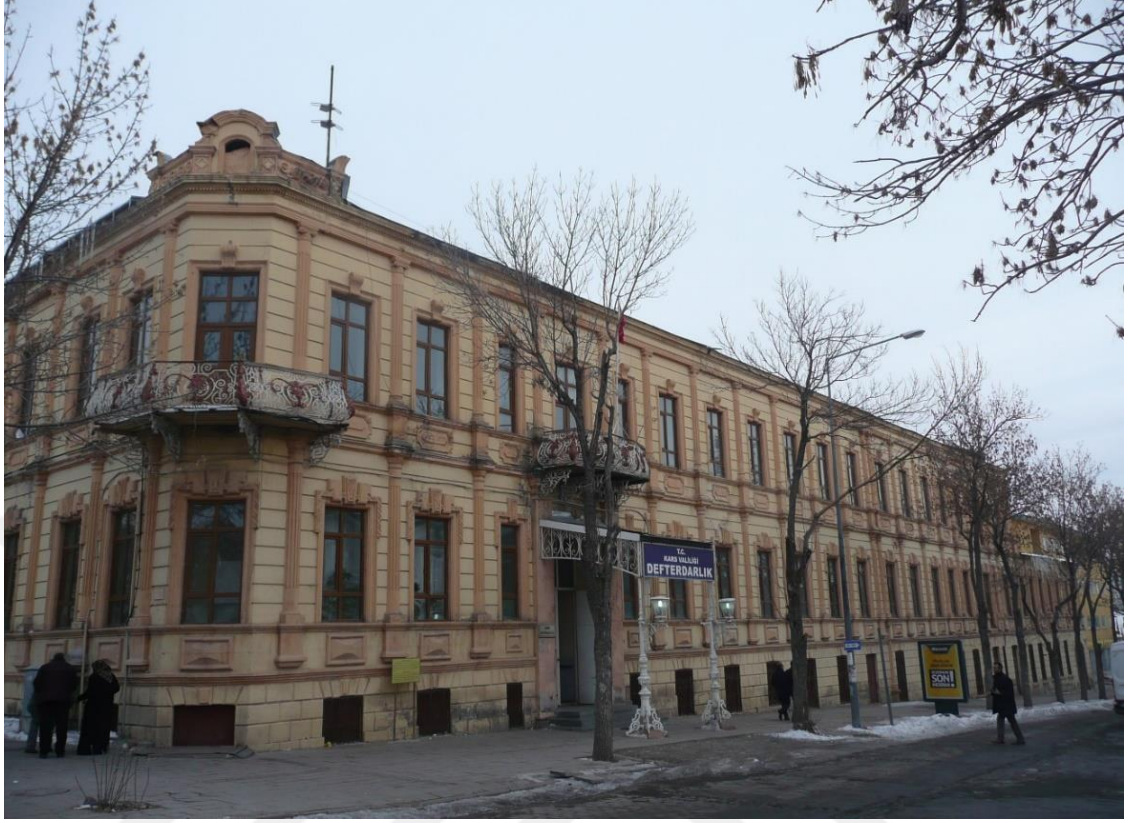
Şekil 4. 7. Deftardarlık Binası genel görünümü (Türkan 2016)
