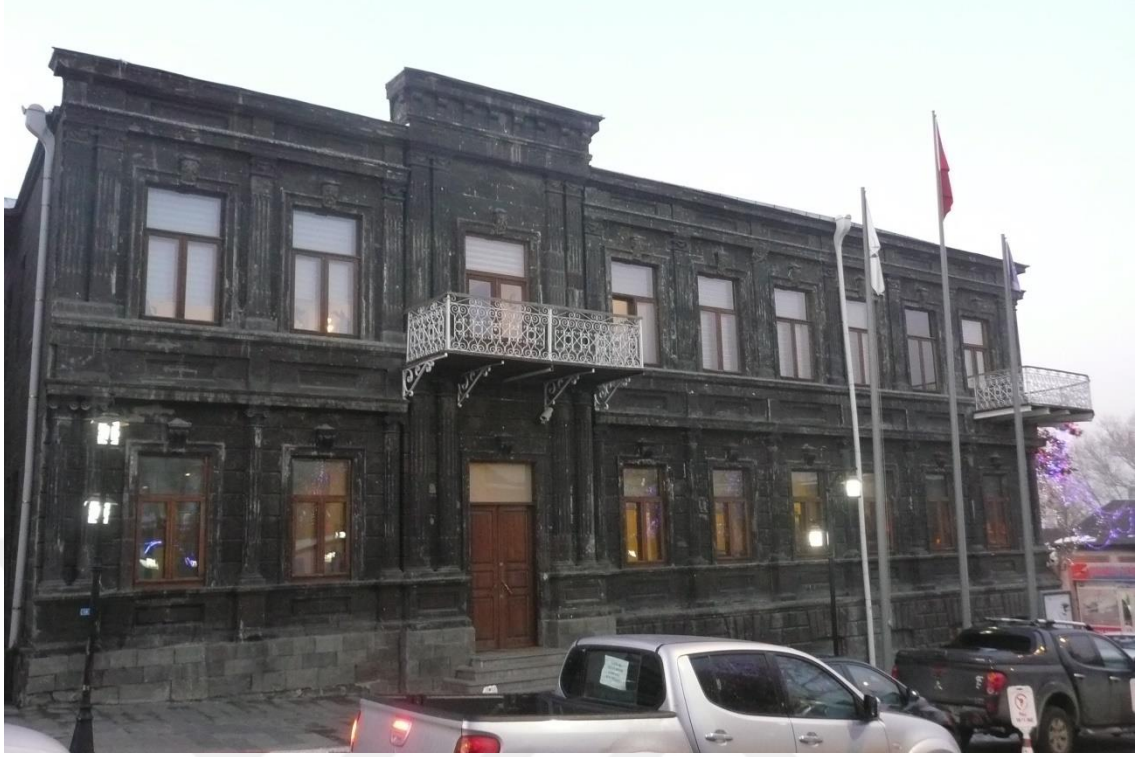
Şekil 4. 35. Kars Belediyesi Binası ön görünüm (Türkan 2017)
