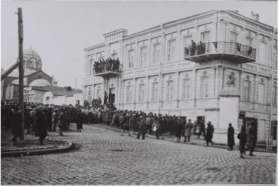
Şekil 4. 34. Kars Belediyesi Binası-1946 (Kars K.V.K.B.K.M. Arşivi 2017)
