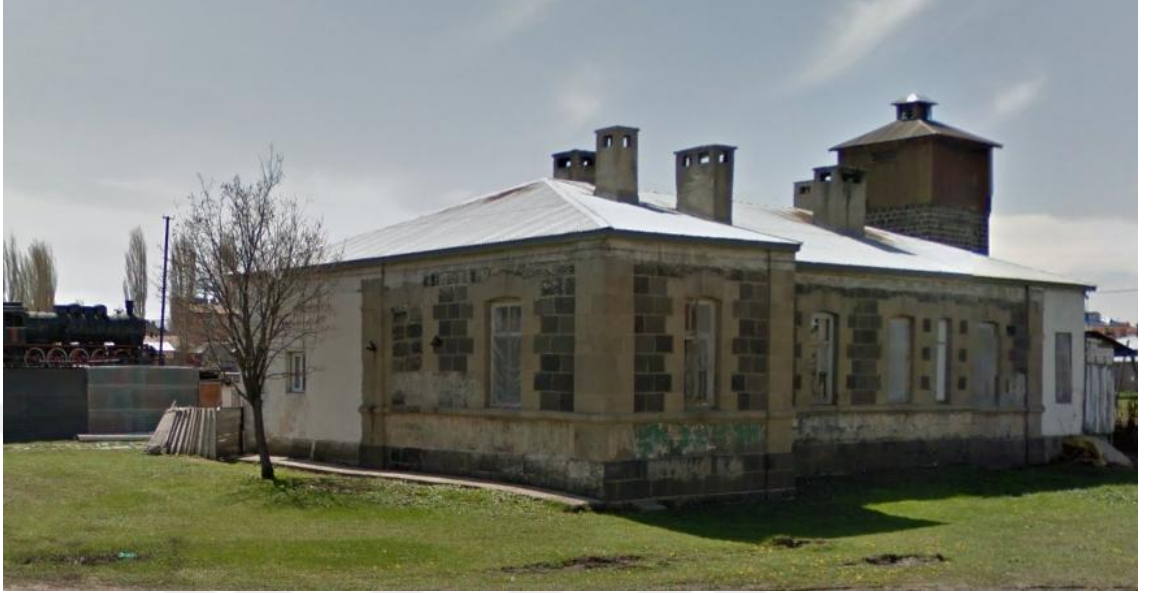
Şekil 3. 42. İstasyon lojmanı ve su kulesi (Türkan 2017)
