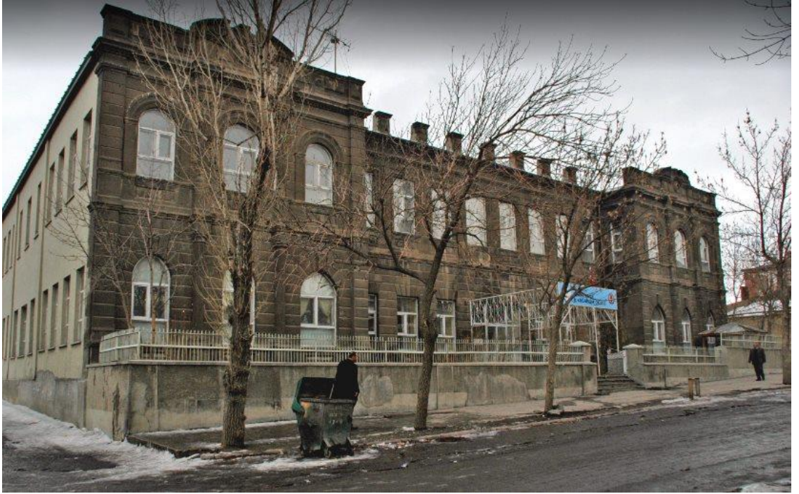
Şekil 4. 44. İsmet Paşa İlkokulu Binası ön görünüm (Türkan 2016)
