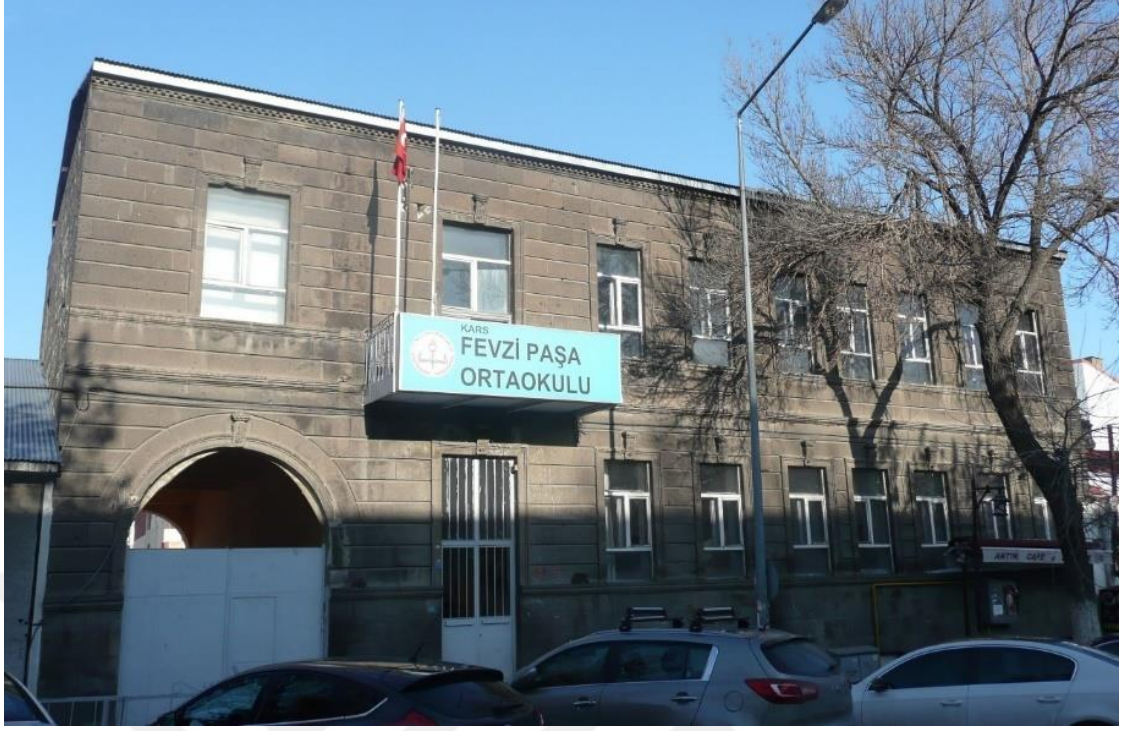
Şekil 4. 40. Fevzi Paşa Ortaokulu Binası ön görünüm (Türkan 2017)
