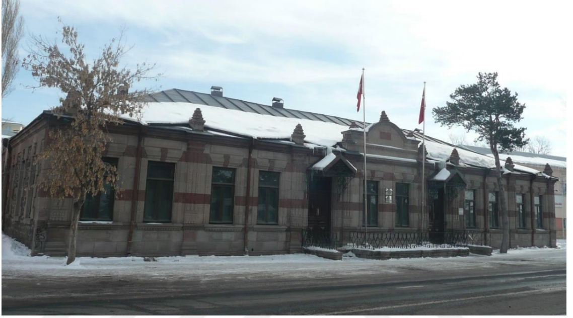
Şekil 3. 24. Ardahan'da bulunan bir Rus dönemi yapısı-Ardahan Kongre ve Kent Müzesi Binası (Türkan 2016)
