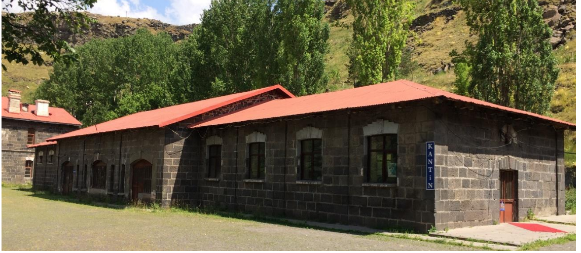
Şekil 3. 39. Tamirhane Binası görünümü (Türkan 2017)
