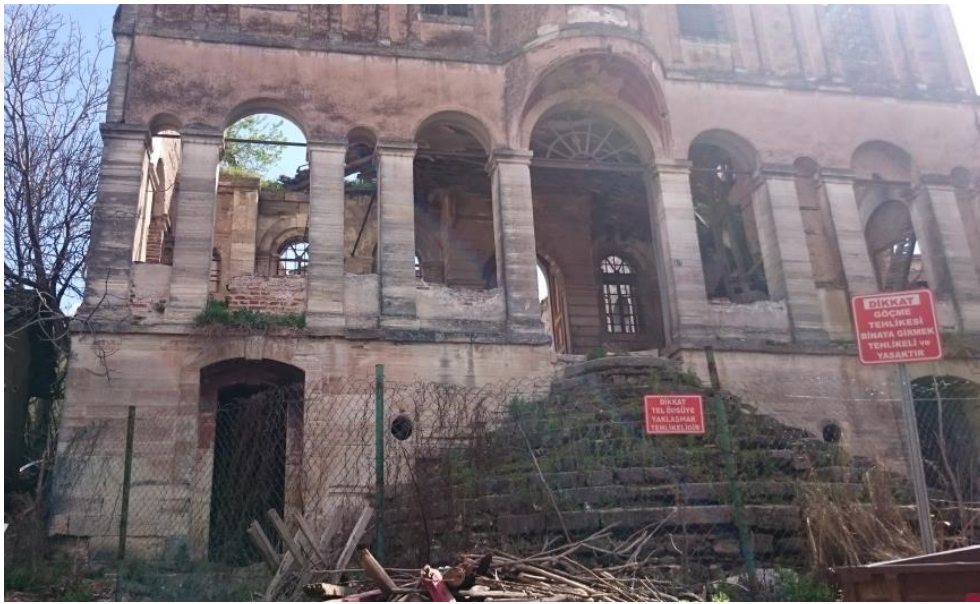
Şekil 2.28. Dereköy Kilisesi batı cephesi
