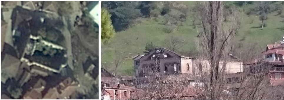
Şekil 2. 20. Dereköy Kilisesi'ne ait hava fotoğrafı (Google earth pro 16.05.2017) ile kilise ve yakın çevresini gösterir fotoğraf
