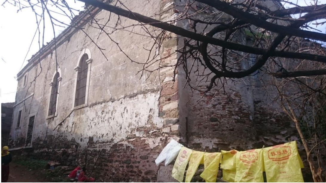
Şekil 2.39. Ballıpınar Kilisesi doğu ve güney cepheleri
