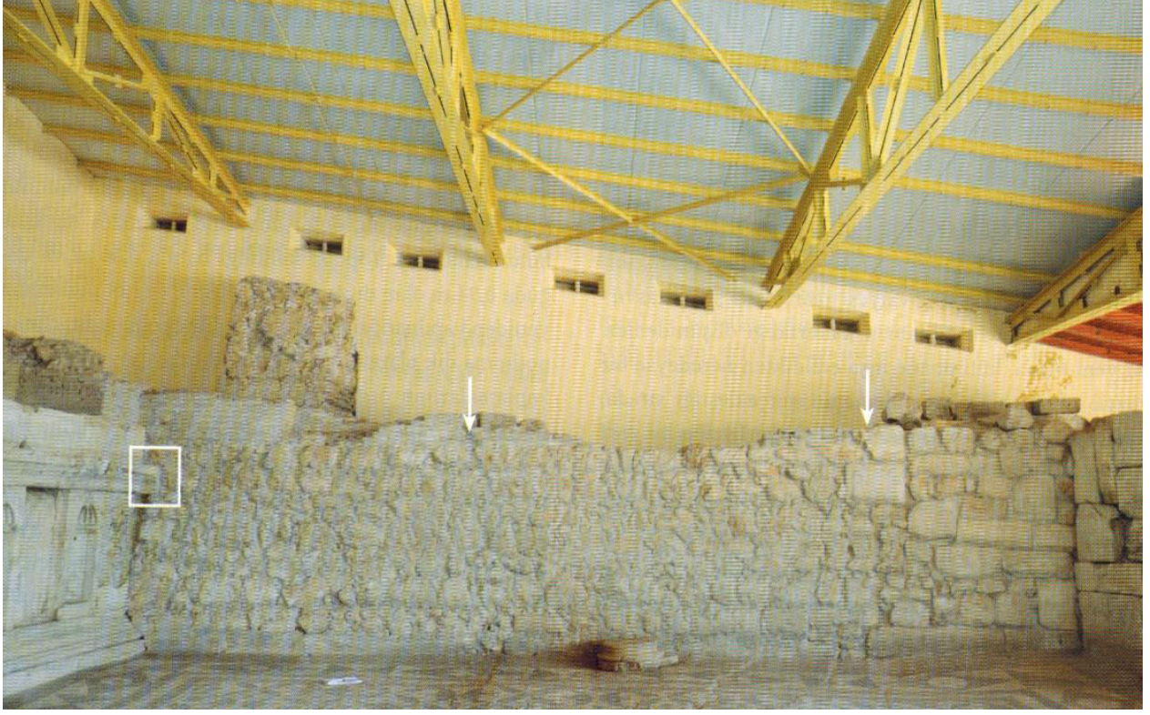
Resim 6. Opus mixtum tekniđi kullanılmıř dođu duvarı, 2. evre. M. Waelkens, "Sagalassos Antik Kenti: Titus Flavius Severianus Neon Kütüphanesi", Bülent Yılmaz (ed.), Anadolu Kütüphaneleri , (Ankara 2013), 159.
