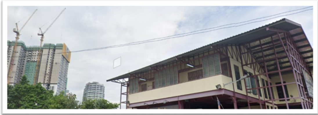
Şekil 4.31. Barınak yakınlarında inşaatı devam eden şantiyeler
