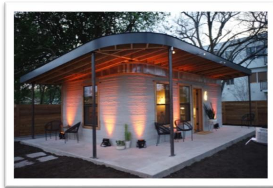
Şekil 2.7. Icon'un 3D baskılı evi (O’Neill 2019)
