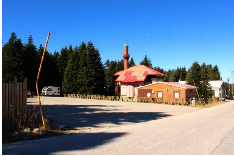
Şekil 4.3. Çobankaya kamp alanının girişinde yer alan cami ve araç parkı.
