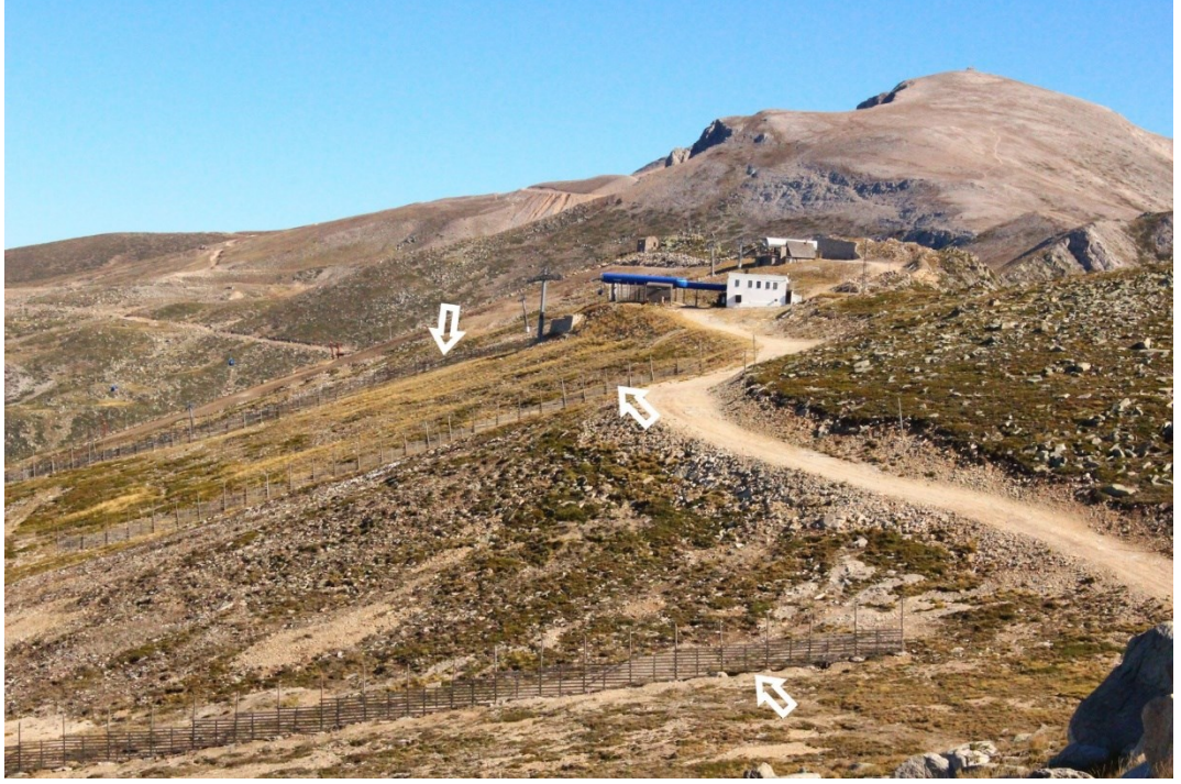
Şekil 4.8. Şahinkaya tepesinde yağın karın sürüklenmesini engellemek için tahtadan yapılan rüzgar kırıcılar.
