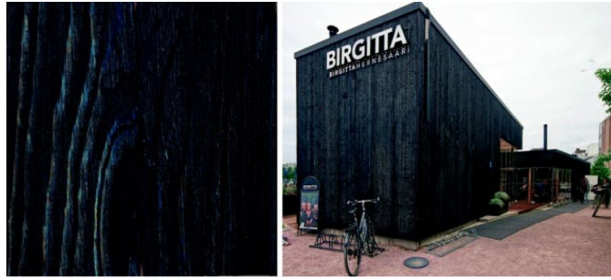
Şekil 2.66. Shou Sugi Ban tekniği ile yapılan cephe yüzeyi (Sandak ve ark., 2019)
