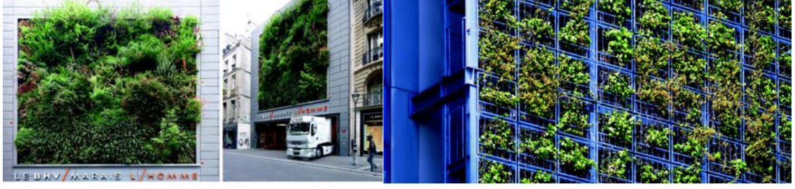
Şekil 2.47. Yapılarda uygulanan yeşil duvar (sol görsel) ve yeşil cephe (sağ görsel) (Sandak ve ark., 2019)
