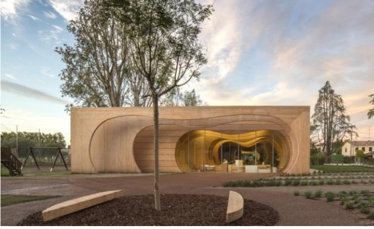
Şekil 2.61. Guastalla'da Anaokulu (Cucinella, 2015)
