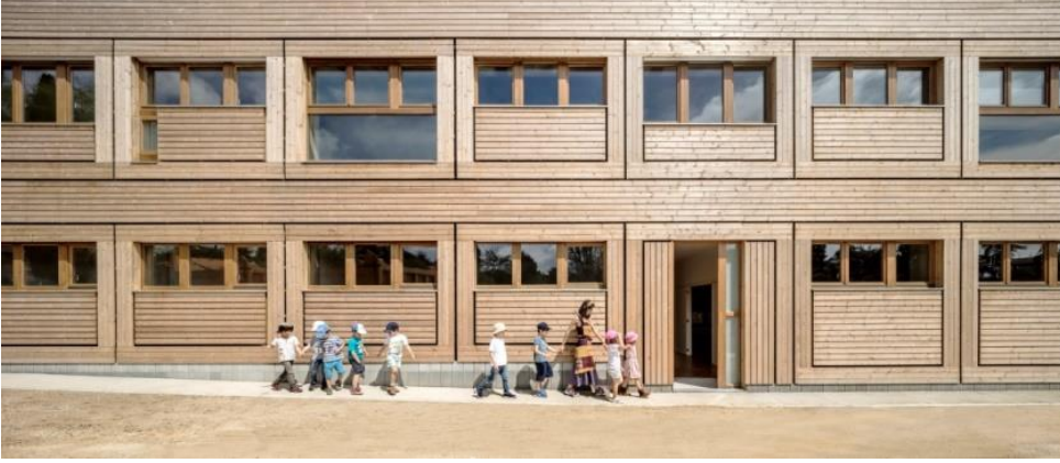
Şekil 2.88. Doğal Aydınlatma ve doğal havalandırma kullanımı (Ott, 2018c)
