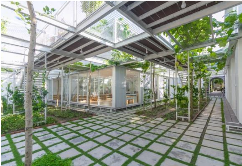
Şekil 2.36. Çelik yapı ve merdivenler (Abdel, 2020)
