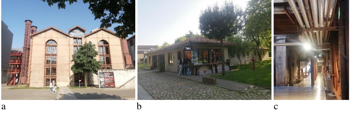
Şekil 4.11. a. Eski kazan daireleri (mimarlık fakültesi). b. İşçi soyunma binası (kafe). c. Eski kazan dairesi (müze) (Yazar arşivi,2023)
