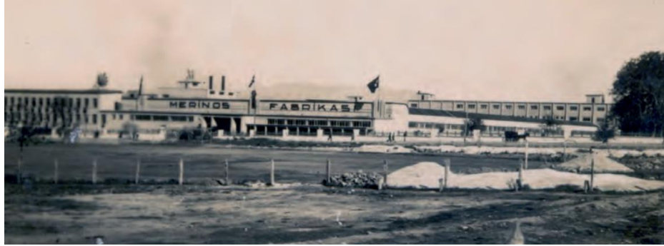
Şekil 4.39. Merinos Fabrikası görünüm (Bircan, Dalkılıç, 2018)
