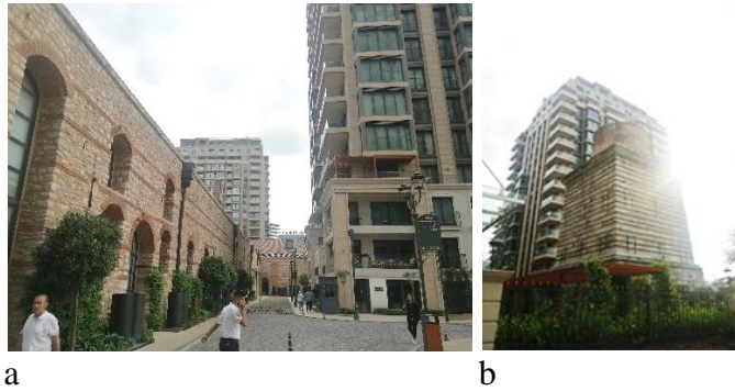
Şekil 4.19. a. Dökümhane yapısı ve çevre yapılarla ilişkisi. b. Su Kulesi'nin çevre yapılarla ilişkisi (Yazar arşivi,2023)
