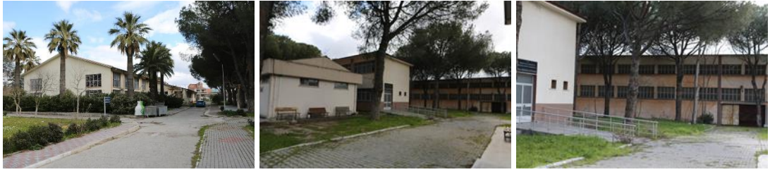
Şekil 4.37. Bergama Tekstil Fabrikası binaları ( https://www.visitizmir.org/tr/Destinasyon/12982 )
