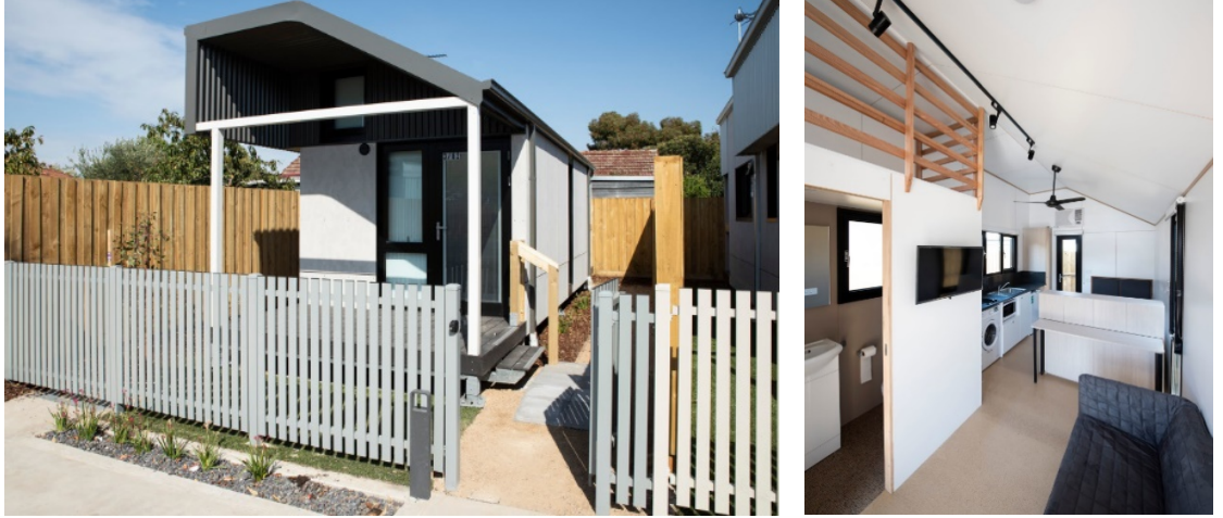
Şekil 4.22. The Harris Transportable Housing Project görünüş ve iç mekan (Schored Projects, 2021)
