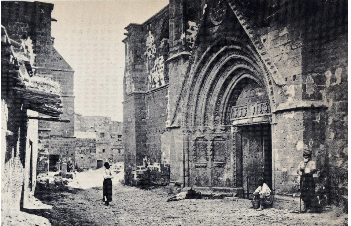
Sağda Lefkoşa Bedesten ve Solda Selimiye Camii (John Thompson 1878.)
