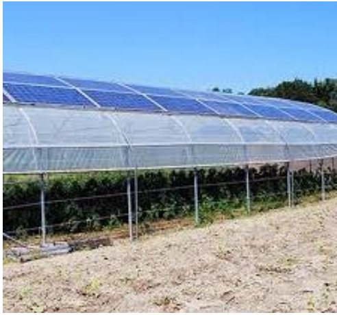
Şekil 2.22. Tarım üretiminde güneş enerjisi (Anonim, 2022i)
