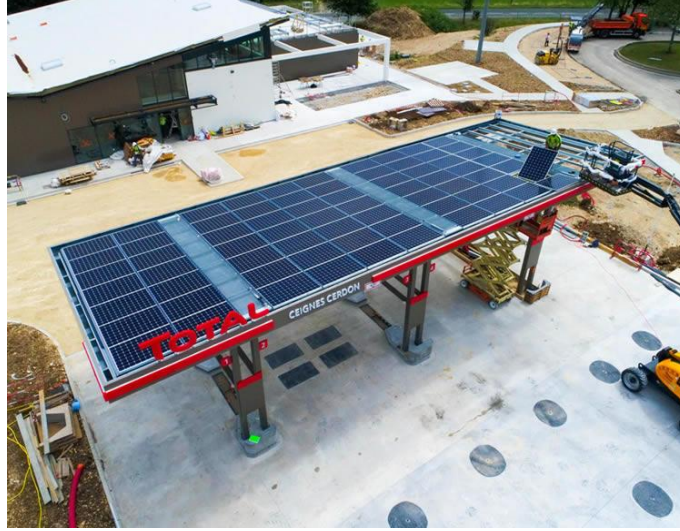
Şekil 2. 11. Benzin İstasyonunda güneş enerjisinin kullanımı (Anonim, 2020c)
