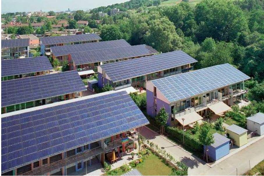
Şekil 2.1. Almanya bina çatılarında güneş enerjisi (Anonim, 2020a)
