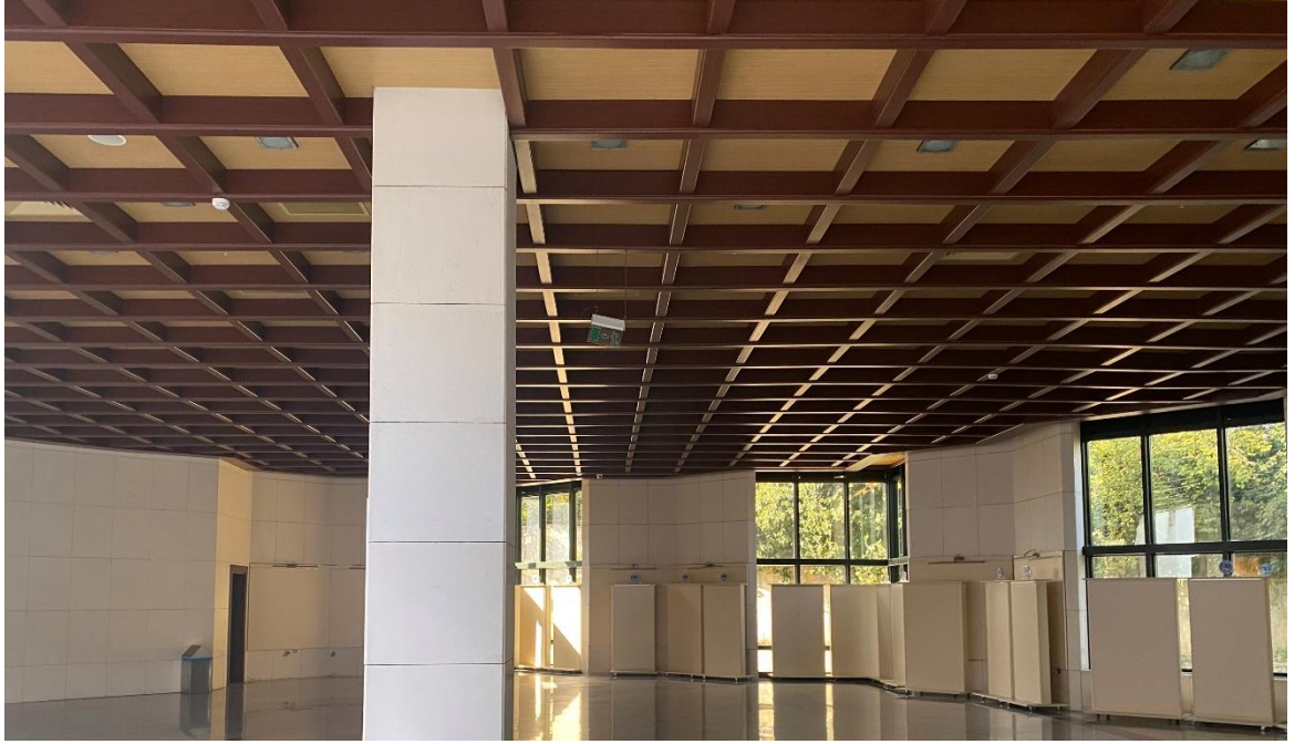
Şekil 4.17. Ahşap tavan kaplama örneği
