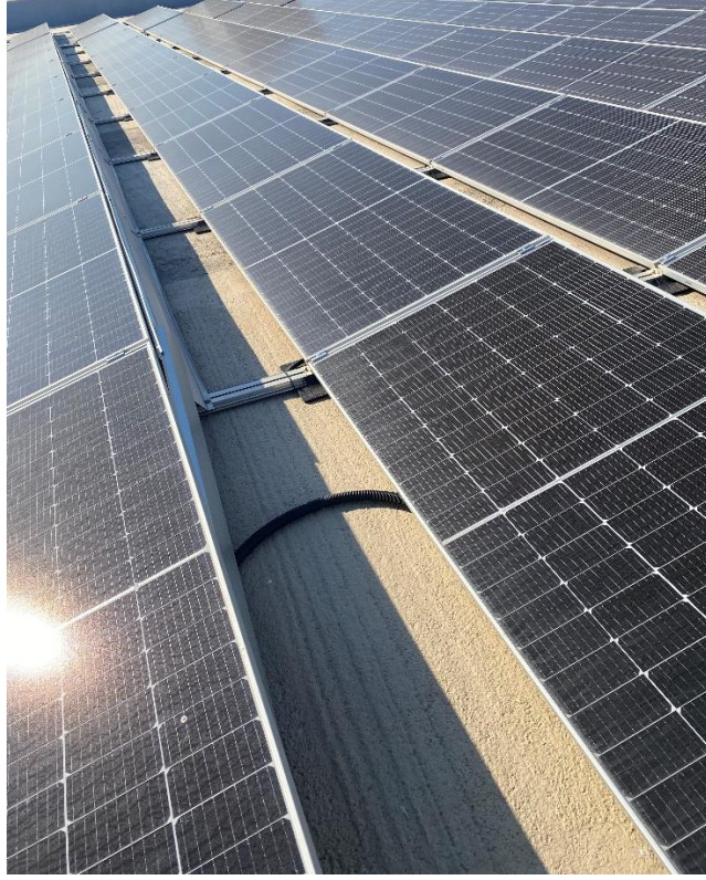
Şekil 4.31. Korunumlu kablo kullanılmayan PV panel sistemi örneği
