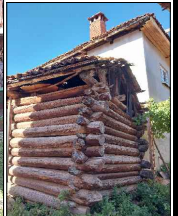
Ahşap odunluk yapısı
