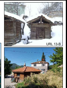
Restore edilen değirmenlerin önceki ve sonraki hali
