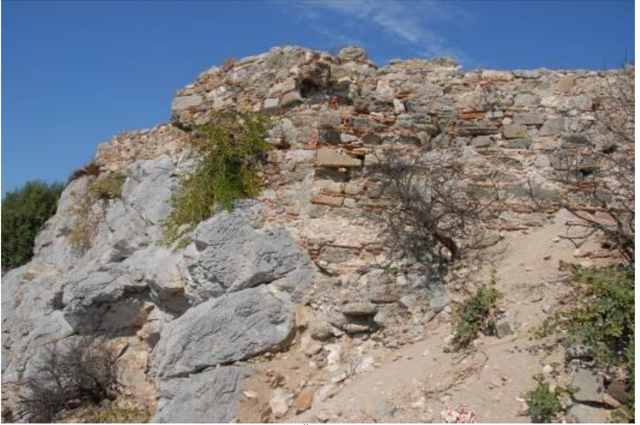
Görsel 11 - Tuğla Çerçeve Örgülü Sur Duvarından Görünüş
