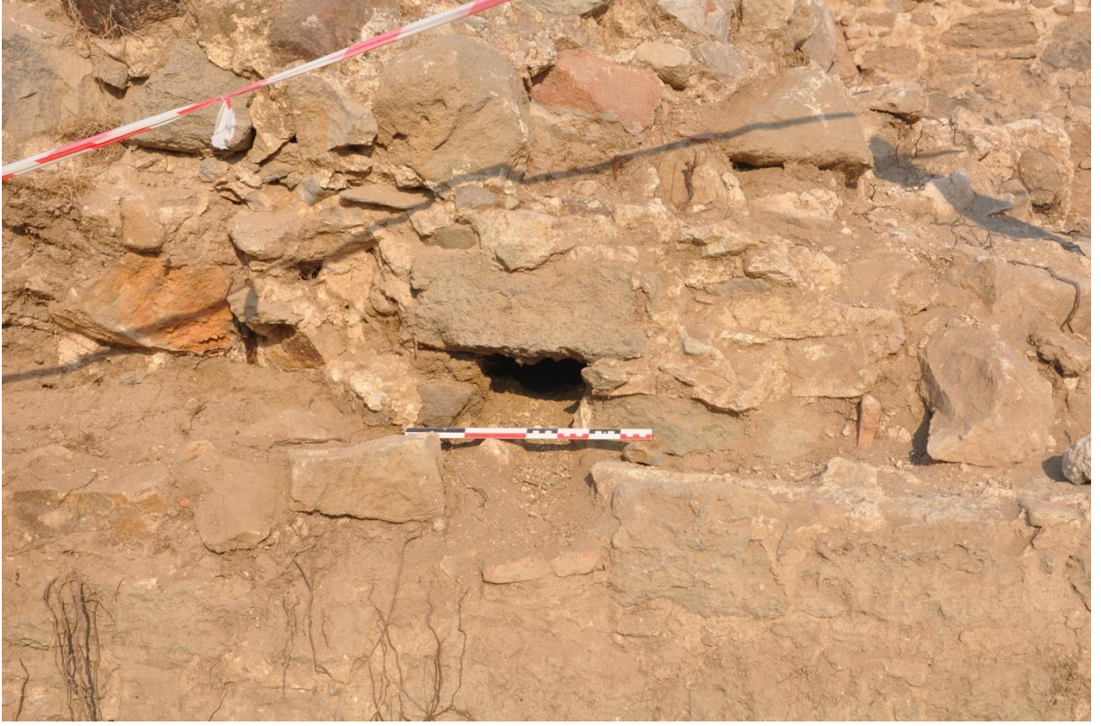
Görsel 171 – H2 Açması – Drenaj Deliđi
