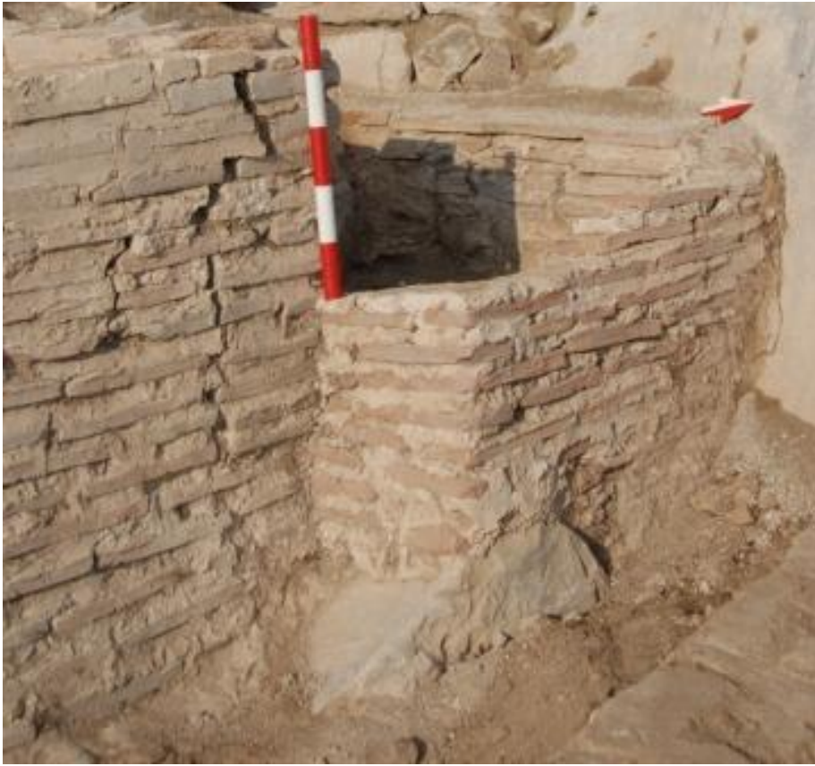
Görsel 50 – Tuğla Örgü Duvar İşçiliği (M4)
