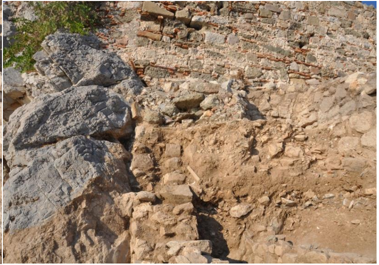
Görsel 108 – KAR-3 – Duvar Hattı
