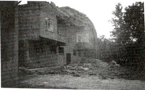
Çöken bir yapının yanındaki sarsıntıdan etkilenmeyen yapıya verdiği hasar / GÖLCÜK
