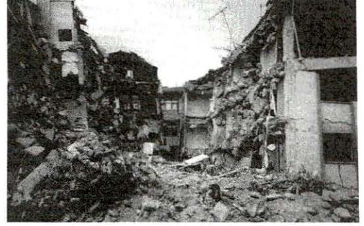
Çarpık yerleşme, kötü zemin, kötü işçilik, kalitesiz malzeme vb.nedenlerle depremin yapılarındaki hasar
