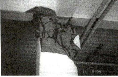
Kolon-kiriş bağlantı noktasında, donatı korozyonu ve etriye aralığının az olması nedeniyle mafsallaşma /ADAPAZARI
