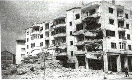
Çöken bir yapının yanındaki sarsıntıdan etkilenmeyen yapıya verdiği hasar / GÖLCÜK
