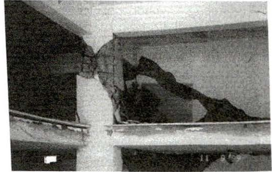
Çöken bir yapının yanındaki sarsıntıdan etkilenmeyen yapıya verdiği hasar / GÖLCÜK
