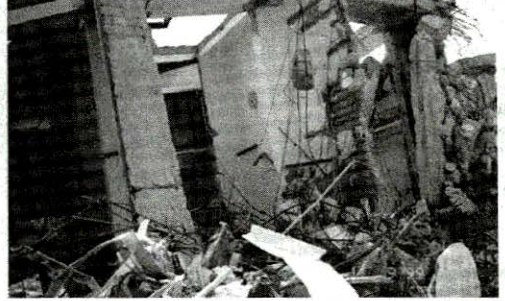
Donatılarda pas payı yetersizliği nedeniyle çelikte korozyon sonucu ağır hasar/ADAPAZARI
