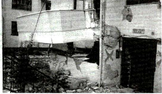
Açık çıkılmaların burulma etkisiyle yatay ve düşey taşıyıcıları zorlayarak kırılmalarına neden olmaları/ADAPAZARI
