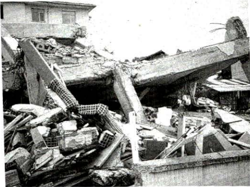
Burulma ve üst üste göçme / ULAŞLI
