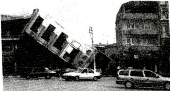
Resim 4- Bodrum kat uygulanmamış yapı örneği (Adapazarı)
