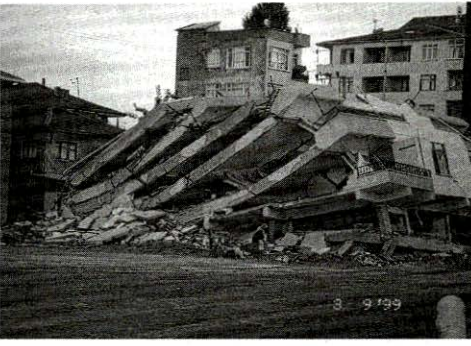
Tek yönde taşıyıcılar ve sonradan eklenmiş katların bir yöne üstüste kayması, tüm kolonların kırılması ve malzeme hatası / DERİNCE
