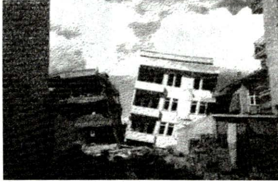
Resim 3- Bitişik düzen uygulamasına deprem etkisi (İzmit)
