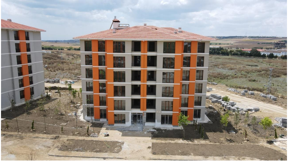
Şekil 3.18. Modellenen projenin mevcut yapı görünümü
