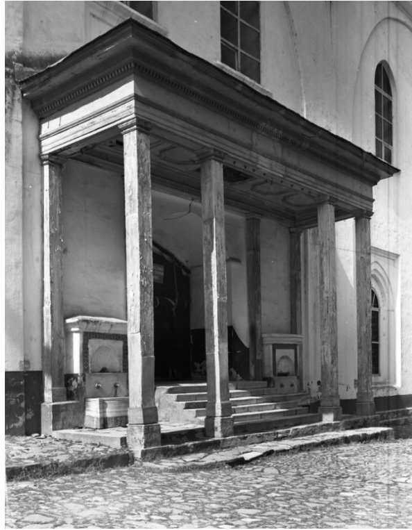
Şekil 3-18. Ulucami Doğu kapısı ahşap saçak görünümü, 1940'lı yıllar (VGM arşivi)
