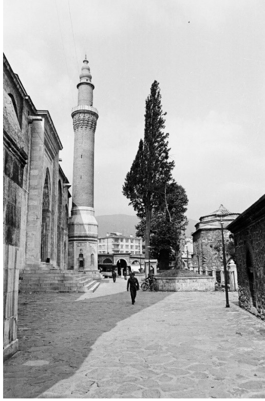
Şekil 3-60. Onarım sonrası Ulucami kuzey görünümü 1966 (VGM arşivi)
