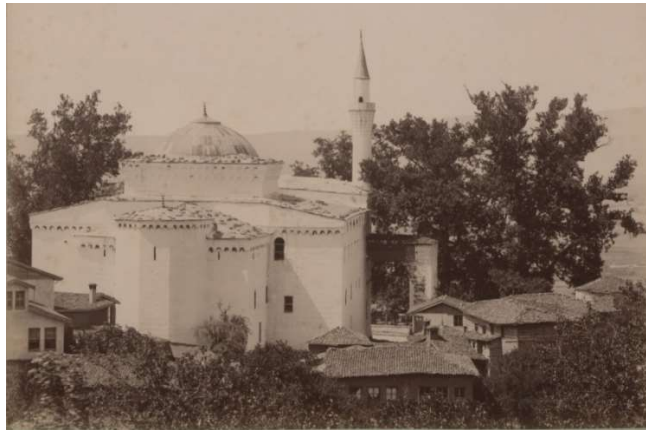
Şekil 3-90. Hüdavendigâr Camisi kurşun kaplı ahşap minare külahı görünümü (779-28-0027 / İ.Ü. NEK)
