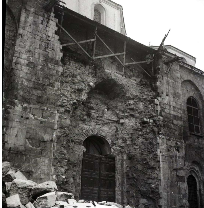
Şekil 3-44. Ulucami'nin kuzey kapısının sökülme sonrası görünümü (VGM arşivi)
