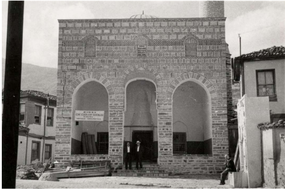
Şekil 3-129. Onarım sonrası Hacılar Camisi görünümü (www.saltresearch.org/)
