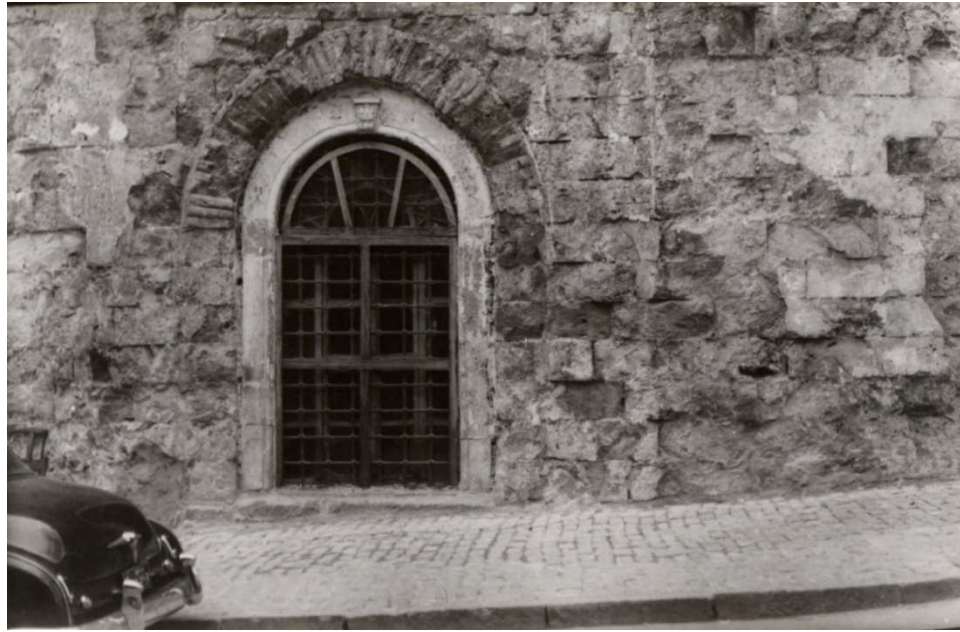
Ulucami'nin batı cephesi, tuğla kemer formu verilmiş taş kemerli pencere görünümü ( http://saltresearch.org/ 2018) (Tasuh3128062)
