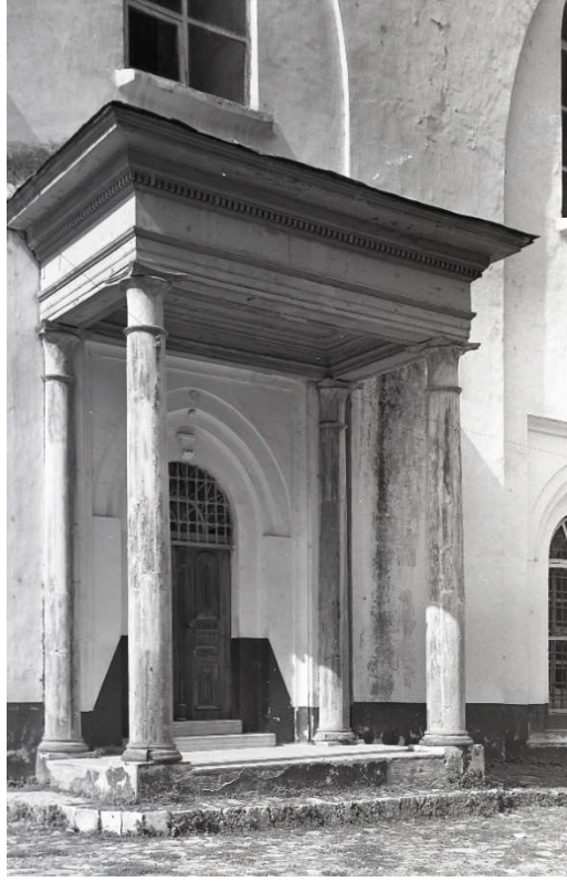
Şekil 3-17. Ulucami Doğu cephesi Hünkar kapısı ahşap saçak görünümü, 1940'lı yıllar (VGM arşivi)
