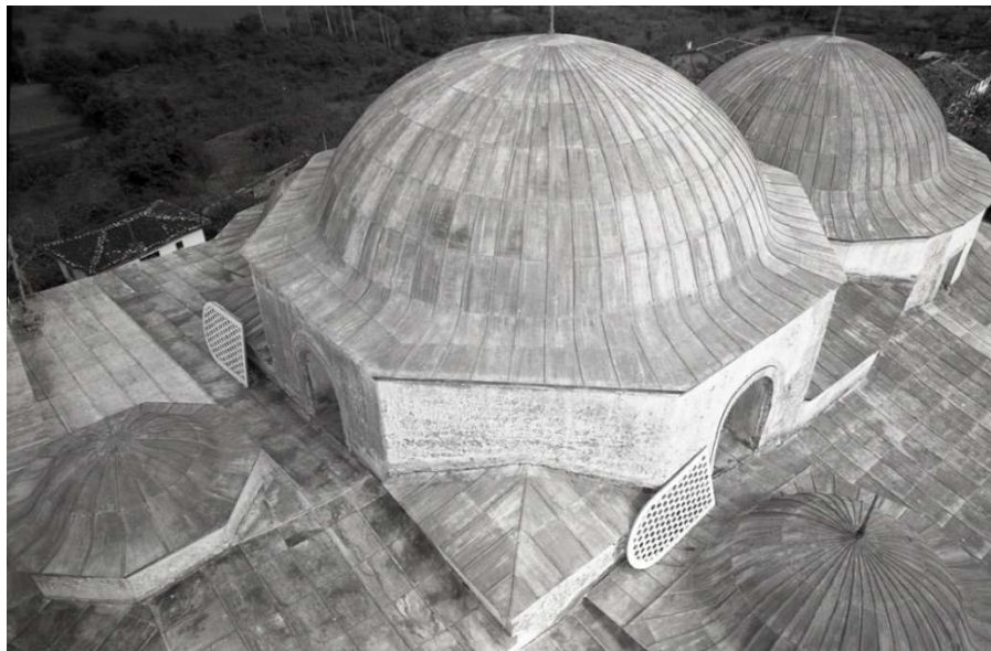
Şekil 3-117. Yıldırım Bayezid Camisi, onarım sonrası çatı görünümü (VGM arşivi)
