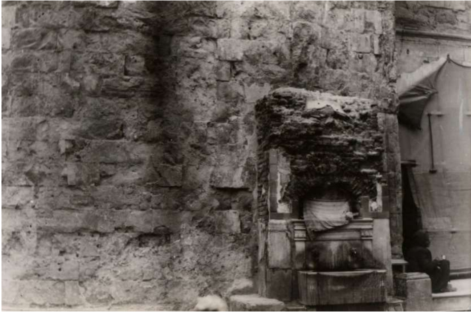
Şekil 3-38. Ulucami'nin batı kapısı yanında sonradan eklenmiş olan çeşme ( http://saltresearch.org/ ) [Tasuh3128007]
