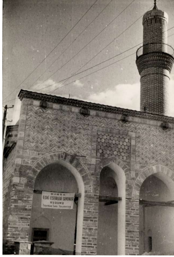
Şekil 3-135. Bedrettin Camisi'nin onarım sonrası görünümü (1956 yılı) (www.saltresearch.org/) [Tasuh60674]
