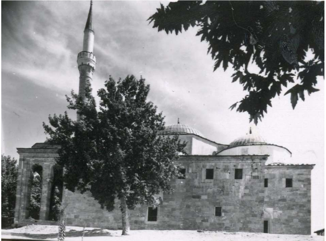
Şekil 3-113. Yıldırım Bayezid Camisi görünümü (1948) (VGM arşivi)
