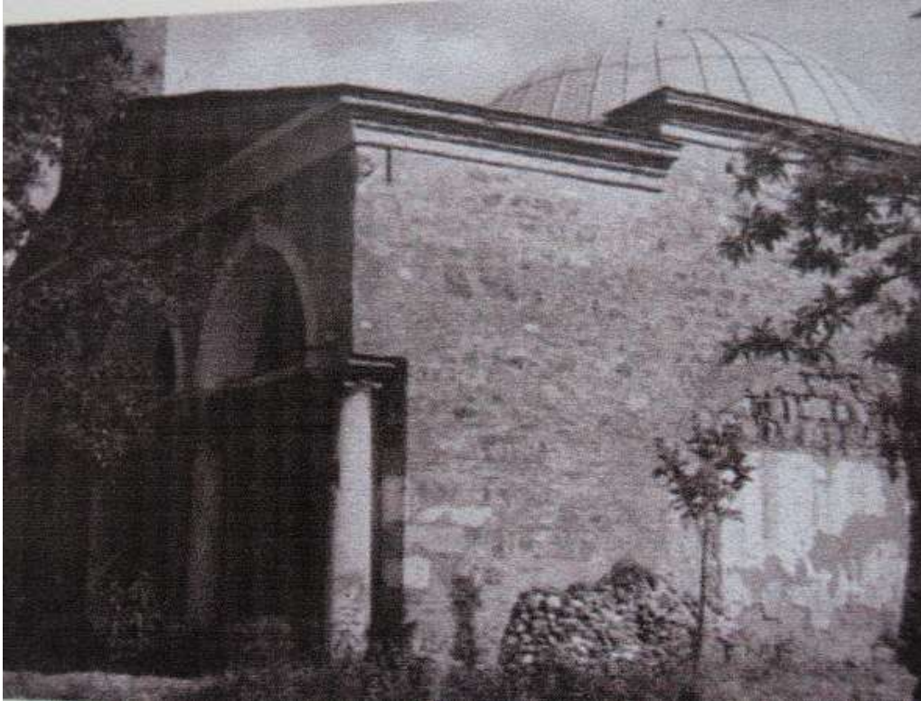
Şekil 3-145. Alaaddin Bey Cami onarım öncesi görünümü (BEESK arşivi)
