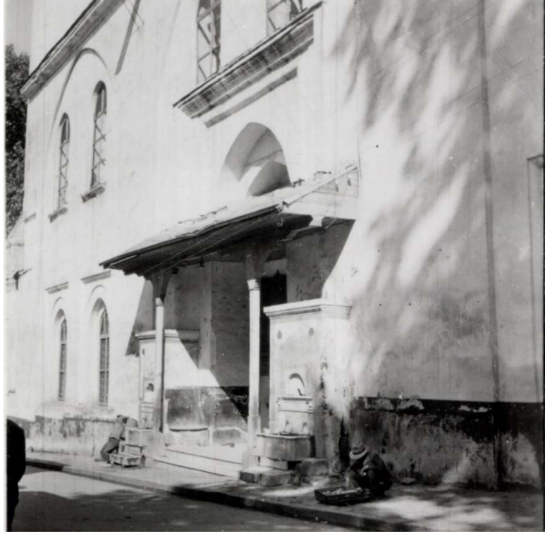
Şekil 3-19. Ulucami batı kapısı saçak görünümü, 1940'lı yıllar ( http://saltresearch.org/ ) [Tasuh5824002]
