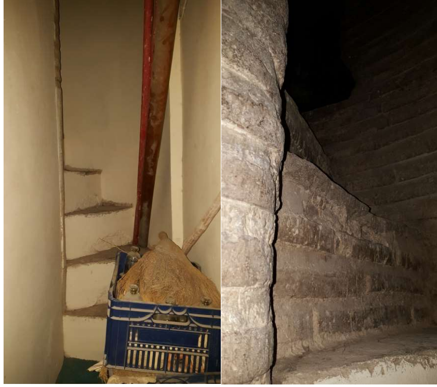
Şekil 3-72. Yeşil Cami doğu minaresi merdiveninin görünümü (2016)
