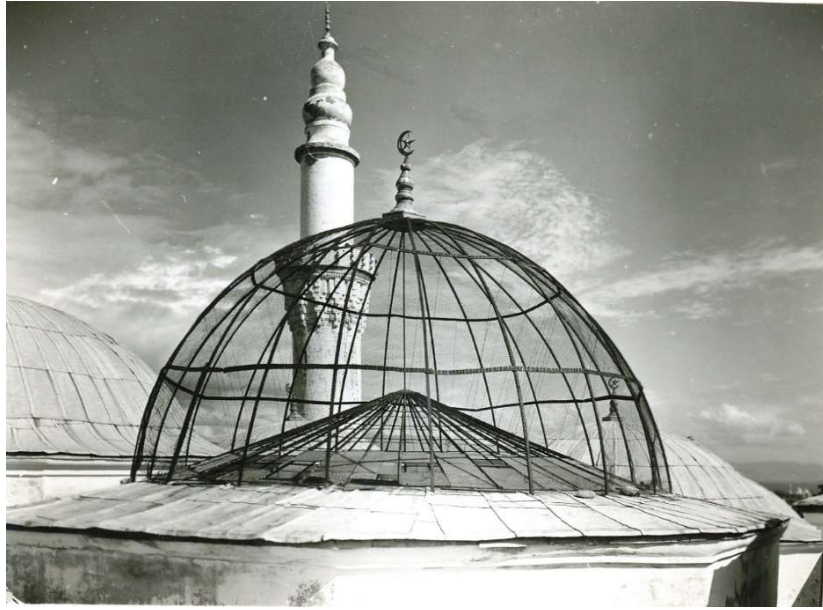
Ulucami içerisinde bulunan şadırvanın üzerindeki kubbenin demir kafesinin görünümü (VGM arşivi)
