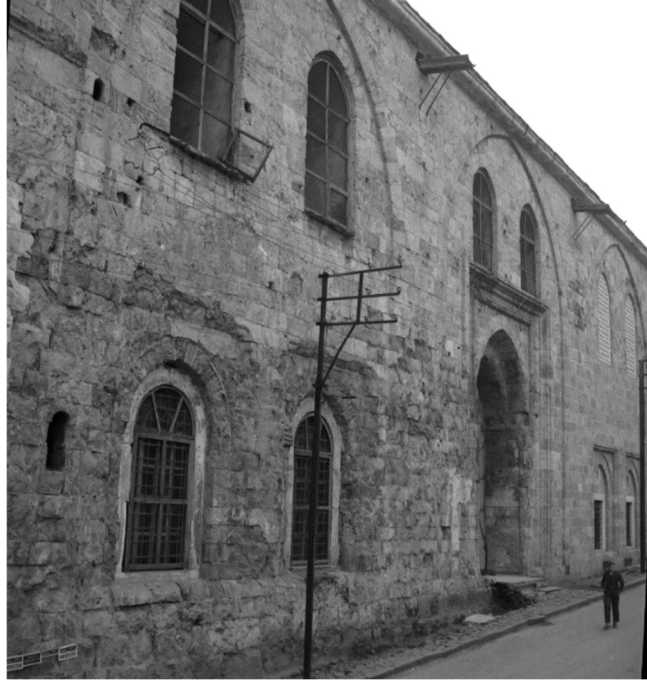
Şekil 3-39. Sıva raspası ve çeşmelerin sökümü sonrası Ulucami'nin batı cephesi görünümü (VGM arşivi)
