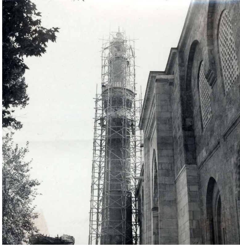
Şekil 3-63. Ulucami doğu minaresi onarımı (VGM arşivi)
