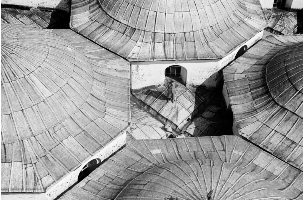
Ulucami'nin çatı görünümü (VGM arşivi)
