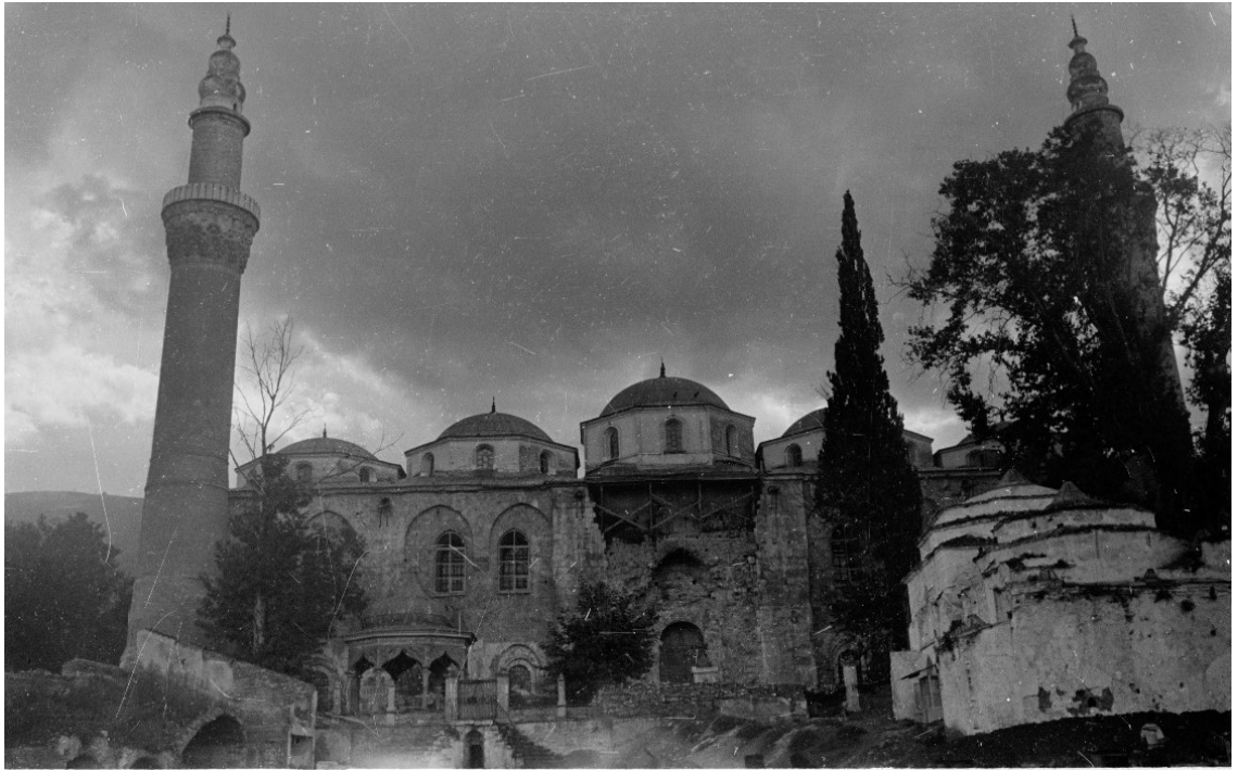
Şekil 3-41. Kuzey kapısının sökümü sırasında Ulucami görünümü (Kemali Söylemezoğlu arşivi. http://saltresearch.org/ ) [Tsoh294003]
