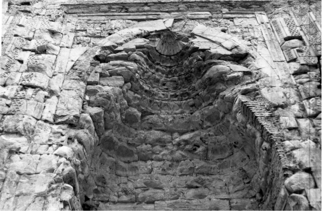
Şekil 3-33. Sıva sökümü sonrası Ulucami'nin kuzey kapısı bezeme görünümü (VGM arşivi)
