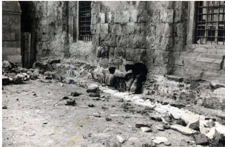
Şekil 3-58. Ulucami onarım çalışmaları (VGM arşivi)
