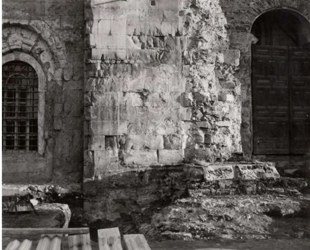
Şekil 3-51. Kuzey kapısında yapılan söküm ve özgün bahçe kotunun tespiti (Erişim adresi: http://saltresearch.org/ 2018) [Tasuh3128089]
