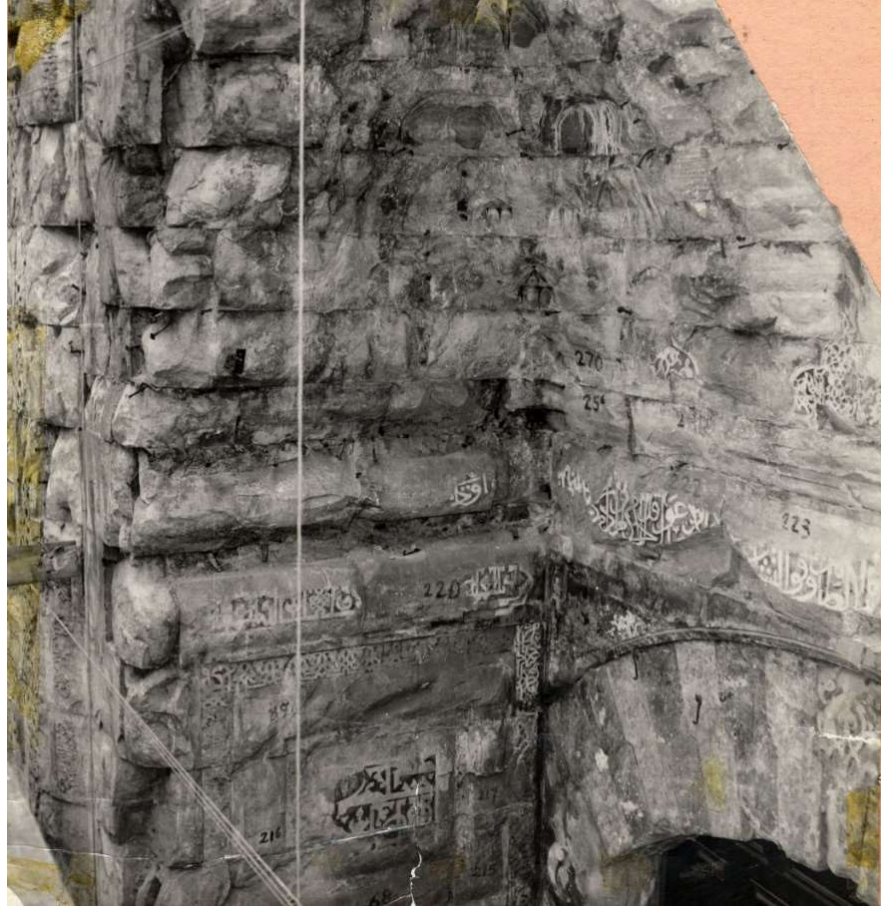
Şekil 3-30. Ulucami'nin kuzey kapısının sökülme öncesi numaralandırılan taşların görünümü (1955) (VGM arşivi)
