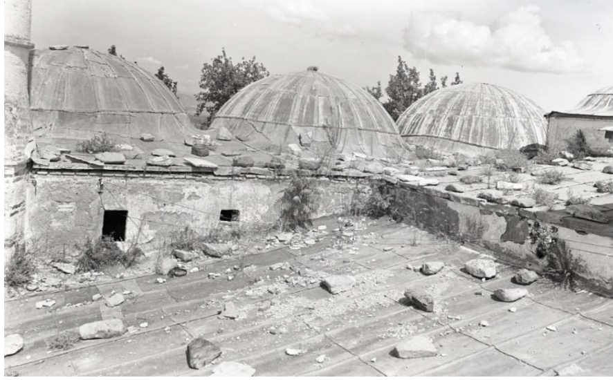
Şekil 3-116. Yıldırım Bayezid Camisi onarım öncesi çatı görünümü (1940-1948) (VGM arşivi)
