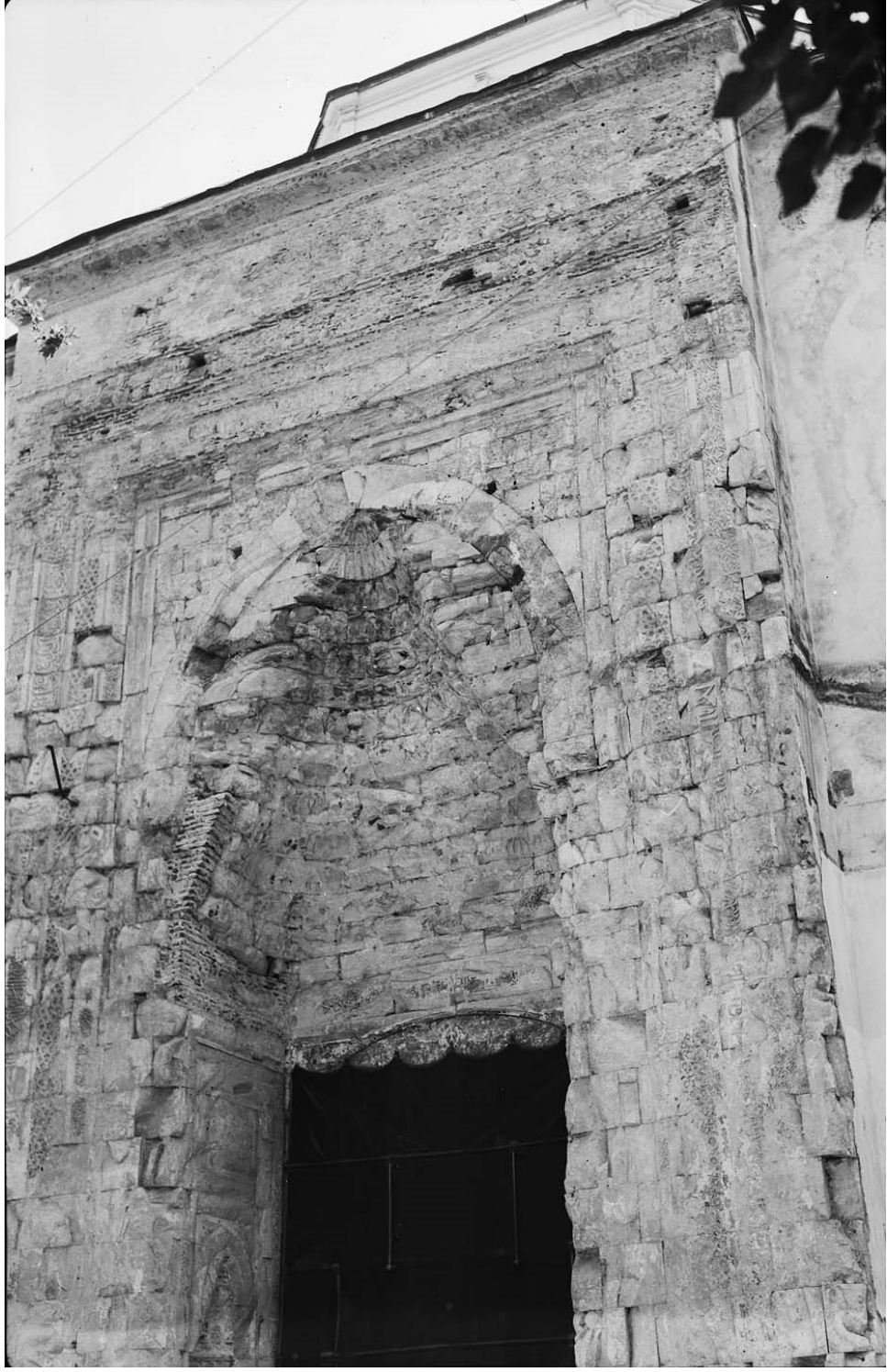
Şekil 3-21. Sıva sökümü sonrası Ulucami'nin kuzey kapısı görünümü ( https://www.pop.culture.gouv.fr/ )
