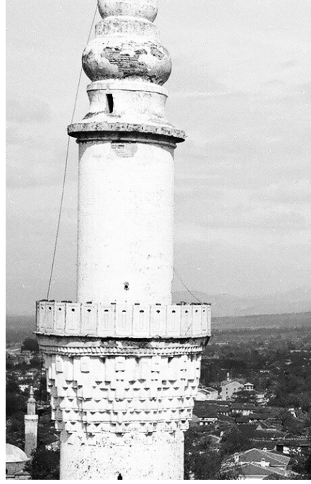
Ulucami'nin minaresinin, sıvaları dökülmüş olan tuğla külâhının görünümü (VGM arşivi)
