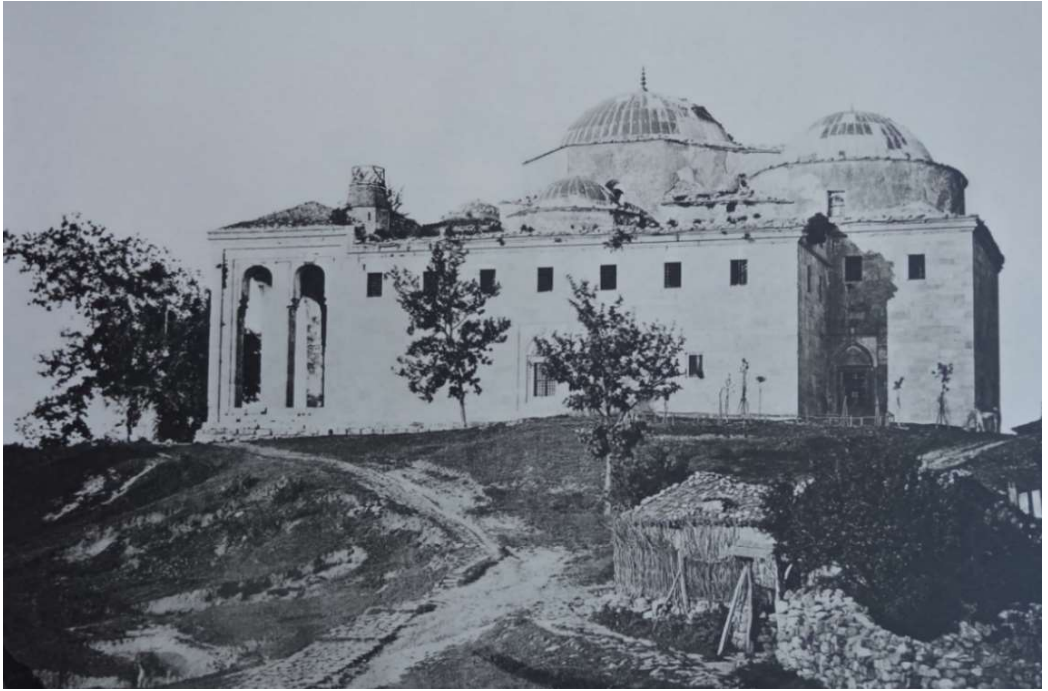
Şekil 3-106. 1886 yılı, Yarbay Ahmet tarafından çekilen fotoğrafta, Yıldırım Bayezid Camisi'nin deprem sonrası yıkılan minare görünümü (Eren, 2011)
