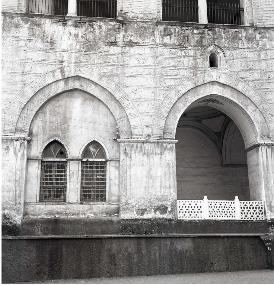
Şekil 3-98. Kapatılmış revak görünümü (VGM arşivi)
