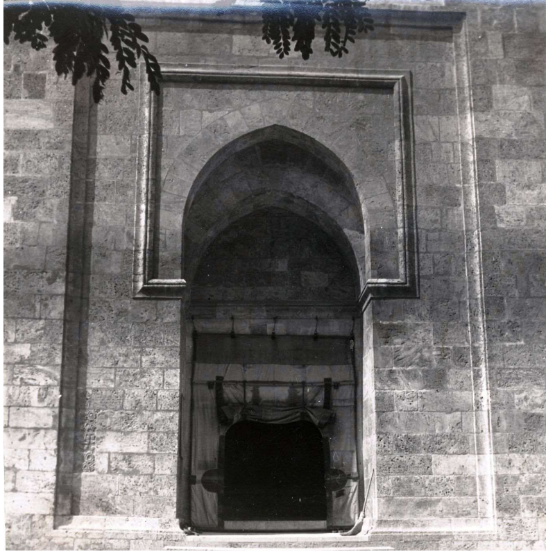
Şekil 3-62. Onarım sonrası Ulucami doğu kapısı görünümü (VGM arşivi)
