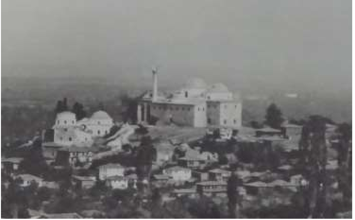
Şekil 3-107. 1855 depremi sonrası onarılan Yıldırım Bayezid Camisi'nin görünümü (1886-1890) (Eren, 2011)
