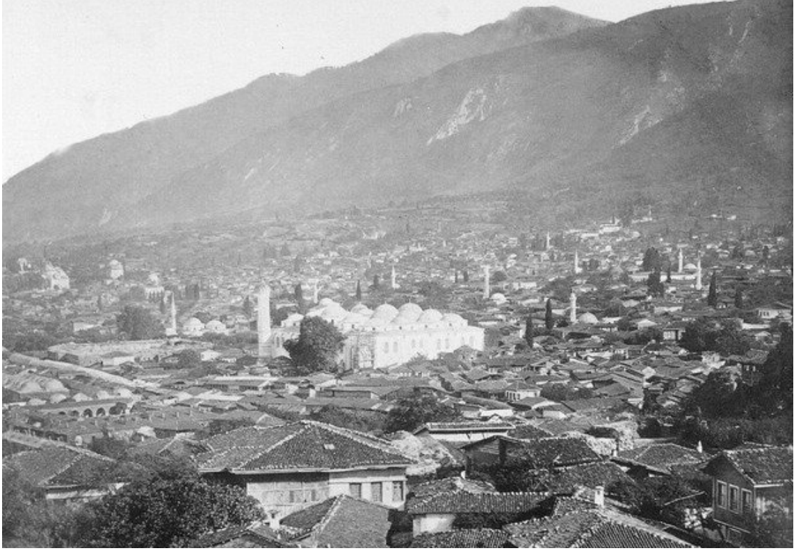
Şekil 3-8. Ulucami'nin 1855 depremi sonrası yıkılmış olan minarelerin görünümü (1962 yılı) (Özendes, 1999)
