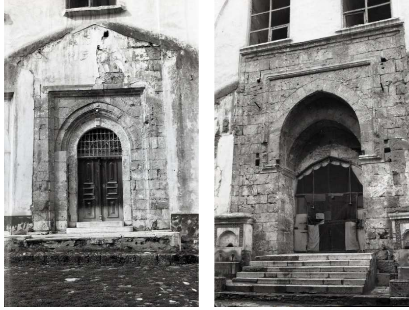
Şekil 3-24. Saçağın sökülmesi sonrası Ulucami'nin Hünkar kapısı ve doğu kapısı görünümü (1950'li yıllar) (VGM arşivi)
