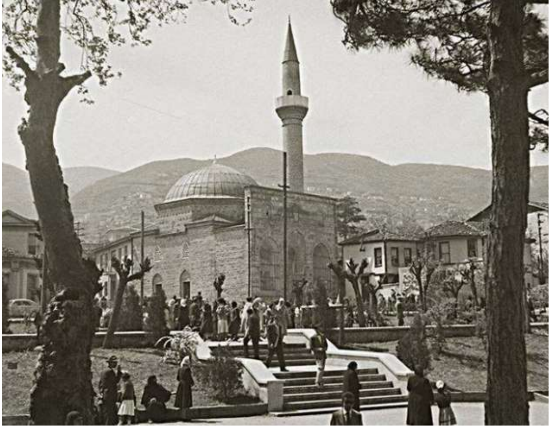
Şekil 3-131. Hacılar Camisi onarım sonrası görünümü (BEESK arşivi)
