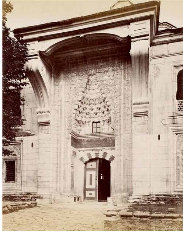
Şekil 3-77. Yeşil Cami giriş saçağı görünümü (Berggren, Guillaume) (1875-.) ( https://rosettaapp.getty.edu/ )
