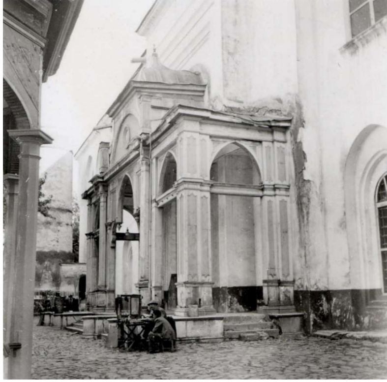
Şekil 3-15. 1940'lı yıllarda Ulucami kuzey kapısı saçak görünümü ( http://saltresearch.org/ )
