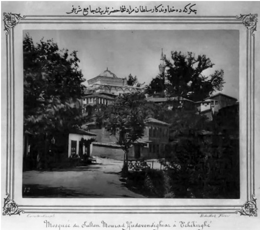
Şekil 3-88. Hüdevendigar Cami, 1880-1893 yılları arası minare ahşap külâhının görünümü ( http://www.loc.gov )
