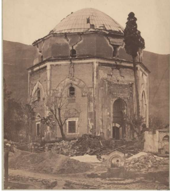
Şekil 2-4. Yeşil Türbe’de 1855 depremi sonrası oluşan hasarın görünümü, Parvillée'nin arşivinde yer alan fotoğrafı (Parvillée, tahm. 1863) ( www.pop.culture.gouv.fr )
