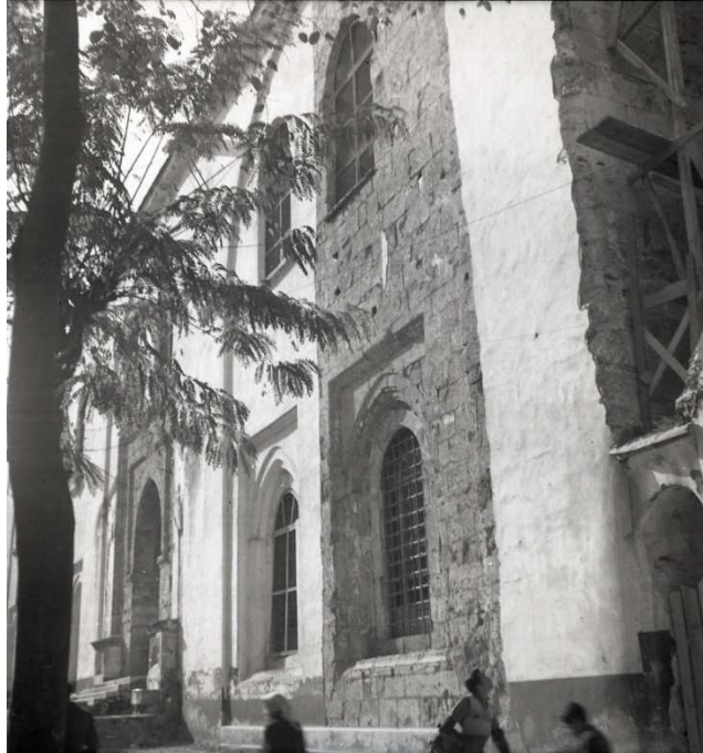
Şekil 3-40. Ulucami'nin doğu cephesi sıva raspası çalışmaları (VGM arşivi)
