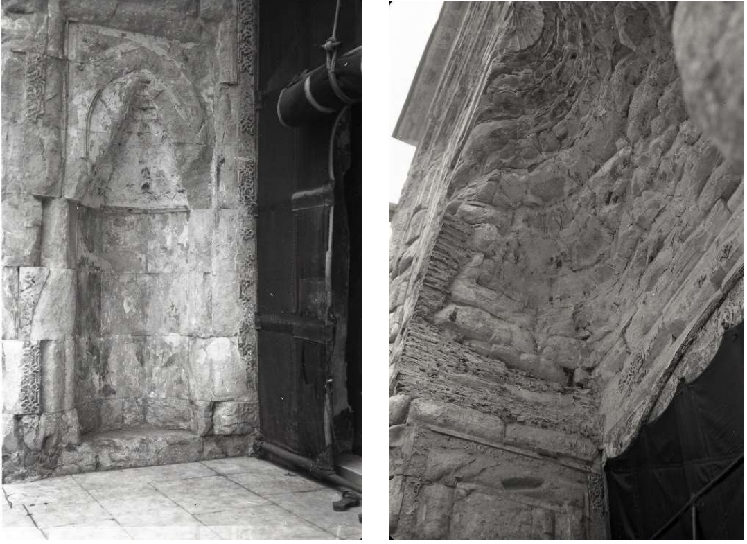
Şekil 3-32. Ulucami'nin sıva sökümü sonrası Kuzey kapısı görünümü (VGM arşivi)
