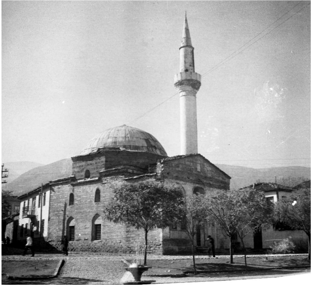
Şekil 3-130. Onarım öncesi Hacılar Camisi görünümü (www.saltresearch.org/)
