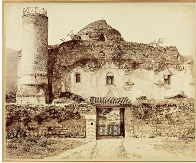
Şekil 2-5. Şehadet Camisi’nin 1855 depreminde yıkılan minare ve son cemaat yeri görünümü (Abdülhamit II. tahm. 1856-1891) [NEKYA90752/14] 1
