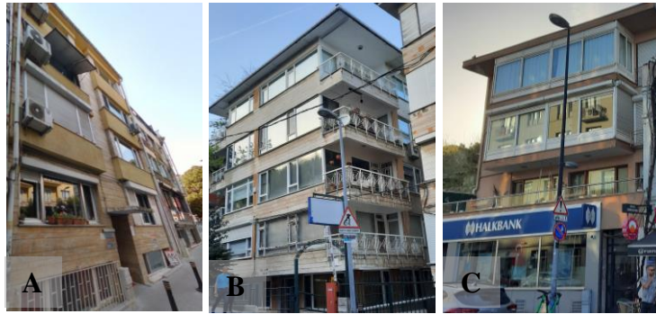
Şekil 4.37. 1970-1976 yapıları balkon örnekleri A) yalın kâgir B) yalın metal profil C) değiştirilmiş metal profil (Fotoğraf: Betül Merve Pişkin, 2022)
