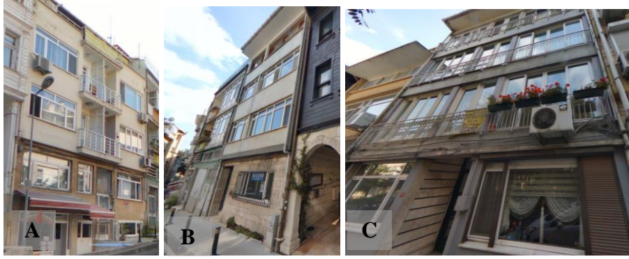
Şekil 4.33. 1950-1966 yapıları cephe kaplamaları örnekleri A) traverten taş B) taş C) mozaik (Fotoğraf: Betül Merve Pişkin, 2022)
