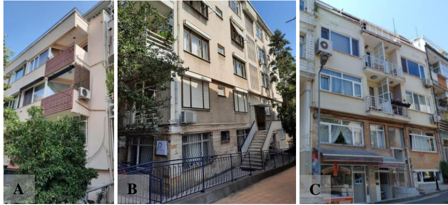
Şekil 4.35. A) kâgir balkon süslemesi B) pencere üstü geometrik eleman C) traverten kaplama (Fotoğraf: Betül Merve Pişkin, 2022)
