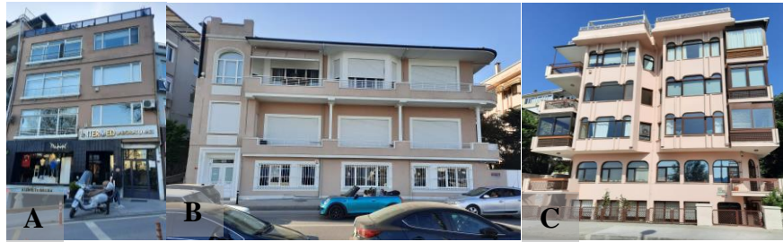
Şekil 4.28. 1937-1950 yapıları cephe örnekleri A) yalın B) eğrisel çıkmalı C) çokgen çıkmalı (Fotoğraf: Betül Merve Pişkin, 2022)
