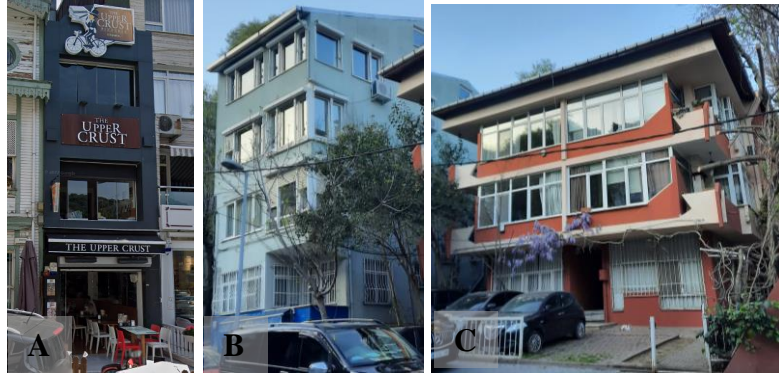
Şekil 4.36. 1970-1976 yapıları değerlendirme A) doku ile uyumlu konut B) doku ile uyumlu konut C) nitelikli özgün modern konut (Fotoğraf: Betül Merve Pişkin, 2022)
