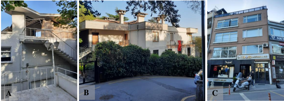
Şekil 4.17. Kat sayısı yapı örnekleri. A) üç katlı yapı B) dört katlı yapı C) beş katlı yapı (Fotoğraf: Betül Merve Pişkin, 2022)
