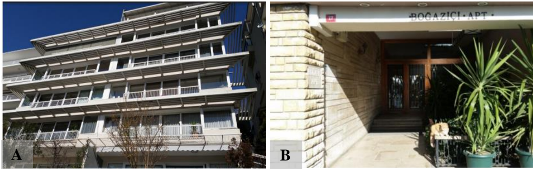
Şekil 4.75. Boğaziçi apartmanı A) cephe B) kapı (Özkul, 2016)
