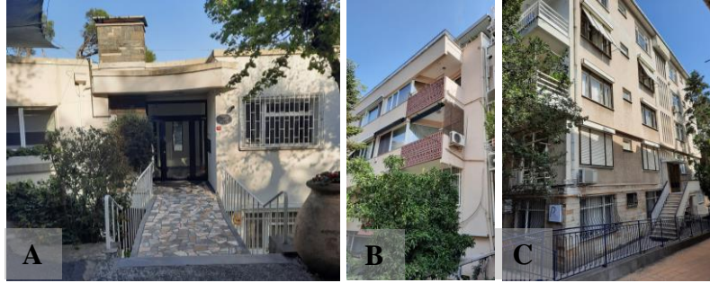
Şekil 4.84. Yapısal müdahaleler A) Basit bakım ve onarım (ay14) B) Niteliksiz ek temizleme (ku29) C) Basit bakım, onarım ve niteliksiz ek temizleme(ku32) (Fotoğraf: Betül Merve Pişkin, 2022)
