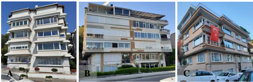
Şekil 4.46. Cephe elemanları değişmesi ve ek kat ilavesi nedeni ile değişmiş yapı örnekleri. A) Ay1 (az değişmiş) B) C9 (kısmen değişmiş) C) Ku34 (az değişmiş) (Fotoğraf: Betül Merve Pişkin, 2022)
