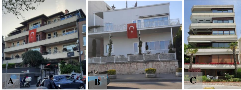
Şekil 4.26. Çatı tipi. A) saçaklı B) teras alınlıklı C) teras parapetli (Fotoğraf: Betül Merve Pişkin, 2022)
