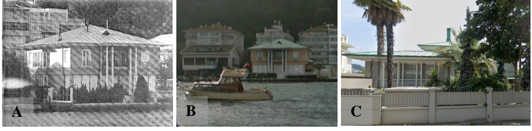
Şekil 4.59. Nuri Çapa Yalısı A) deniz cephesi (Tanyeli, 2005) B) deniz cephesi C) yol cephesi (İbb, 2019)
