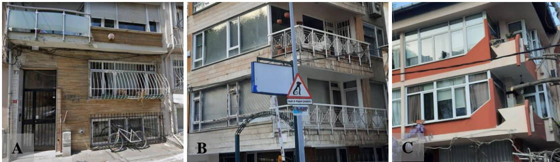
Şekil 4.39. 1970-1976 yapıları dış cephe A) cephe kaplaması B) cephe kaplaması C) geometrik eleman (Fotoğraf: Betül Merve Pişkin, 2022)
