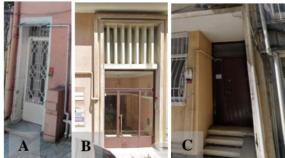
Şekil 4.32. 1950-1966 yapıları kapı örnekleri A) tek kanatlı, metal camlı B) çift kanatlı, metal camlı C) tek kanatlı ahşap (Fotoğraf: Betül Merve Pişkin, 2022)
