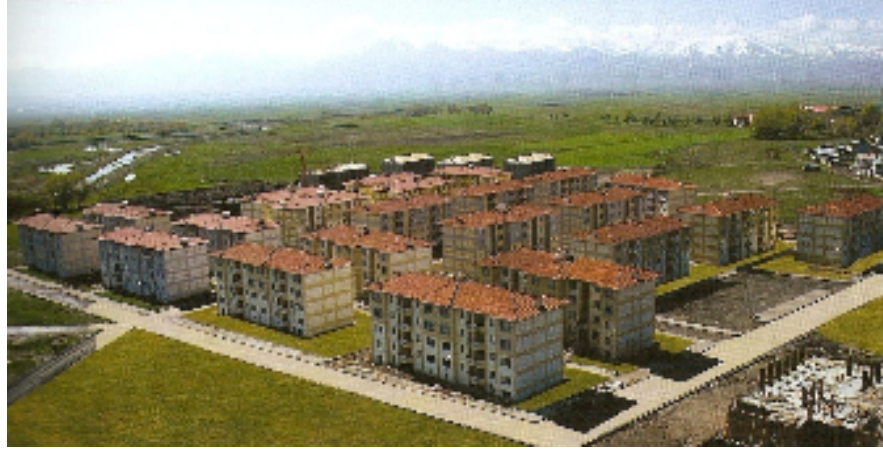
Şekil 4.7. Erzurum, Ilıca’da Afet Konutu Uygulaması (TOKİ 2009)
