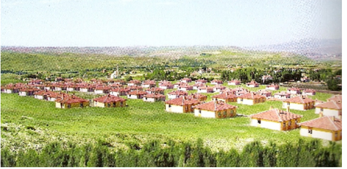
Şekil 4.9. Çankırı, İnancıköy’de Tarımköy Uygulaması (TOKİ 2009)
