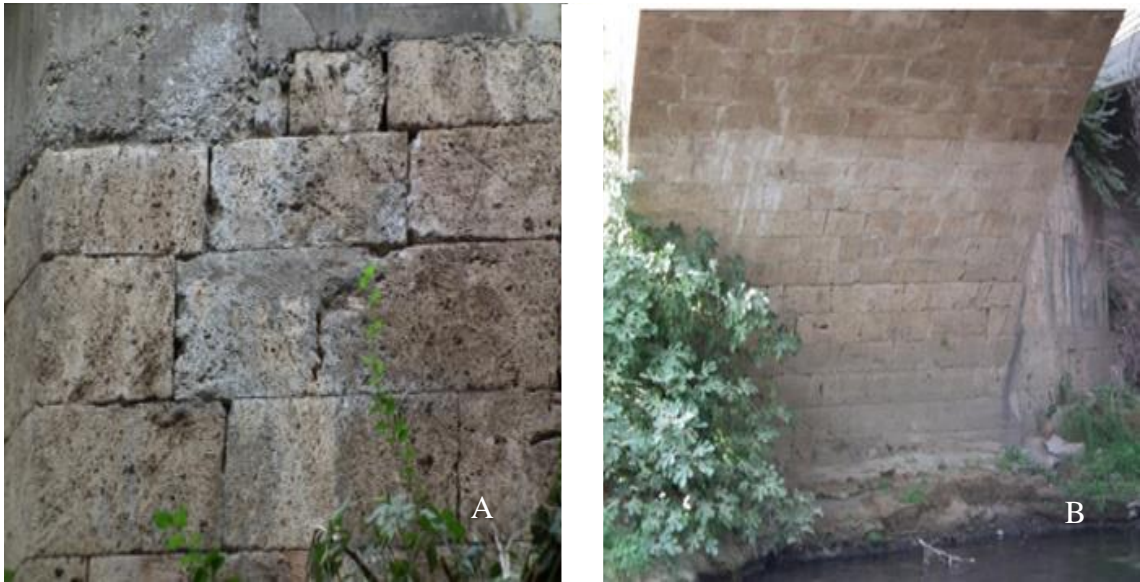
Şekil 3.37. Tarihi Geçit Köprüsünde kullanılan taşların a) yakından görüntüsü b) uzaktan görüntüsü (Anonim 2014)
