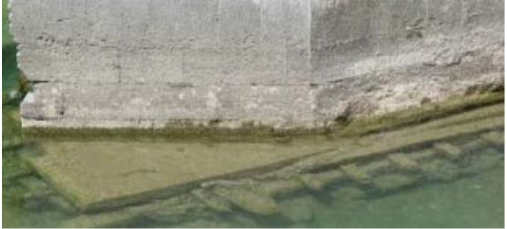
řekil 3.6. Konjic Kprs inřa edilirken temel kısmında kullanılan ahřap ızgara grseli (Sert ve ark. 2009)
