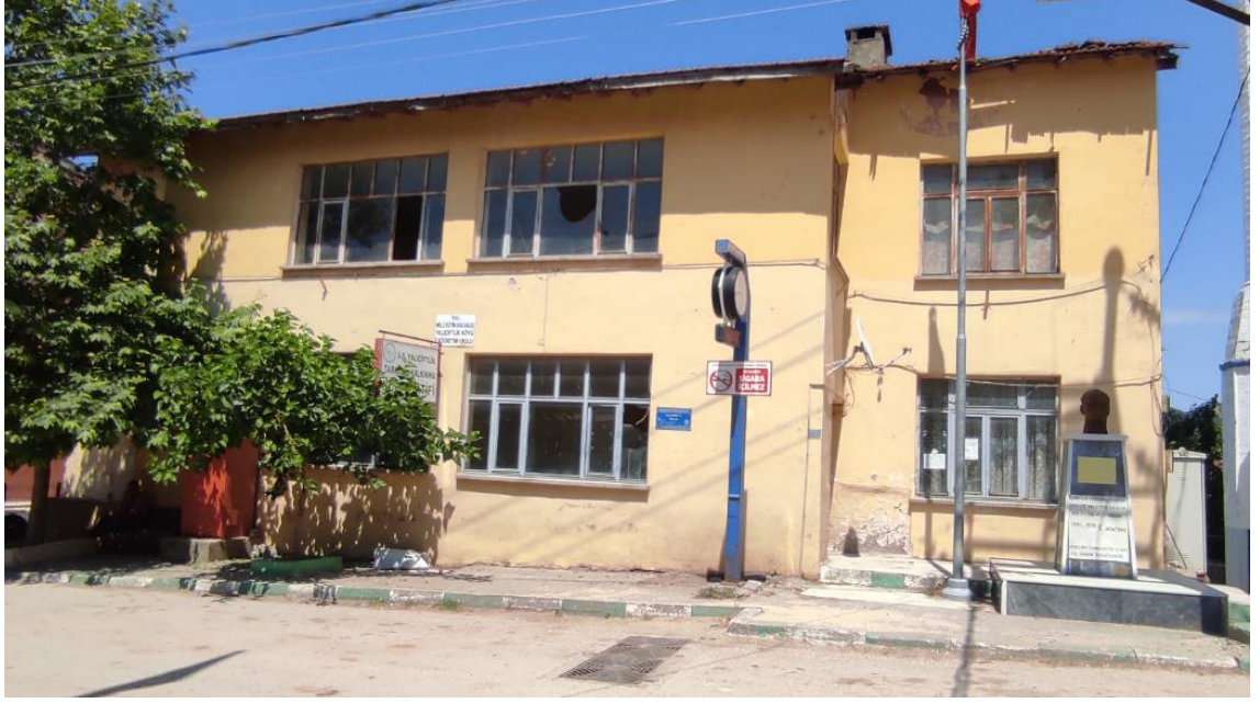
Şekil 4.63. Mudanya Yalıçiftlik Köyü İlkokulu binası güncel durumu (Bozkan, 2022)
