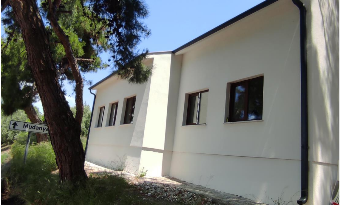
Şekil 4.69. Mudanya Yaylacık Köyü İlkokul binası güncel durumu (Bozkan, 2022)
