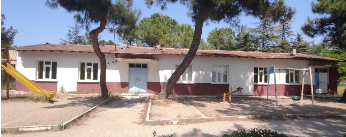
Şekil 4.33. Mudanya Dereköy İlkokulu binası güncel durumu (Bozkan, 2022)
