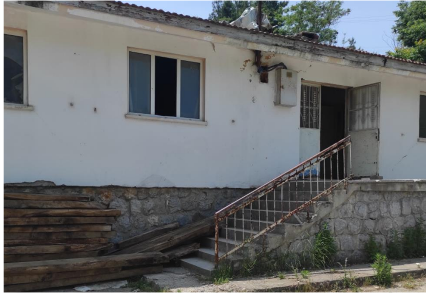
Şekil 4.13. Mudanya Aydınpınar Köyü okul binası giriş merdiveni ve kapısı (Bozkan, 2022)
