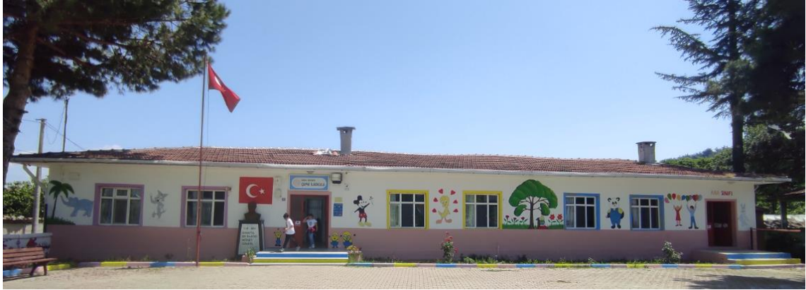
Şekil 4.22. Mudanya Çepni İlkokulu binası güncel durumu (Bozkan, 2022)
