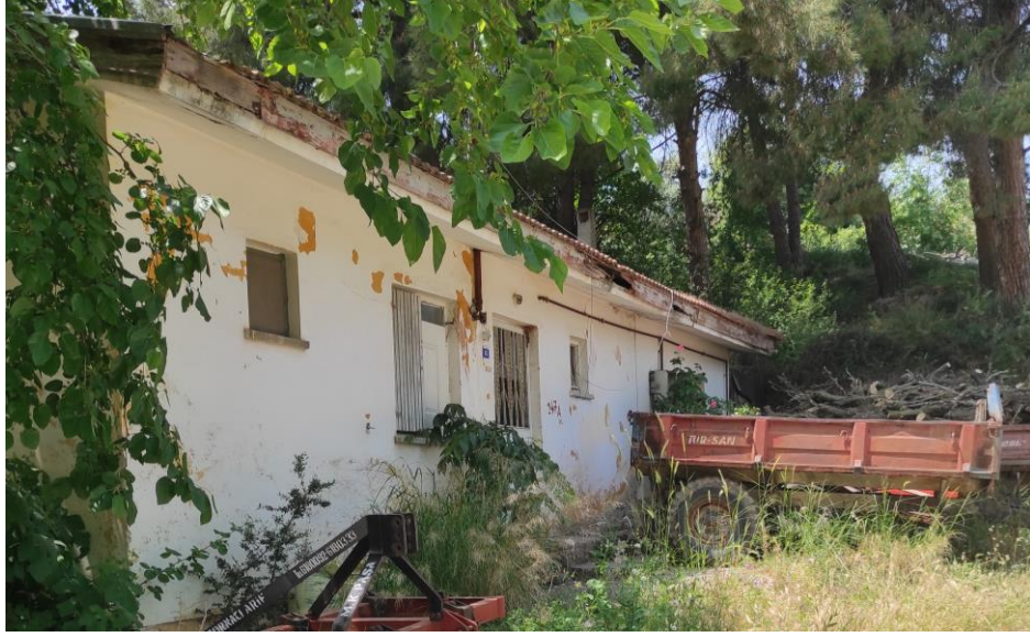
Şekil 4.12. Mudanya Aydınpınar Köyü lojman binası güncel durumu (Bozkan, 2022)
