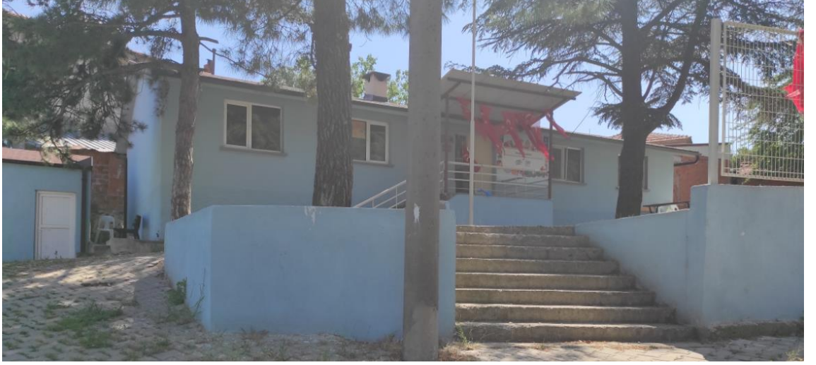
Şekil 4.57. Mudanya Kaymakoba İlkokulu binası güncel durumu (Bozkan, 2022)
