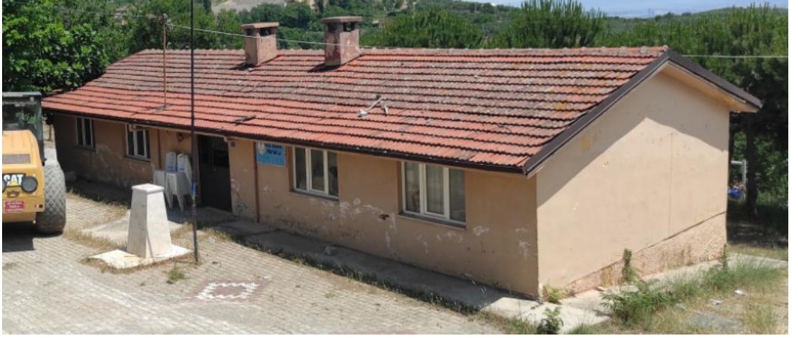
Şekil 4.51. Mudanya İpekyayla İlkokulu binası güncel durumu (Bozkan, 2022)
