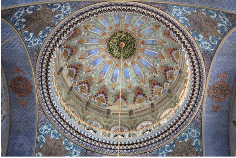
Fotoğraf 242: Pertevniyal Valide Sultan Camii (Aksaray) kubbesinin içten görünümü
