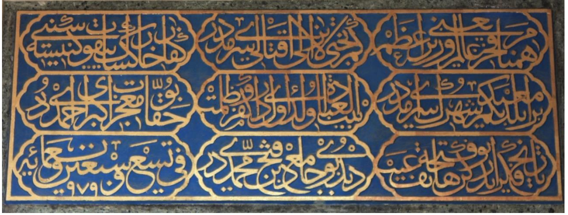
Fotoğraf 275: Sokullu Şehid Mehmed Paşa Camii mihrap eksenindeki avlu kapısı alınlığında inşa kitabesi.
