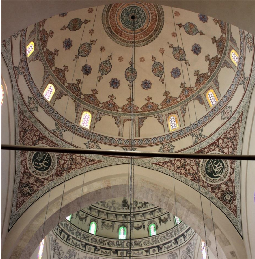
Fotoğraf 194: Mahmud Paşa Camii kubbelerinin içten görünümü.
