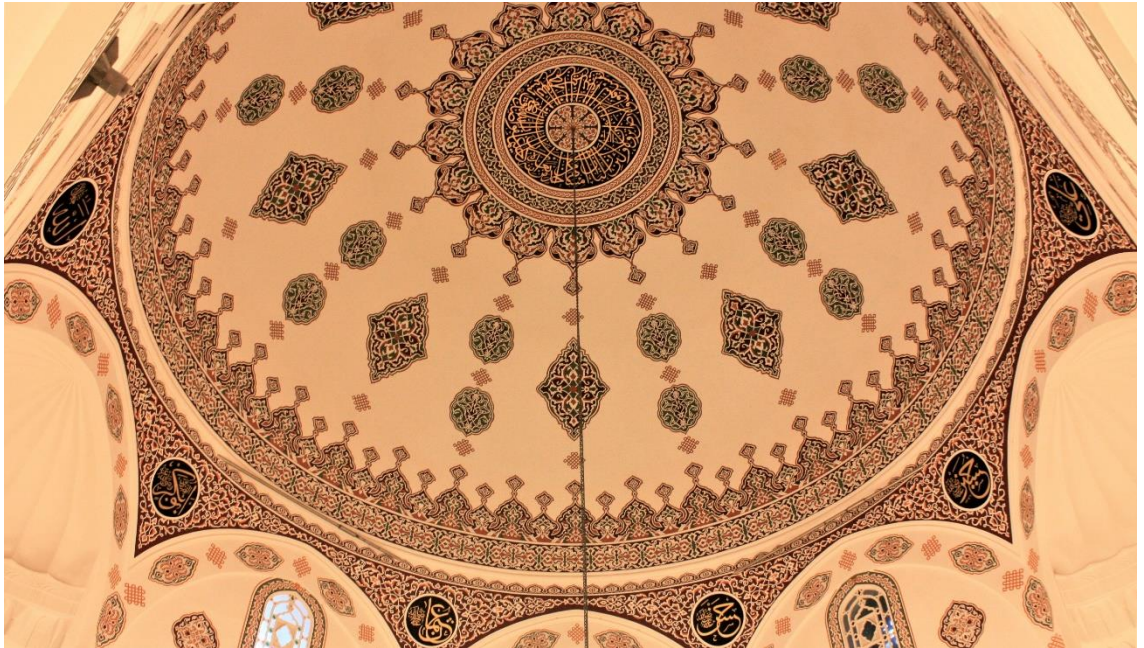
Fotoğraf 247: Piri Mehmed Paşa Camii (Silivri) kubbesinin görünümü
