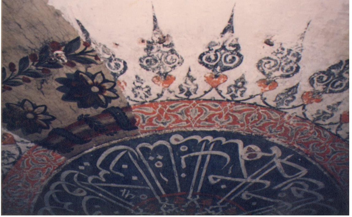
Fotoğraf 254: Rüstem Paşa Camii 1992-1995 restorasyonu rıspasında kubbe yazısı ve çevre süslemesinin durumu (İsmail Önel arşivi)
