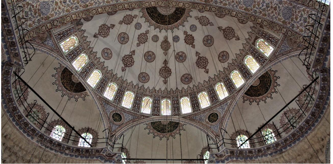
Fotoğraf 296: Sultan Ahmed Camii doğu yarım kubbe ve eteklerinde daha küçük yarım kubbelerin görünümü
