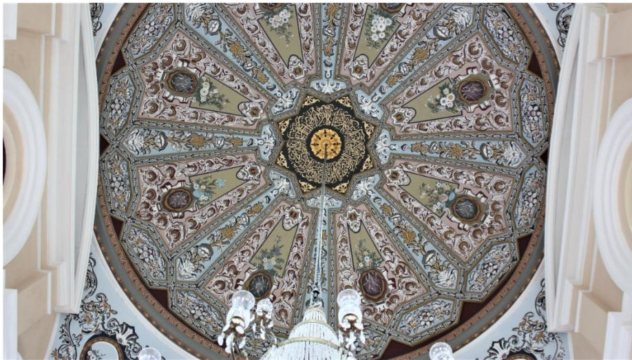
Fotoğraf 261: Sadabad Camii kubbесinin içten görünüşü.
