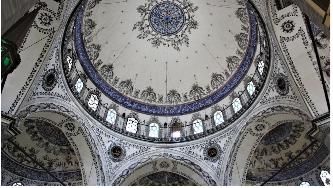
Fotoğraf 131: Hekimoğlu Ali Paşa Camii giriş cephesi yarım kubbelerinin içten görünümü.
