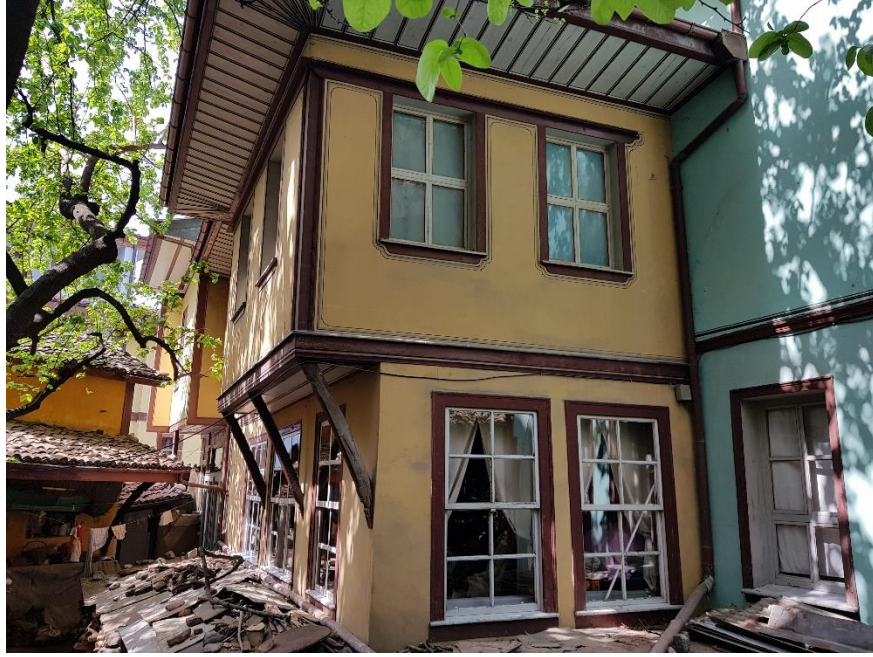
Fotoğraf 26: Numaniye Dergâhı harem bölümü batı cephesi
