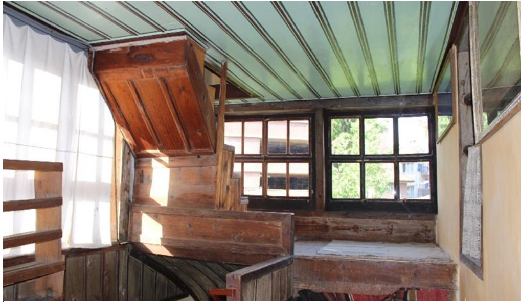
Fotoğraf 35: Numaniye Dergâhı tevhidhaneye açılan geçiş alanı ve kadınlar mahfiline çıkan merdiven
