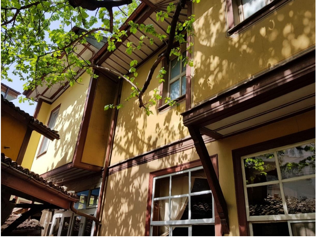
Fotoğraf 28: Numaniye Dergâhı harem bölümü batı cephesi
