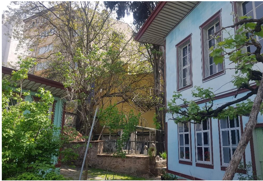
Fotoğraf 16: Numanîye Dergâhı harem bölümü doğu cephesi
