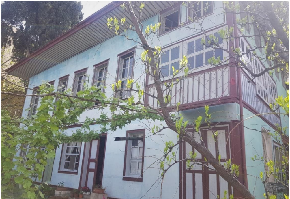
Fotoğraf 14: Numaniye Dergâhı harem bölümü doğu cephesi
