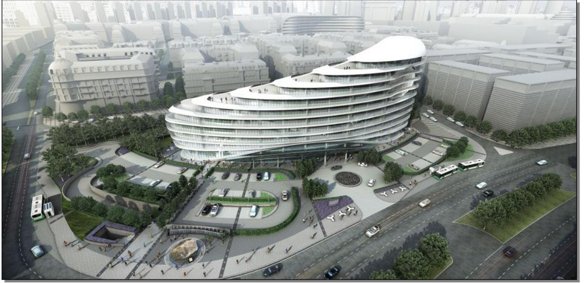
Şekil 3.15. Beyaz şehir ofis binası (Anonim, 2014b)
