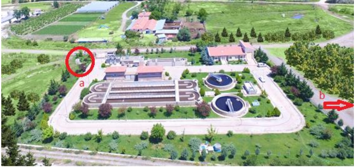
Şekil 3.2. Kalecik Atık su Arıtma Tesisi
